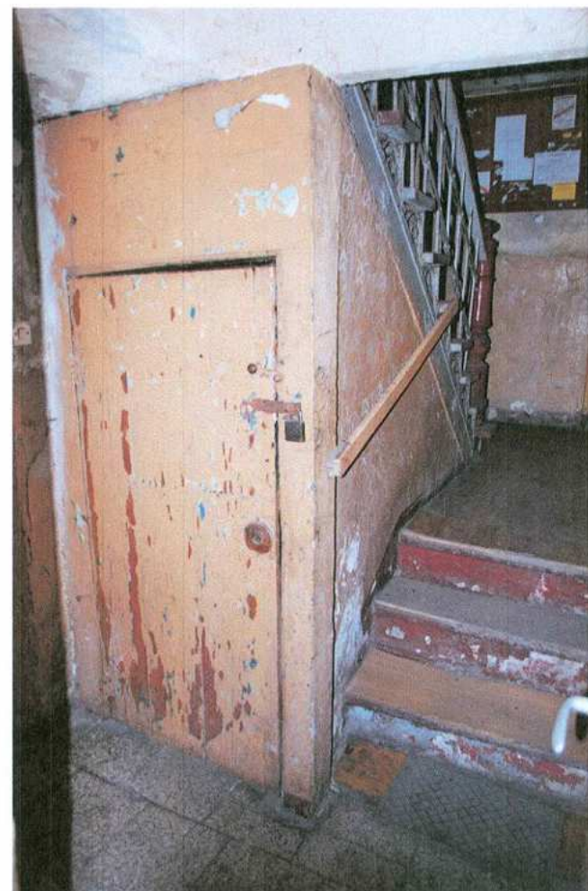
10. Wejście do piwnicy
