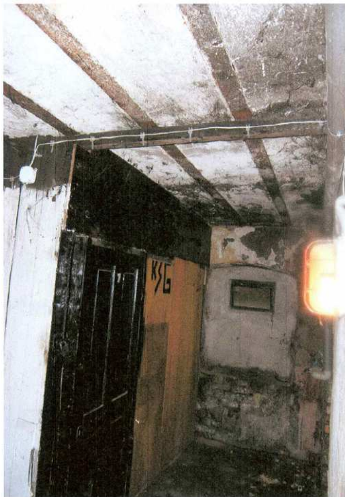
29. Korytarz piwnicy od strony Placu Jana Pawła II
