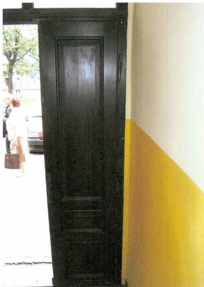
17. Stolarka drzwi wejściowych – strona wewnętrzna
