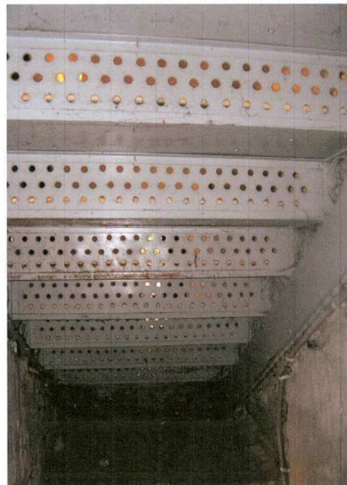
20. Podstopnice schodów klatki schodowej
