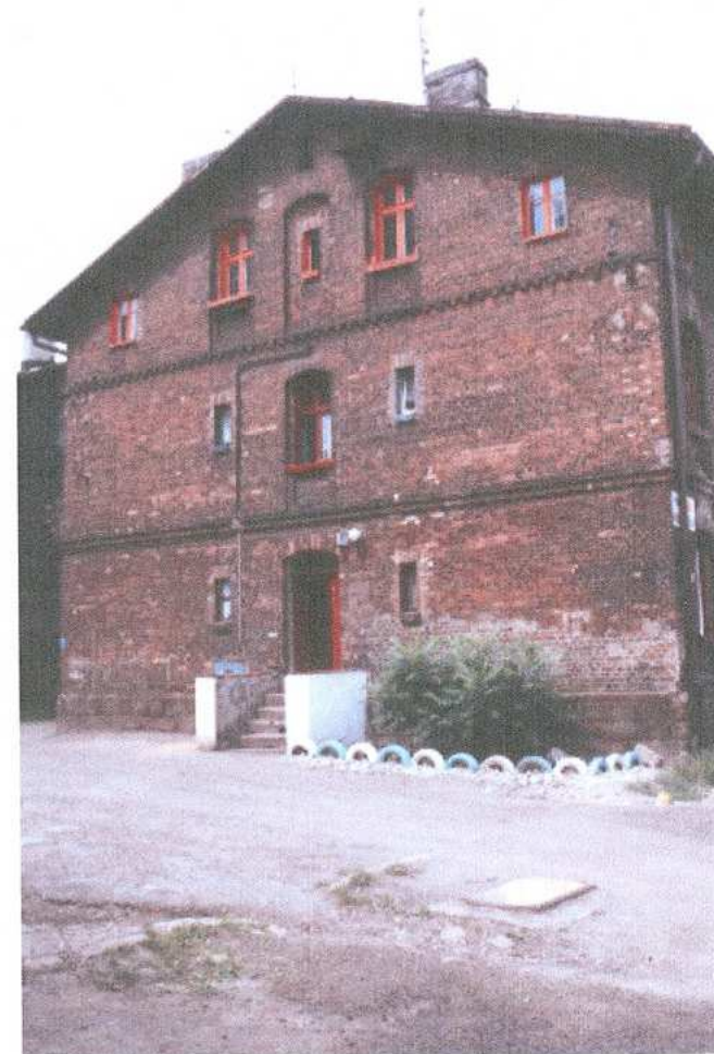
4. elewacja południowa – widok od strony południowo - wschodniej
