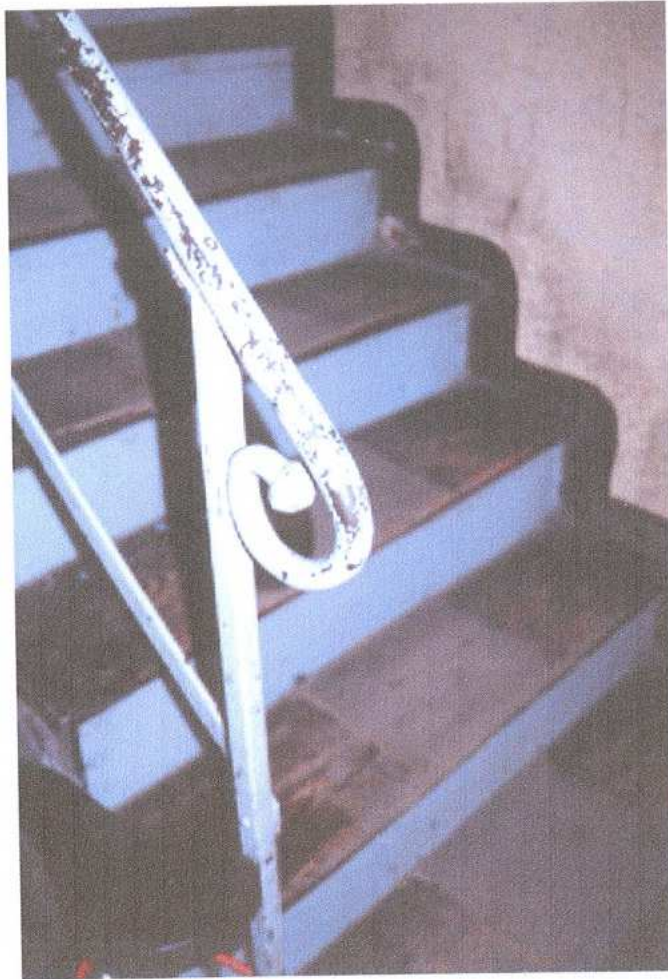
7. klatka schodowa – fragment bariery
