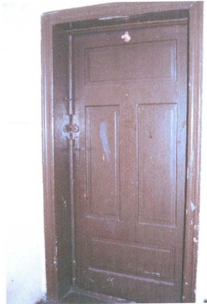
8. klatka schodowa - drzwi
