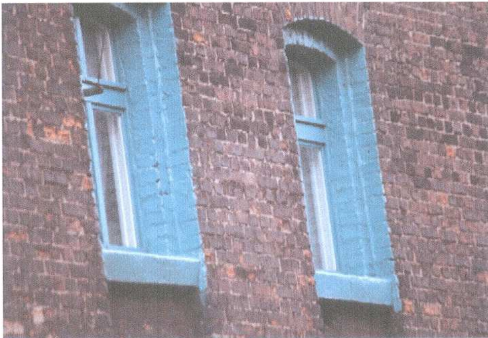
13. fragment elewacji północnej – okna
