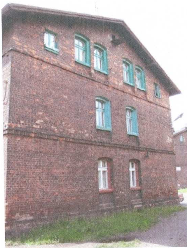
5. elewacja północna – widok od strony północno-wschodniej
