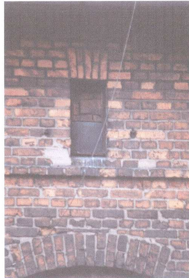
14. fragment elewacji zachodniej – partia strychu
