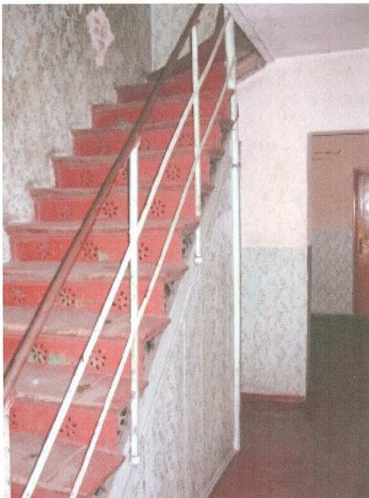
19. fragment klatki schodowej
