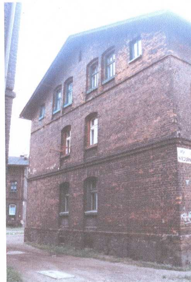
6. elewacja południowa – widok od strony południowo-wschodniej
