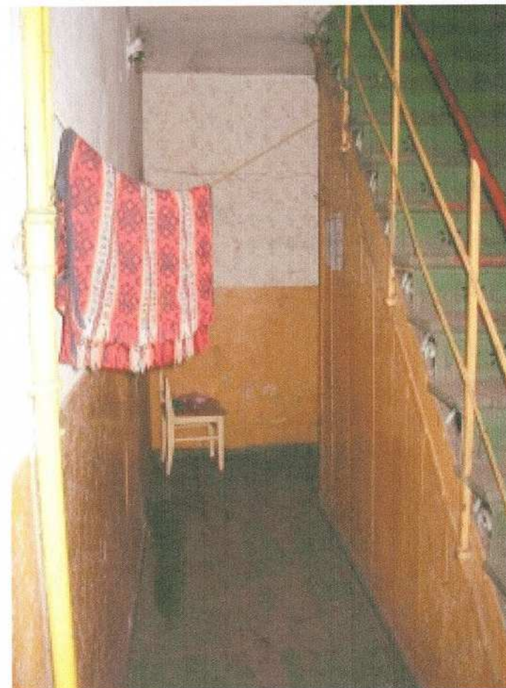
16. klatka schodowa – widok ogólny
