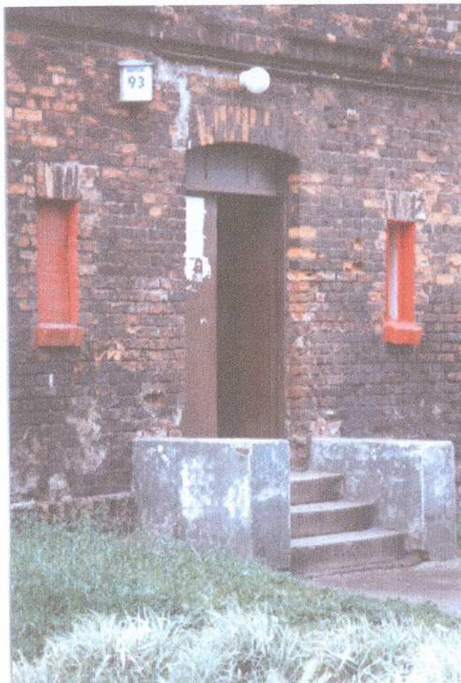
9. fragment elewacji północnej - drzwi
