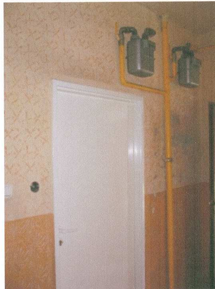
18. klatka schodowa - drzwi
