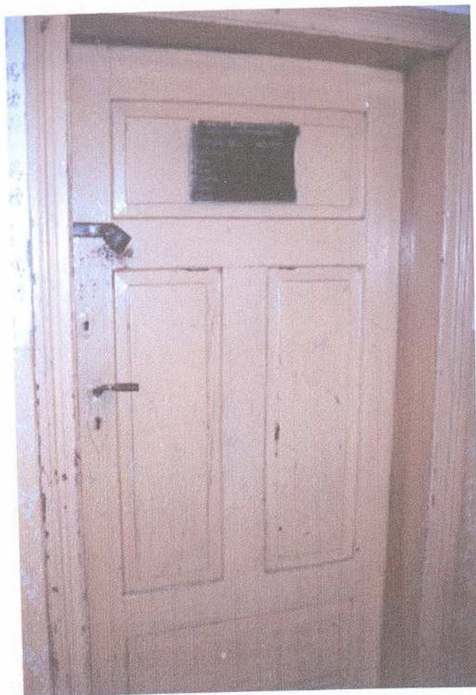
11. klatka schodowa - drzwi
