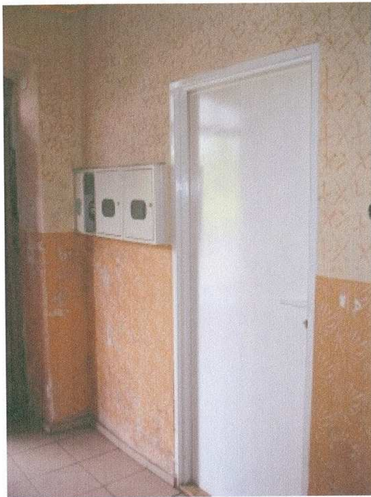
17. klatka schodowa - drzwi
