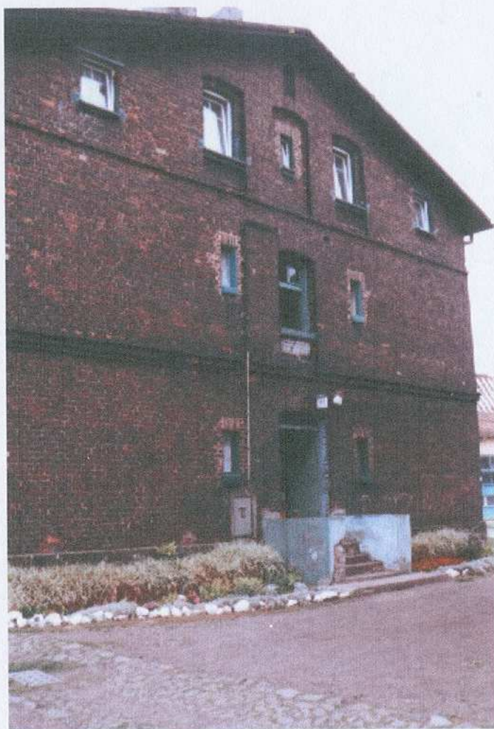
3. elewacja południowa – widok od strony południowo-zachodniej
