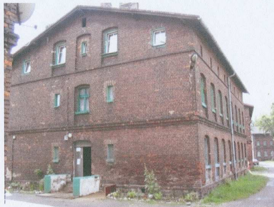
4. elewacja północna – widok od strony północno - zachodniej
