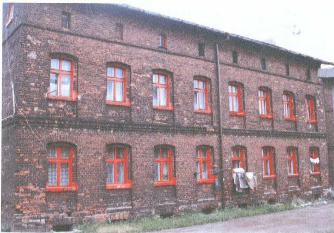
1. elewacja zachodnia – widok od strony północno – zachodniej
