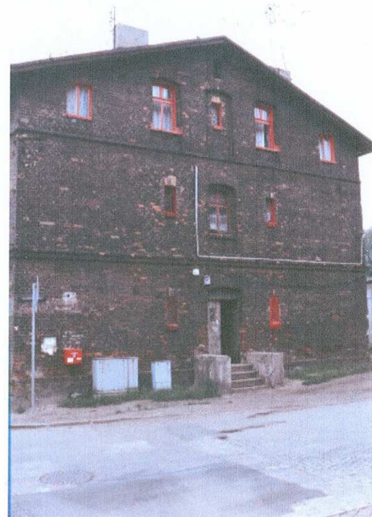
2. elewacja północna – widok od strony północno - wschodniej
