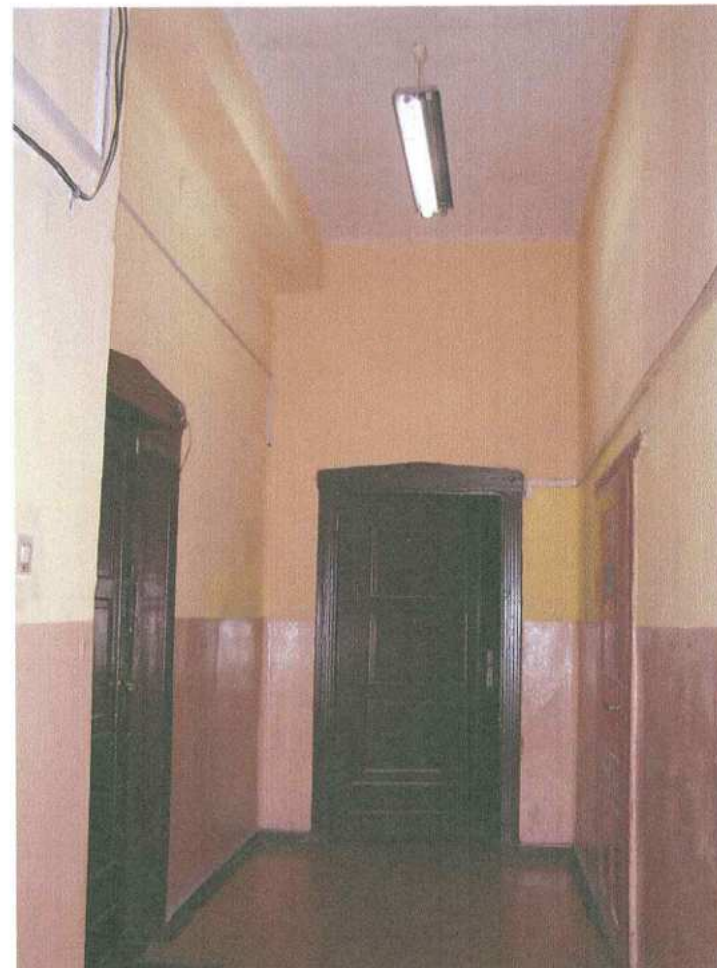
42. Korytarz – widok ogólny
