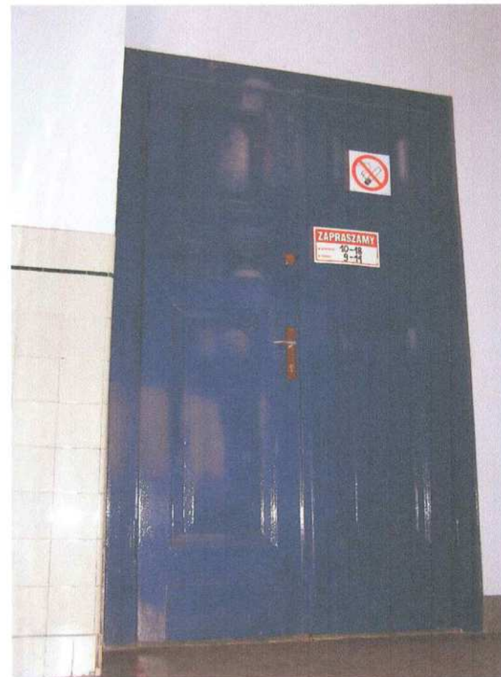
40. Drzwi na I piętrze
