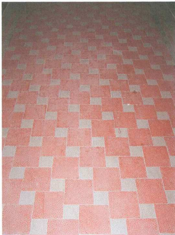
37. Klatka schodowa - posadzka
