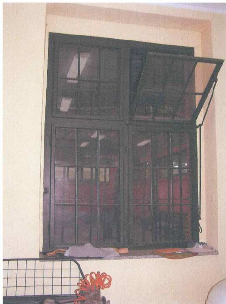
39. Oryginalna stolarka okienna na parterze
