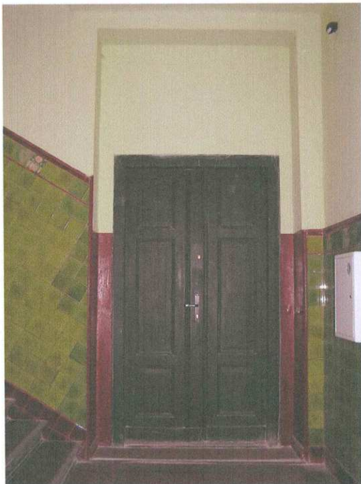
45. Drzwi na I piętrze
