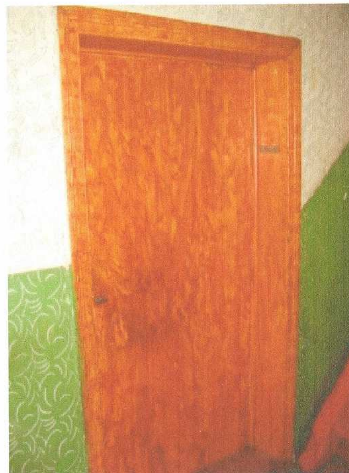
10. klatka schodowa - drzwi
