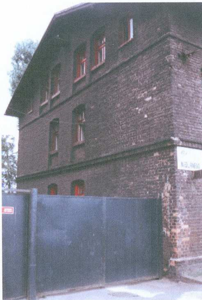
3. fragment elewacji południowej – widok od strony południowo-wschodniej
