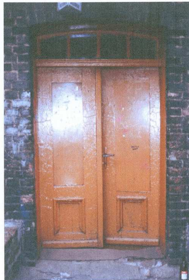
4. fragment elewacji zachodniej - drzwi
