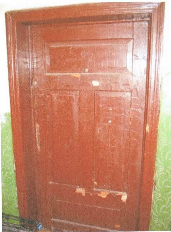
9. klatka schodowa - drzwi
