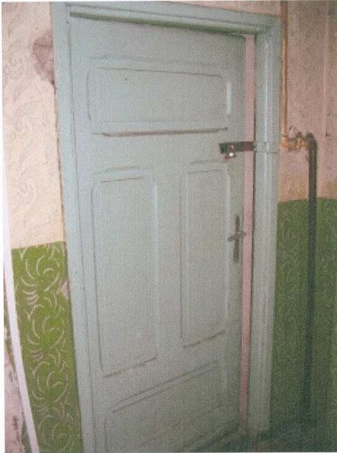
11. klatka schodowa - drzwi
