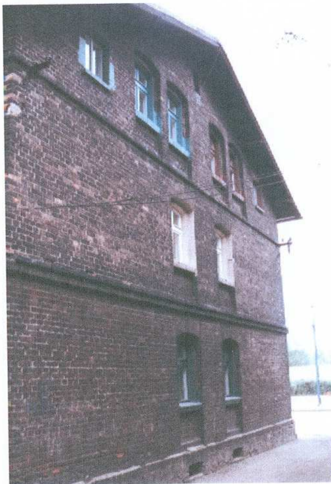
3. elewacja południowa – widok od strony południowo-zachodniej
