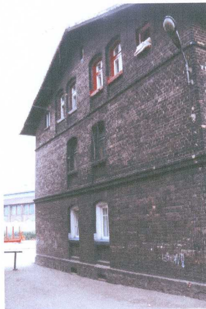
4. elewacja północna – widok od strony północno-zachodniej
