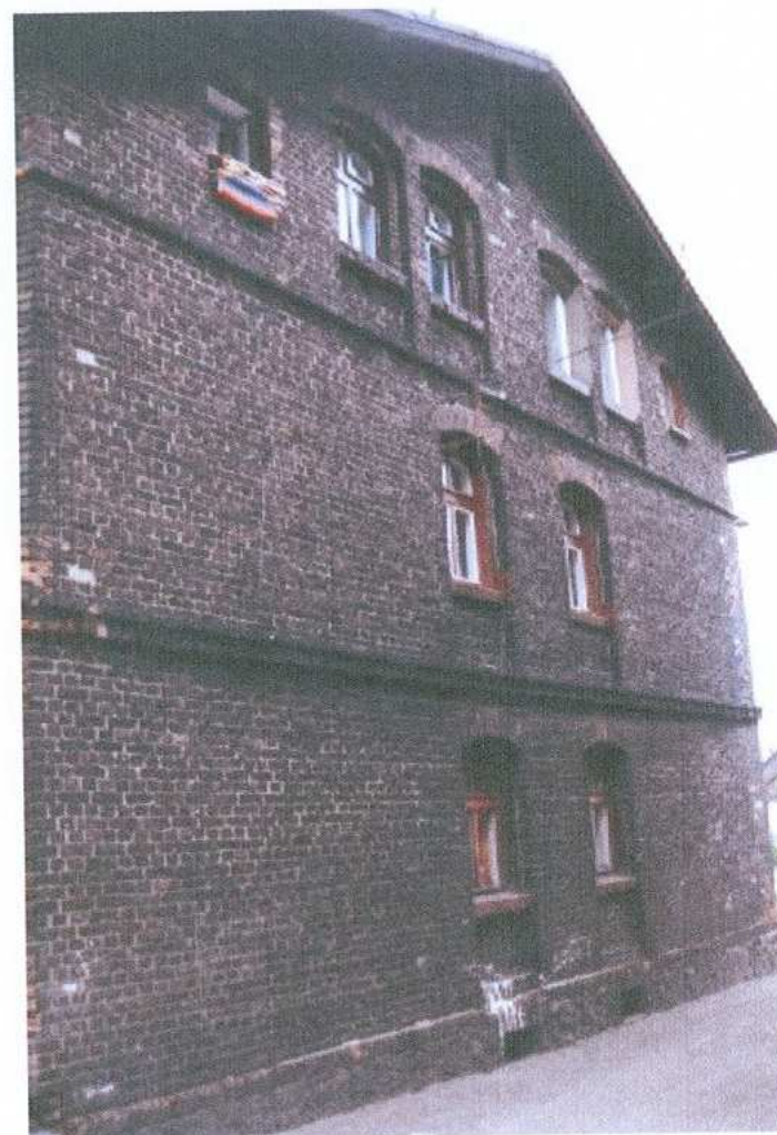
4. elewacja południowa – widok od strony południowo - wschodniej
