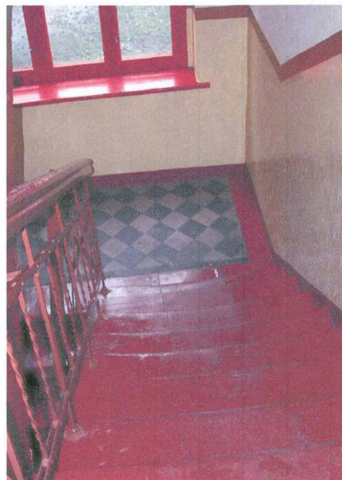
12. Podest piętra klatki schodowej
