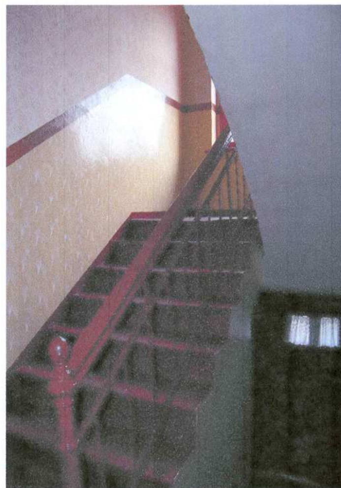
16. Dolny bieg schodów
