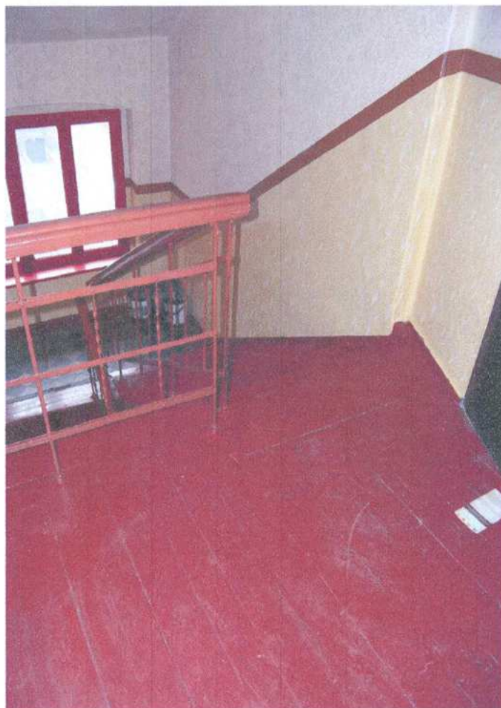
11. Podest ostatniej kondygnacji
