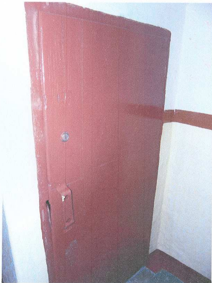
19. Wejście do piwnicy
