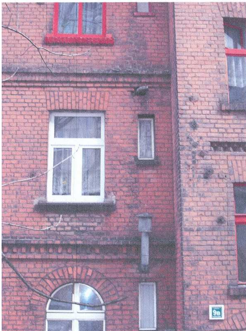
9. Wtórne kominki w elewacji zachodniej
