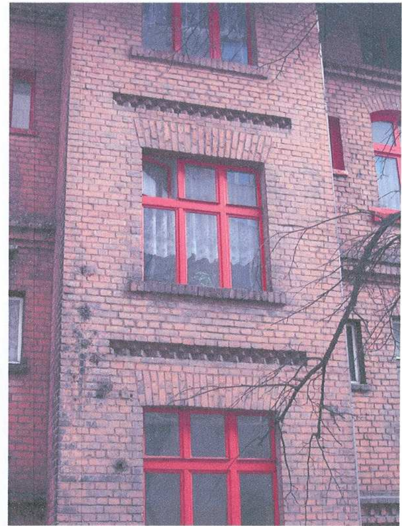
8. Ryzalit centralny w elewacji zachodniej
