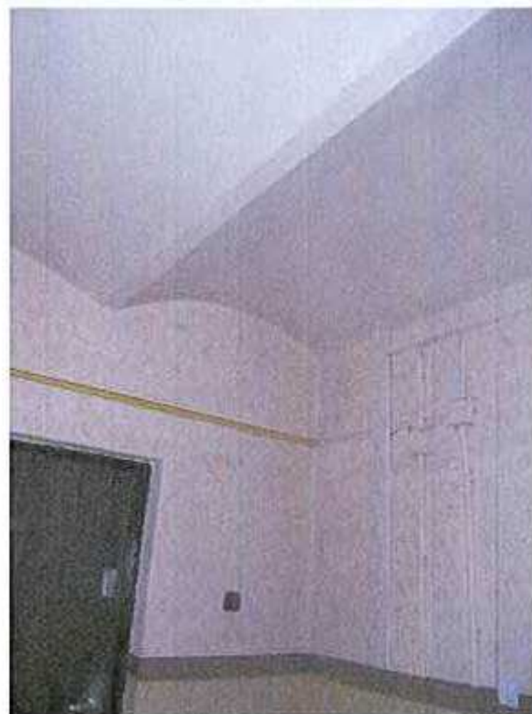
16. Strop na piętrze
