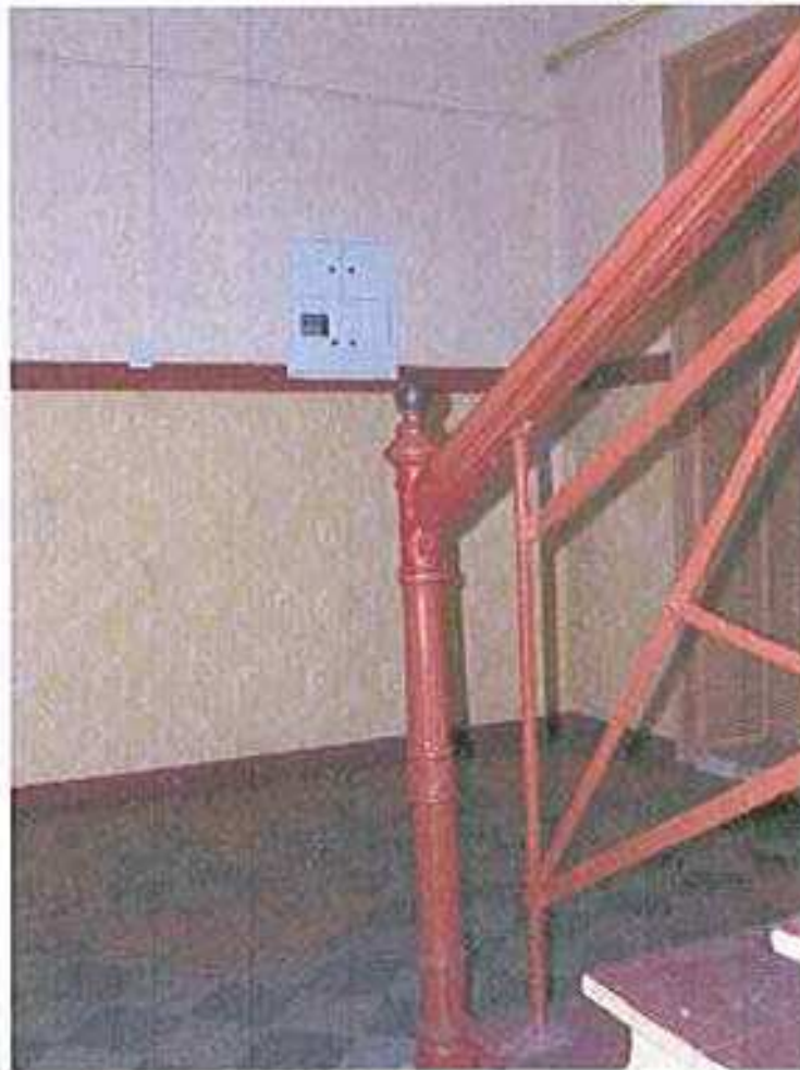
17. Słupek balustrady na parterze
