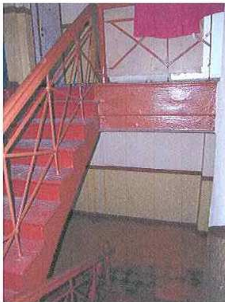
15. Dźwigar na ostatniej kondygnacji części 13b
