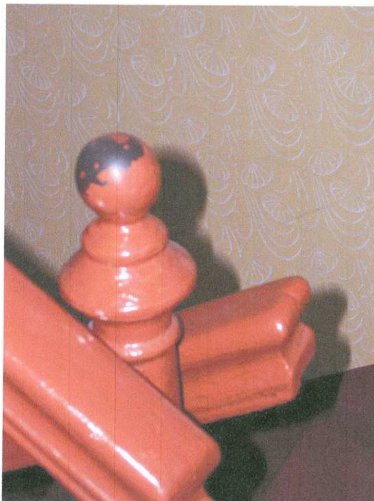
15. Zwieńczenie słupka balustrady
