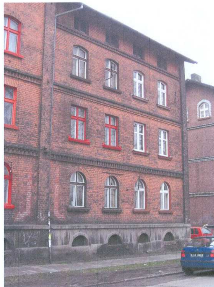
6. Część południowa elewacji wschodniej
