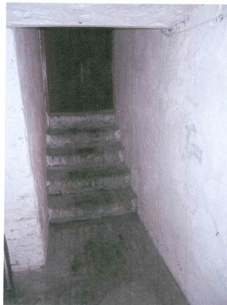
16. Schody do piwnicy
