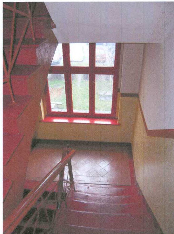
10. Podest między piętrami
