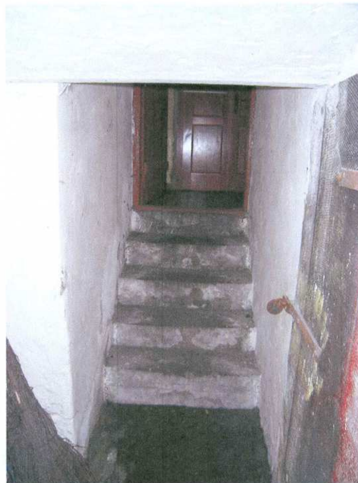
16. Schody do piwnicy
