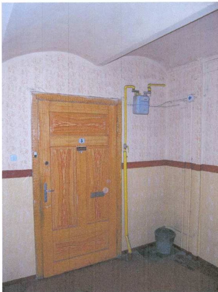
13. Strop i pierwotne drzwi podestu piętra
