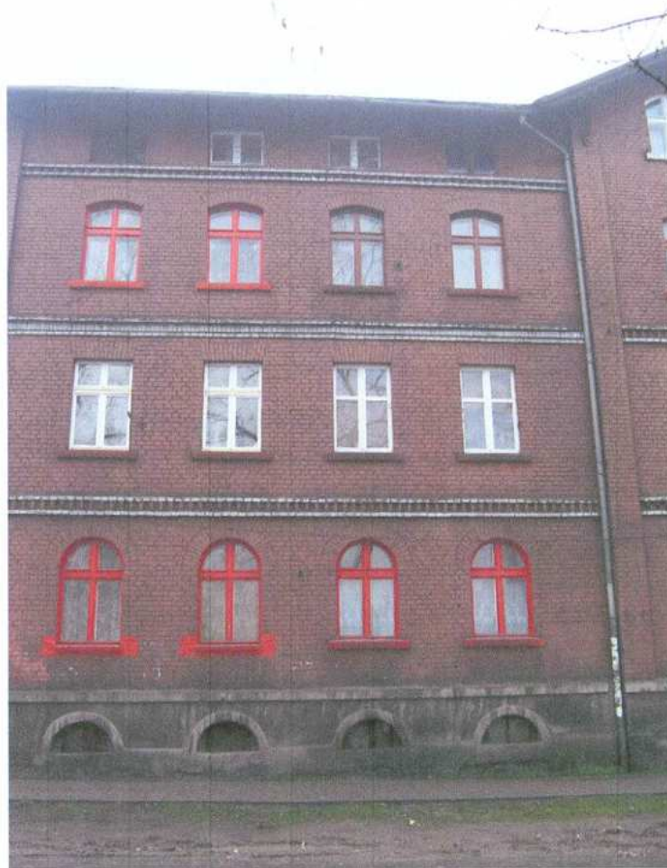
7. Część południowa elewacji wschodniej
