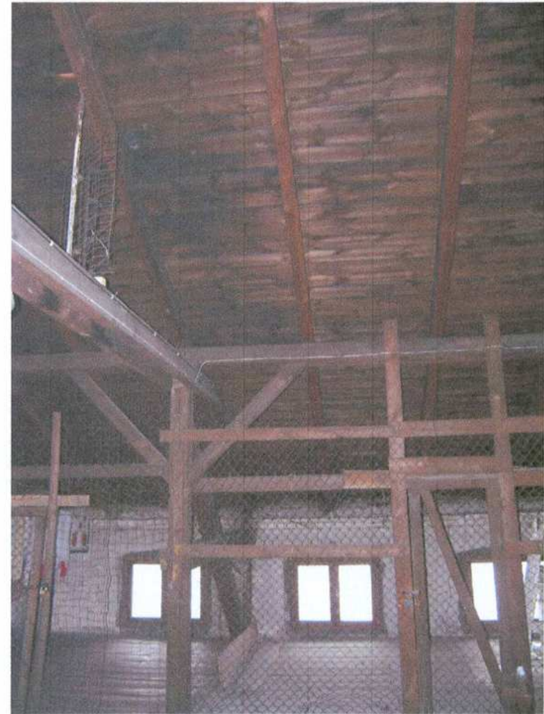
14. Więźba dachowa i zabudowa
