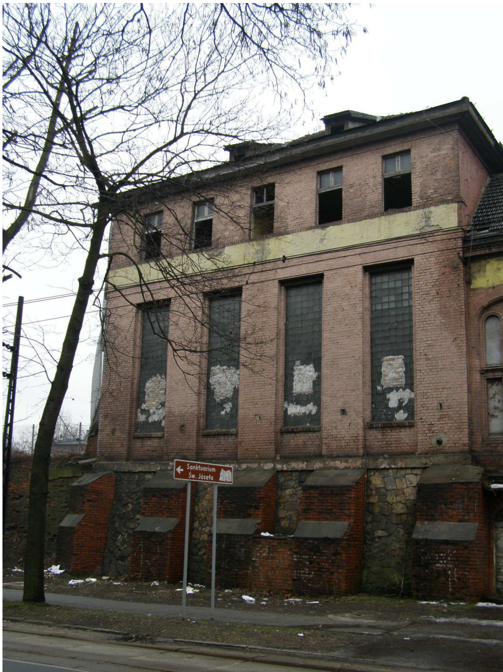
Elewacja frontowa - ryzalit wschodni
