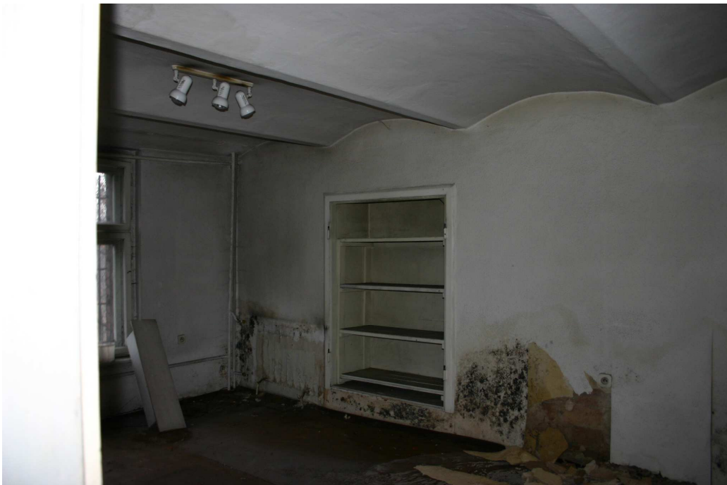
Strop i wnęka
