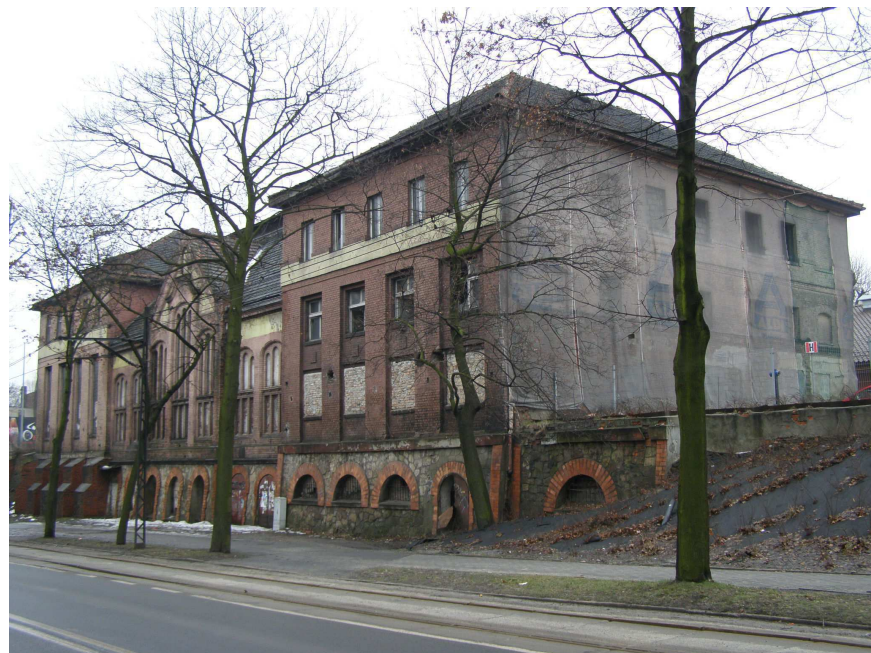
Widok od strony północno-zachodniej
