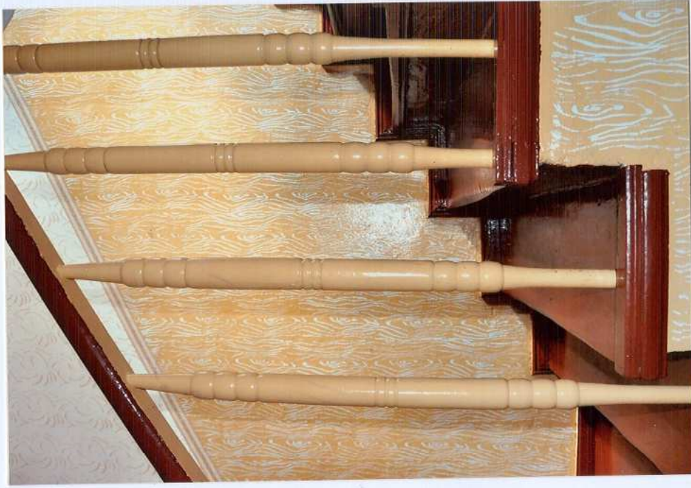
Fot. 42. Tralki balustrady.
