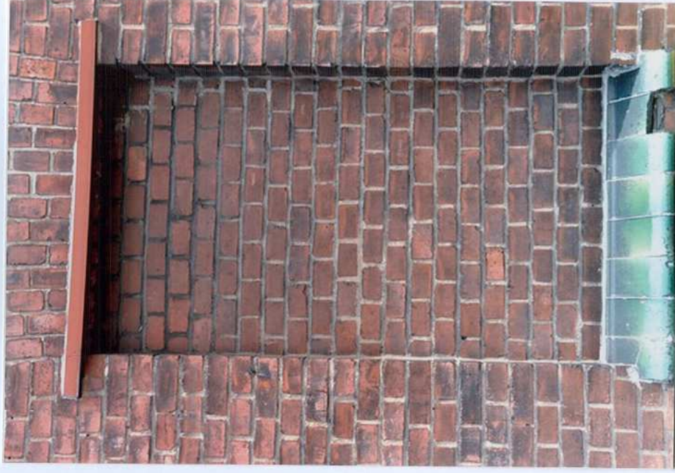
Fot. 13. Płycina na parterze elewacji północnej.
