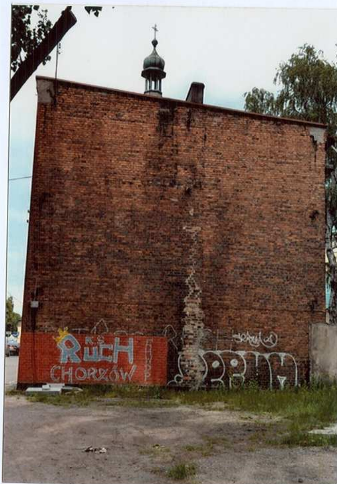
Fot. 16. Elewacja zachodnia.
