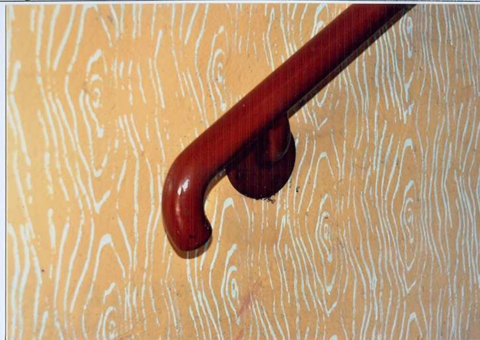
Fot. 45. Poręcz ścienna – schody do piwnicy.
