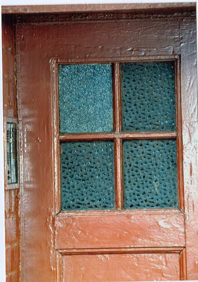
Fot. 25. Przeszklenie w górnej partii skrzydła drzwi.
