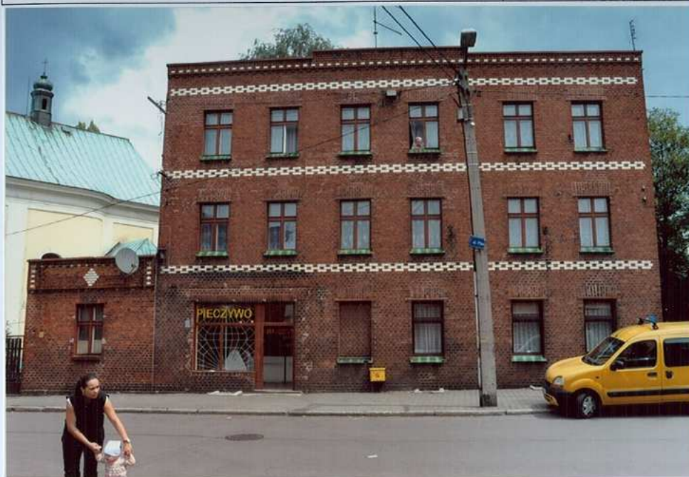
Fot. 1. Elewacja północna.
