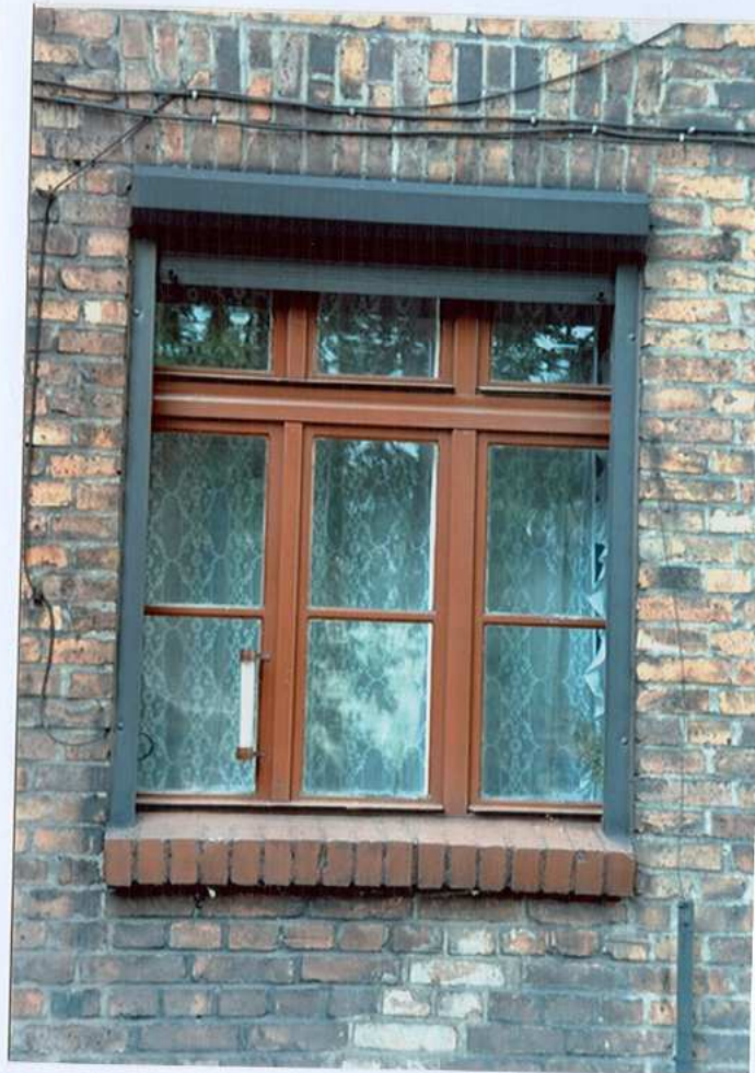
Fot. 22. Okno – elewacja południowa.
