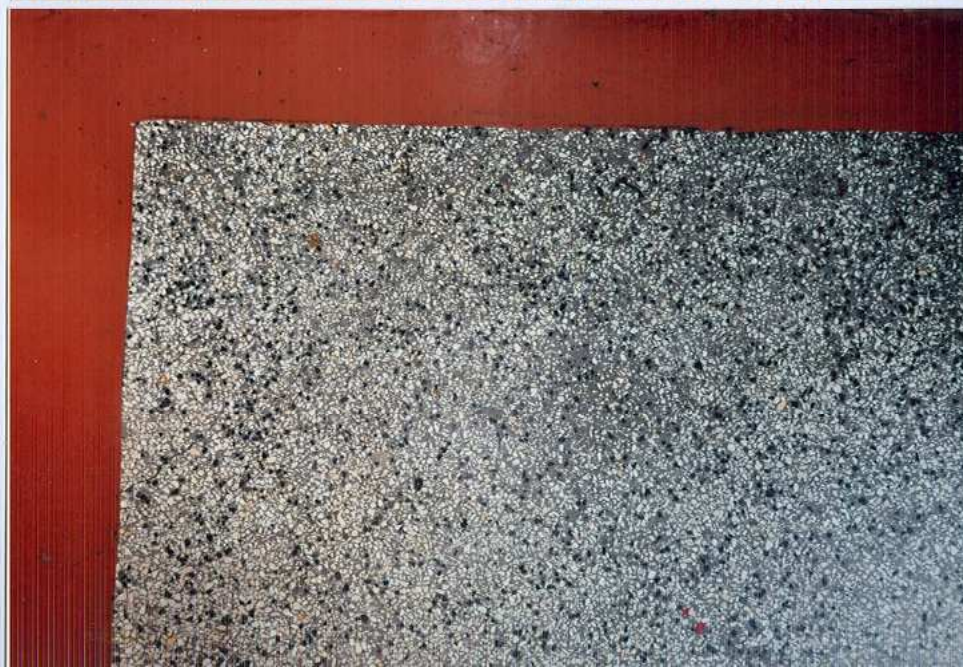
Fot. 4.6. Posadzka opoczników.
