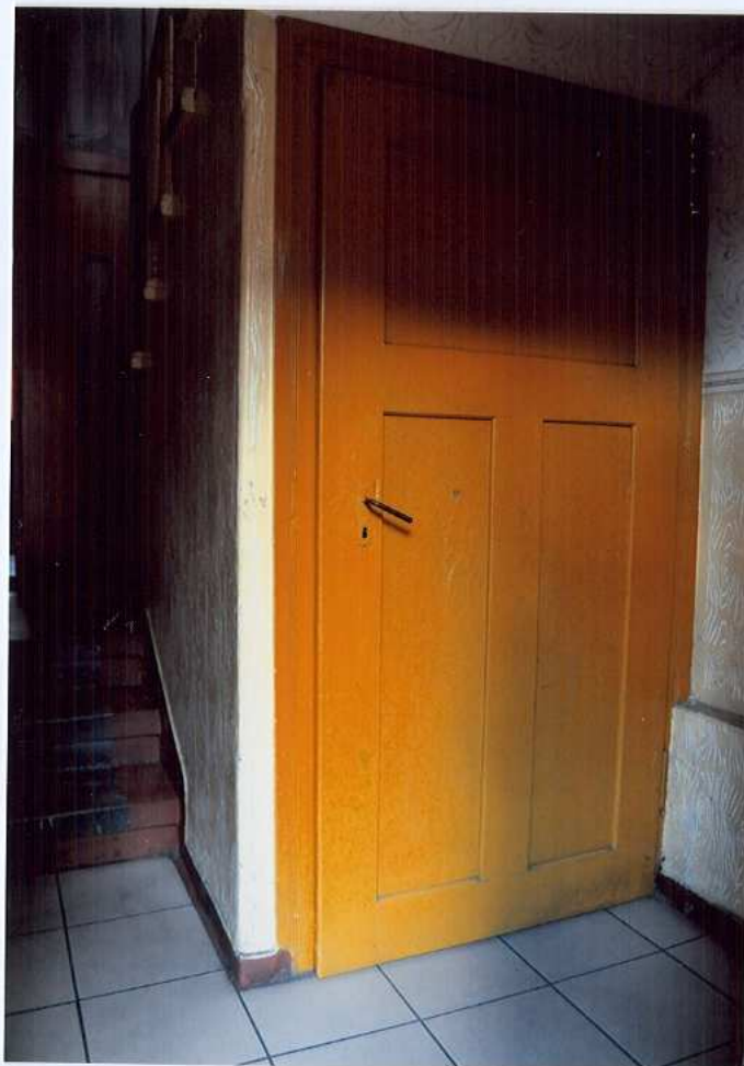
Fot. 30. Drzwi do piwnicy.
