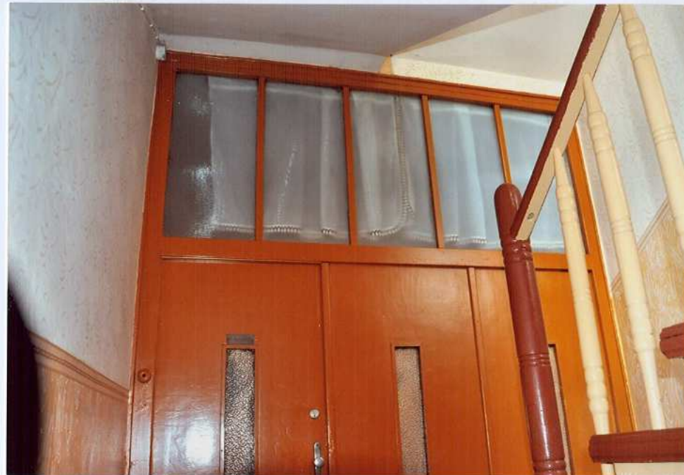
Fot. 36. Górna partia drzwi z nadświetlem.
