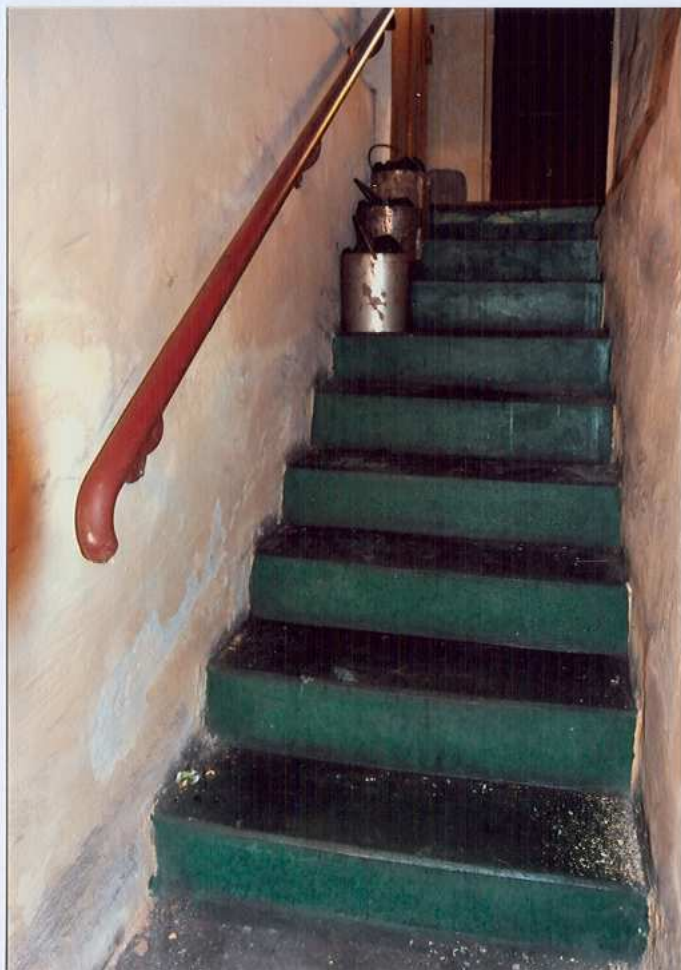
Fot. 44. Schody do piwnicy.
