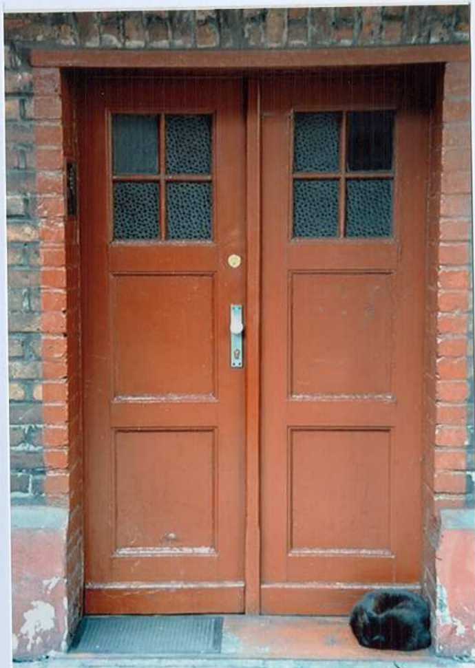
Fot. 24. Drzwi wejściowe do budynku.
