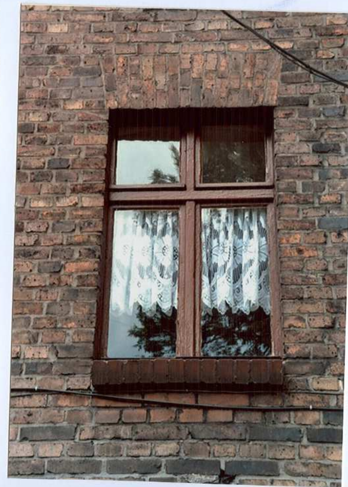
Fot. 23. Okno – elewacja południowa.
