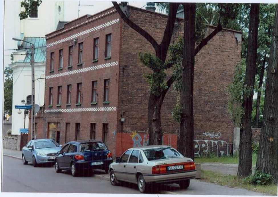
Fot. 7. Widok na budynek od strony północno – zachodniej.
