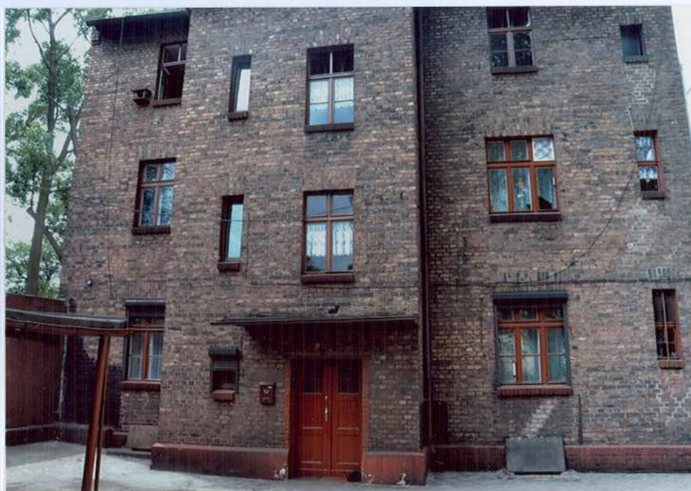
Fot. 19. Elewacja południowa.
