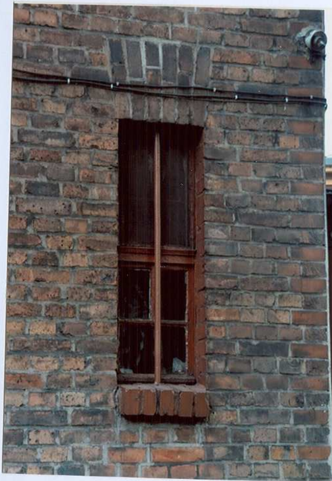
Fot. 21. Okno na parterze – do pomieszczenia gospodarczego.
