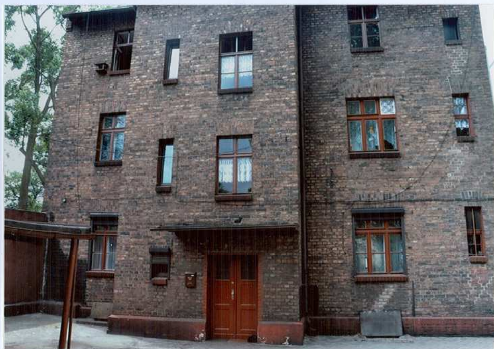
Fot. 19. Elewacja południowa.
