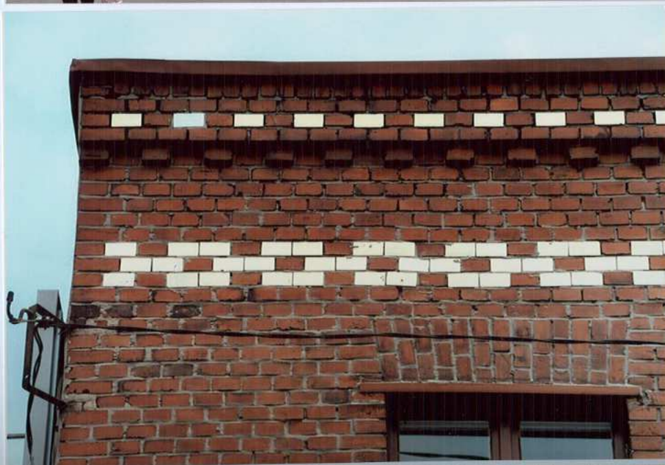
Fot. 2. Górna partia budynku.
