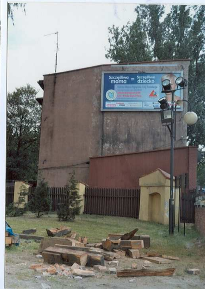
Fot. 17. Elewacja wschodnia.
