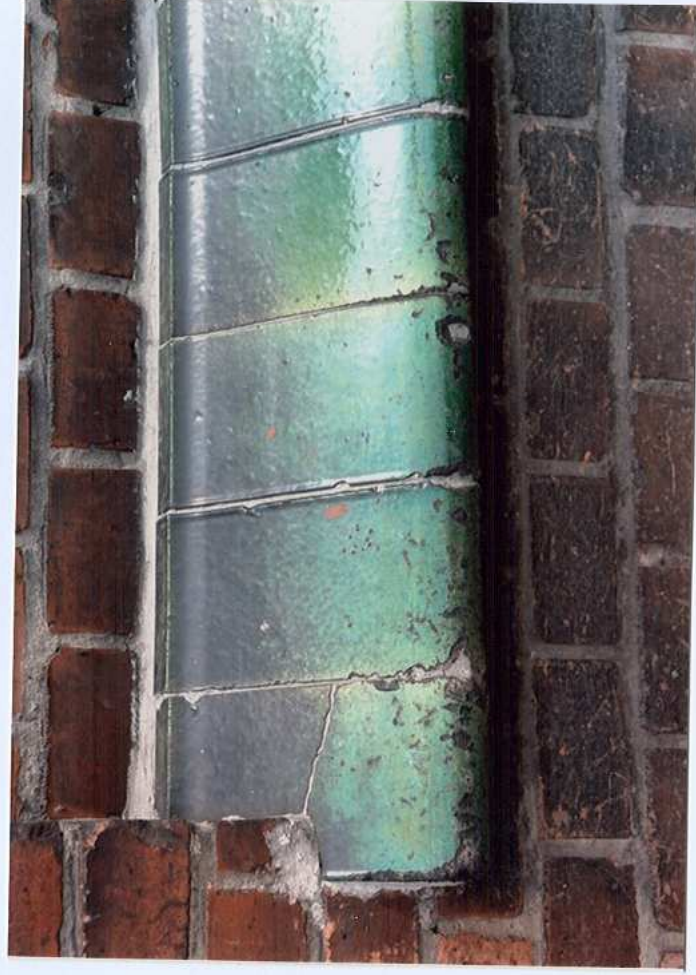
Fot. 14. Parapet z cegły glazurowanej.
