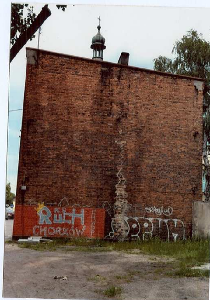
Fot. 16. Elewacja zachodnia.
