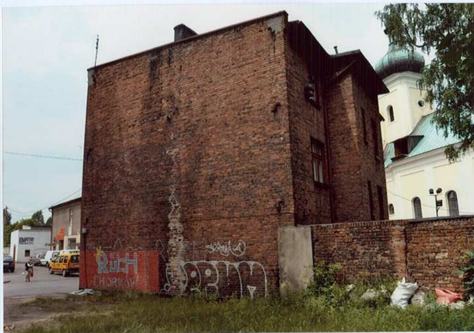
Fot. 18. Widok od strony południowo – zachodniej.
