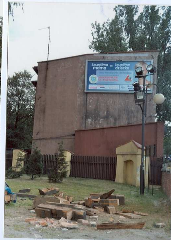
Fot. 17. Elewacja wschodnia.
