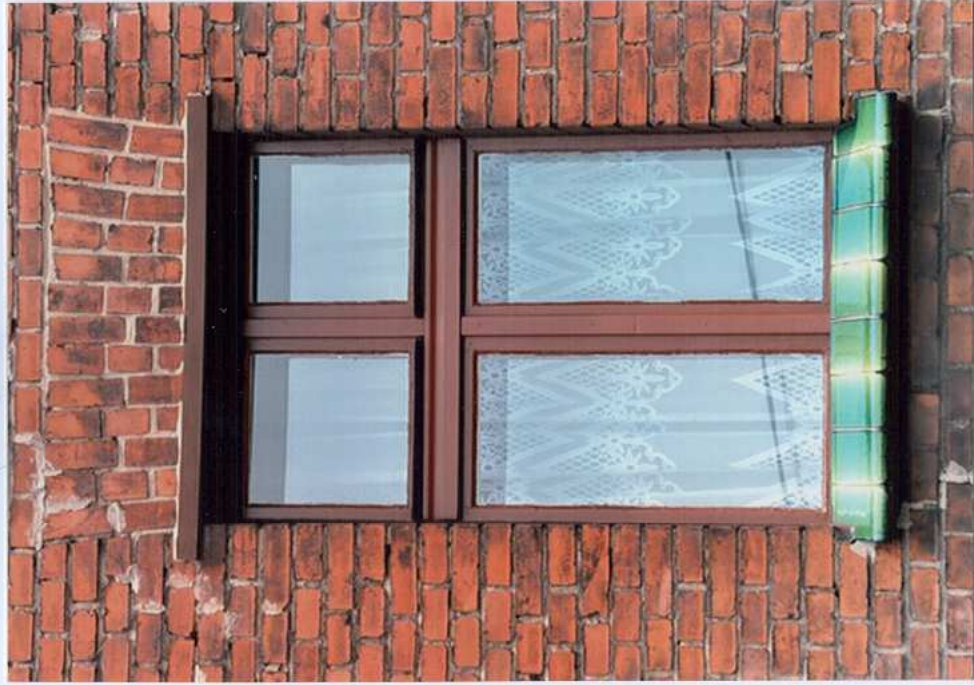
Fot. 12. Okno – elewacja północna.
