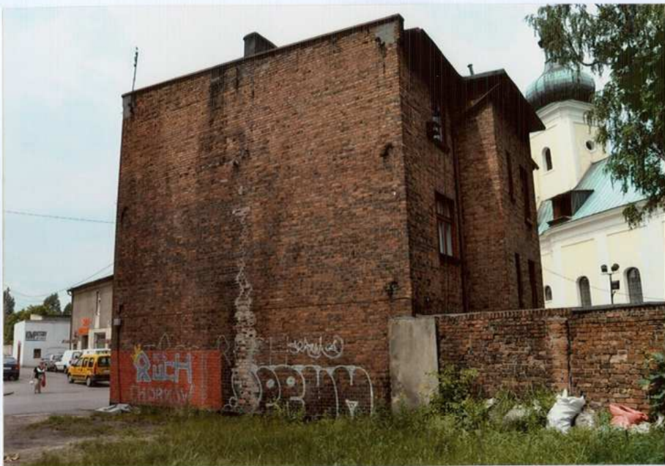
Fot. 18. Widok od strony południowo – zachodniej.
