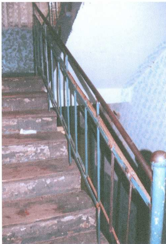
39. klatka schodowa – fragment bariery
