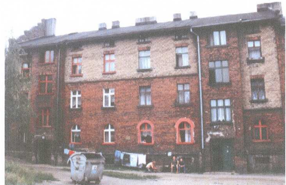
8. fragment elewacji zachodniej
