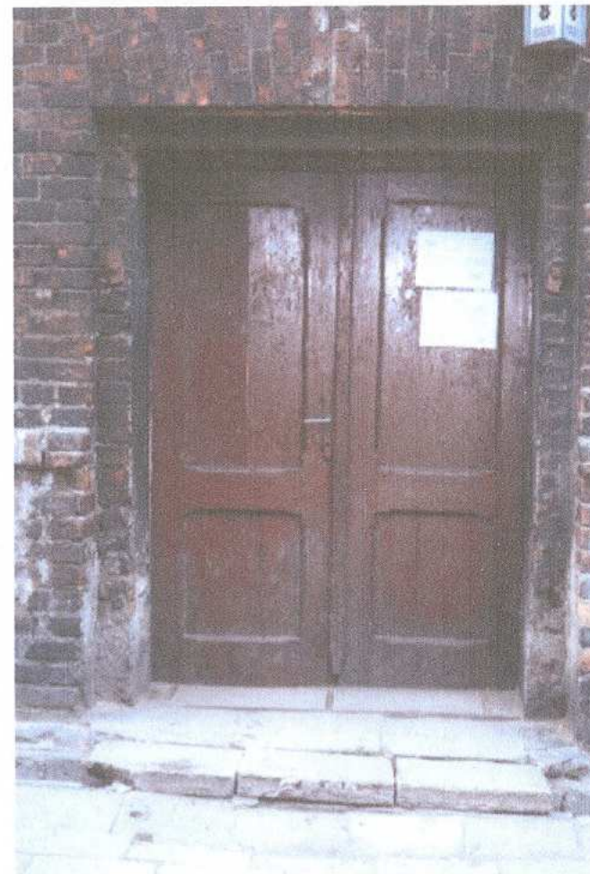
18. fragment elewacji zachodniej - drzwi
