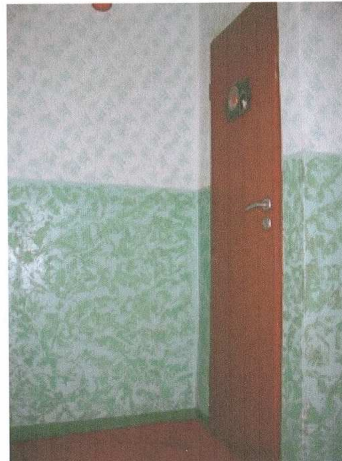
42. klatka schodowa - drzwi
