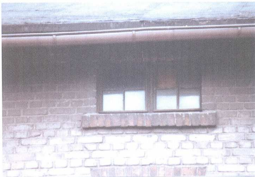
29. fragment elewacji zachodniej - okno
