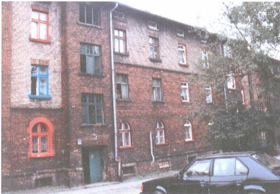
7. fragment elewacji zachodniej
