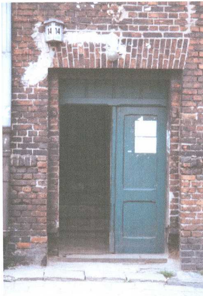
17. fragment elewacji zachodniej - drzwi
