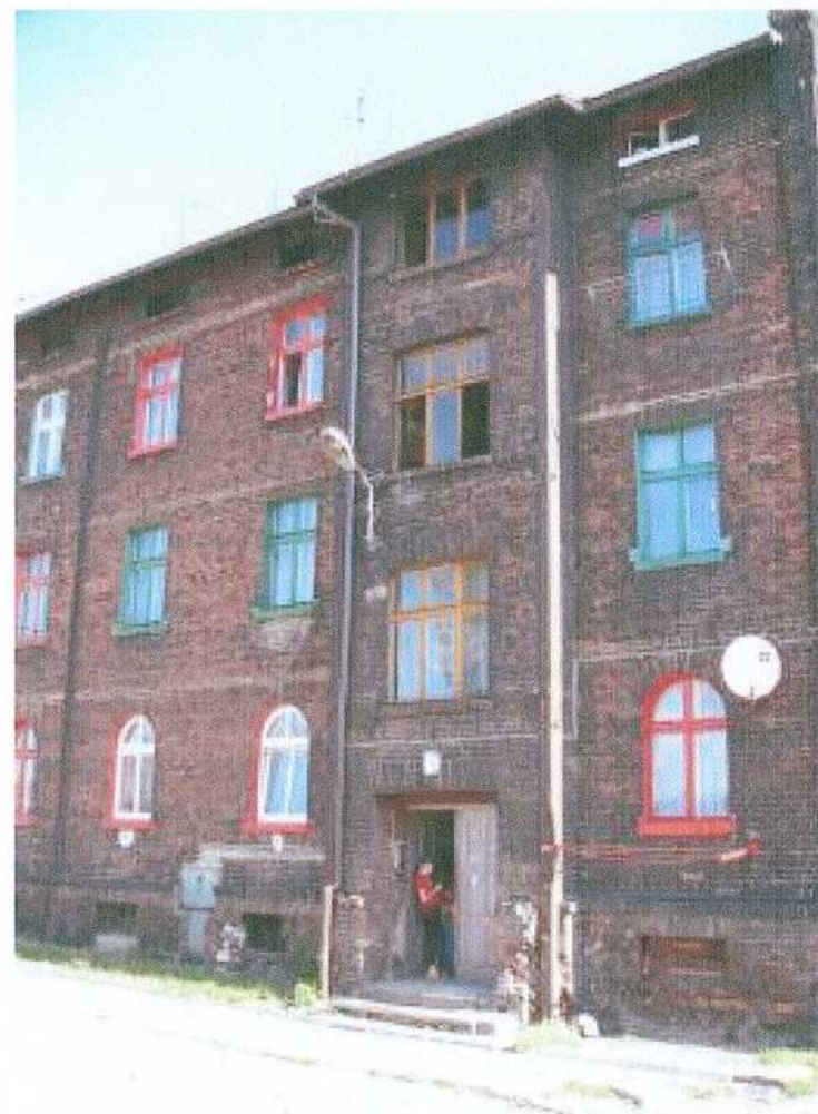
10. fragment elewacji południowej
