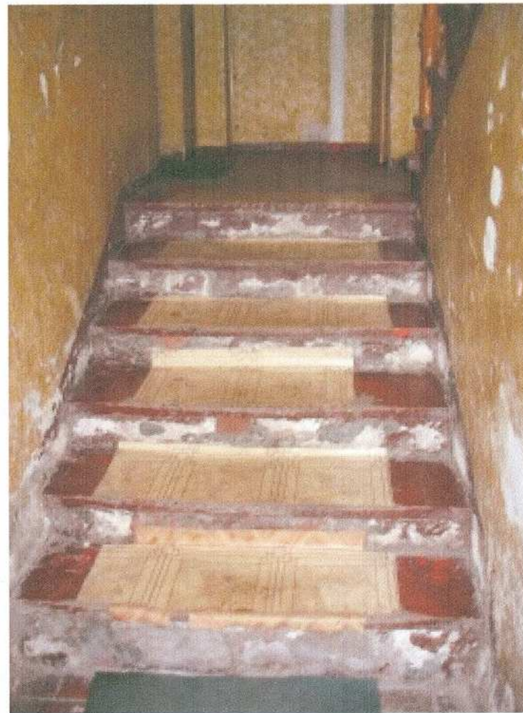
40. fragment klatki schodowej
