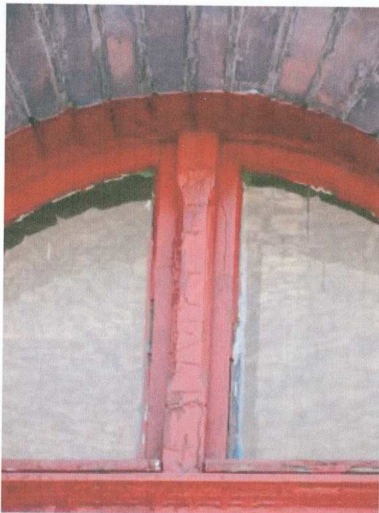
23. fragment elewacji północnej – okno - detal
