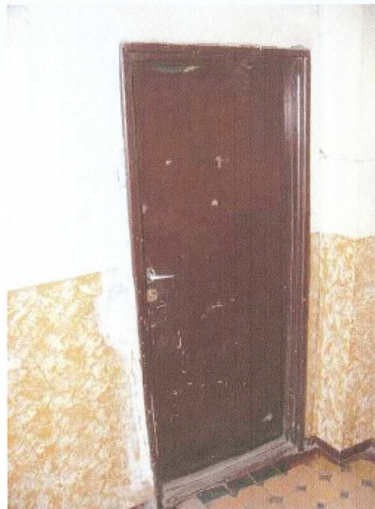
34. klatka schodowa - drzwi
