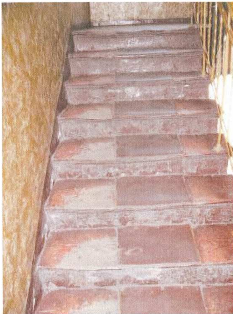
31. fragment klatki schodowej
