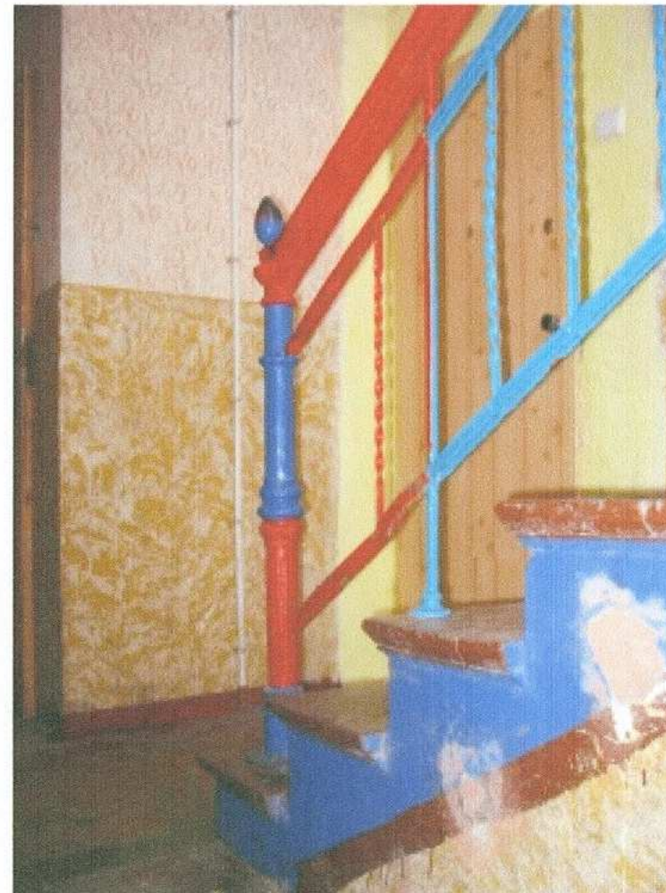
36. schody wraz z balustradą i słupkiem
