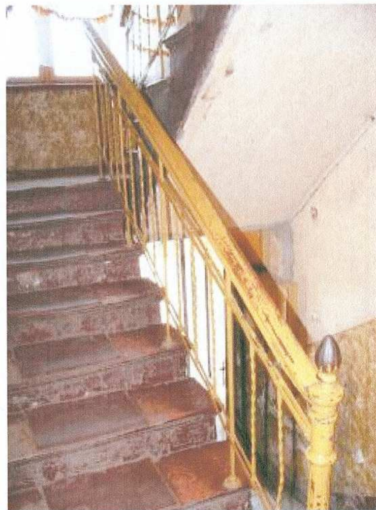
30. schody wraz z balustradą i słupkiem
