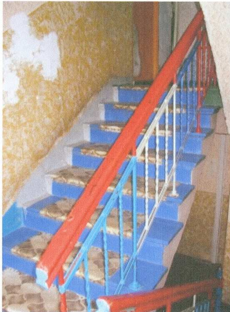
35. fragment klatki schodowej
