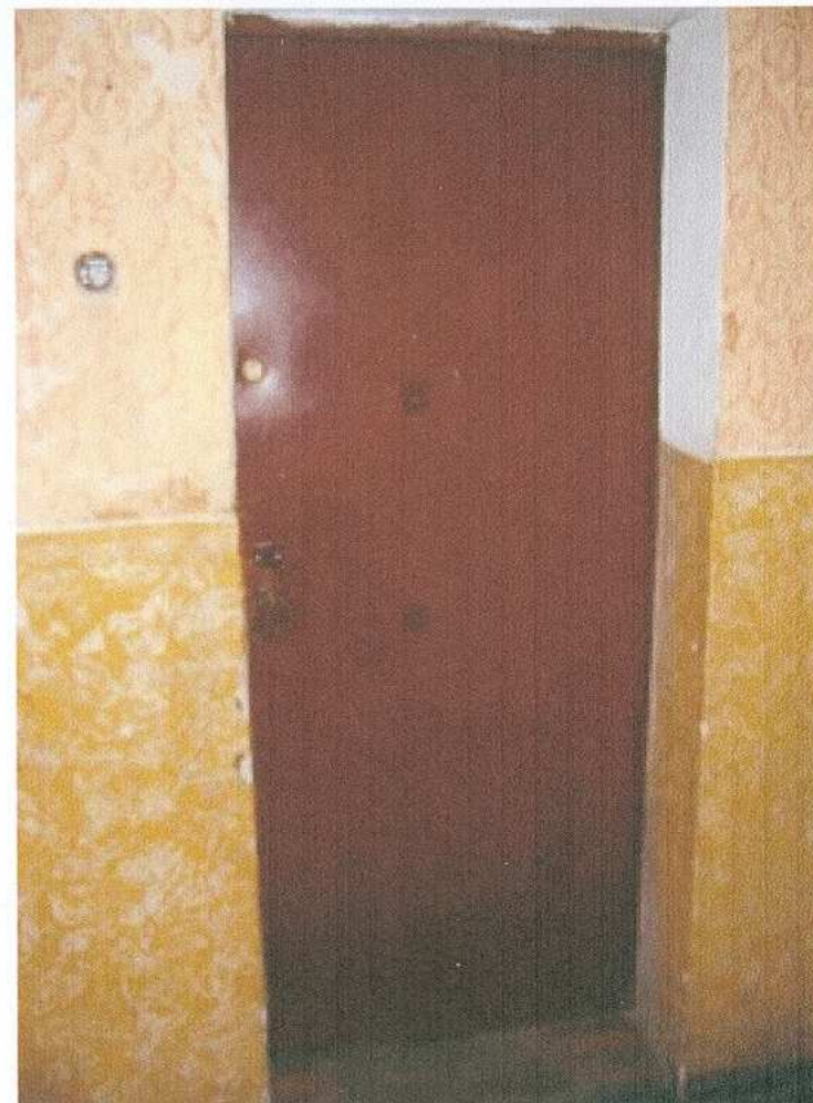
42. klatka schodowa - drzwi
