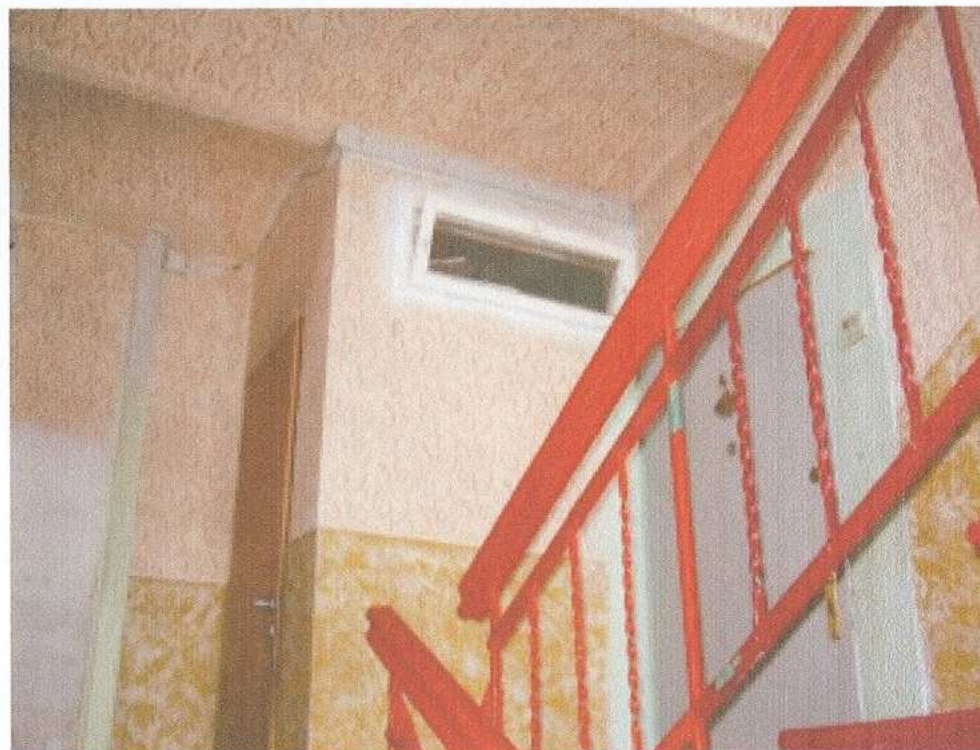
38. klatka schodowa – toaleta
