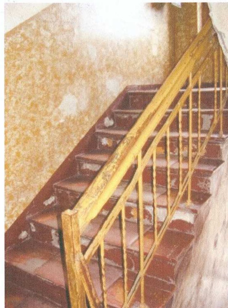
32. schody wraz z balustradą i słupkiem
