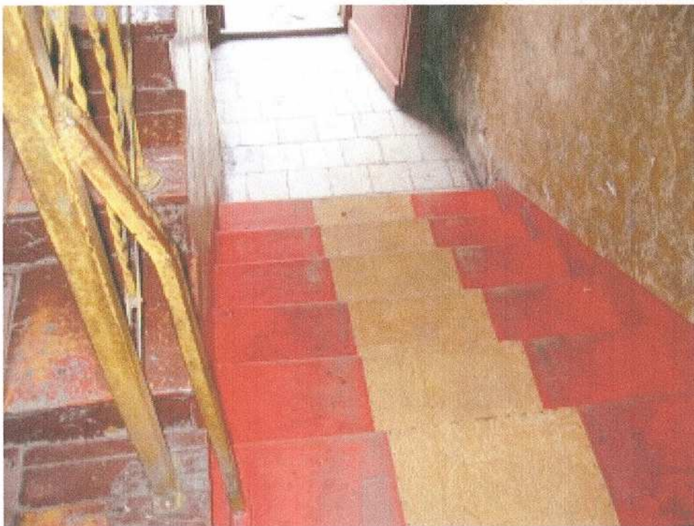
33. fragment klatki schodowej
