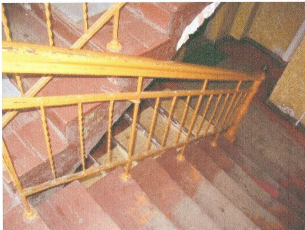
41. klatka schodowa – widok ogólny
