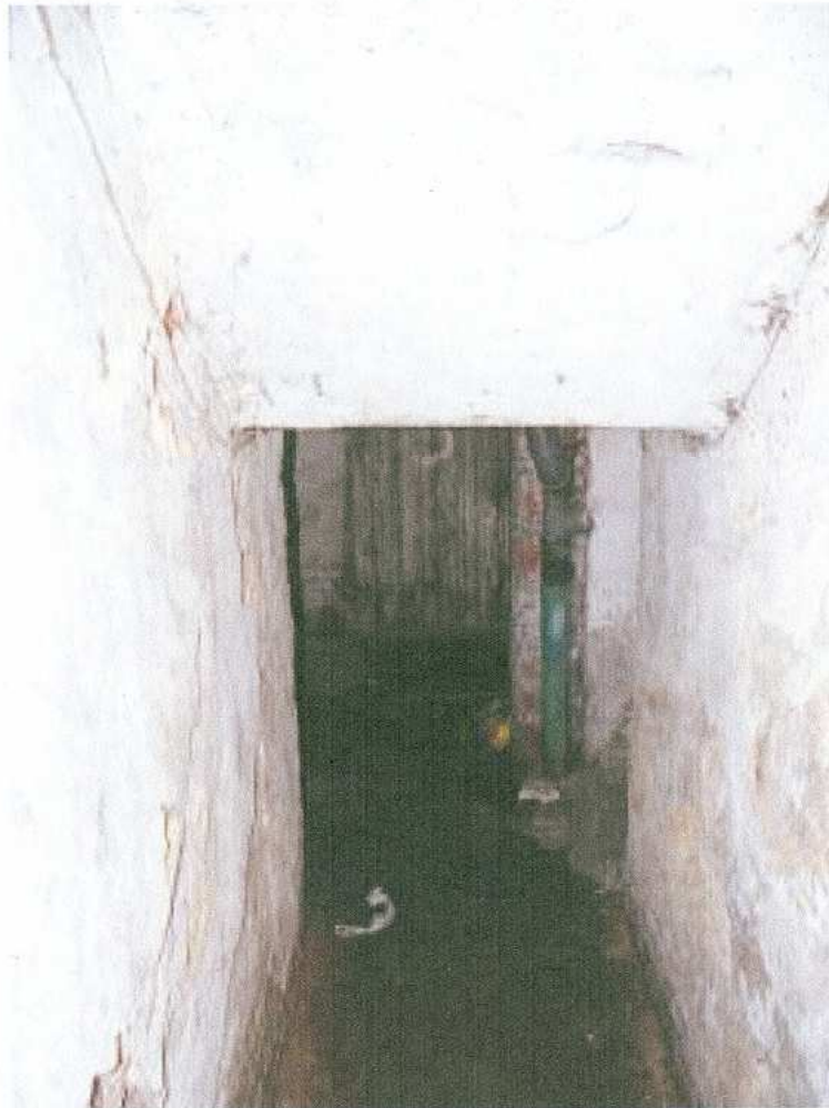
51. klatka schodowa – drzwi toalety
