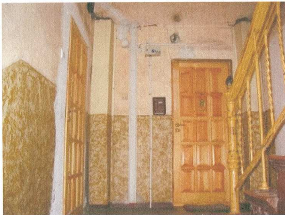
29. klatka schodowa – widok ogólny
