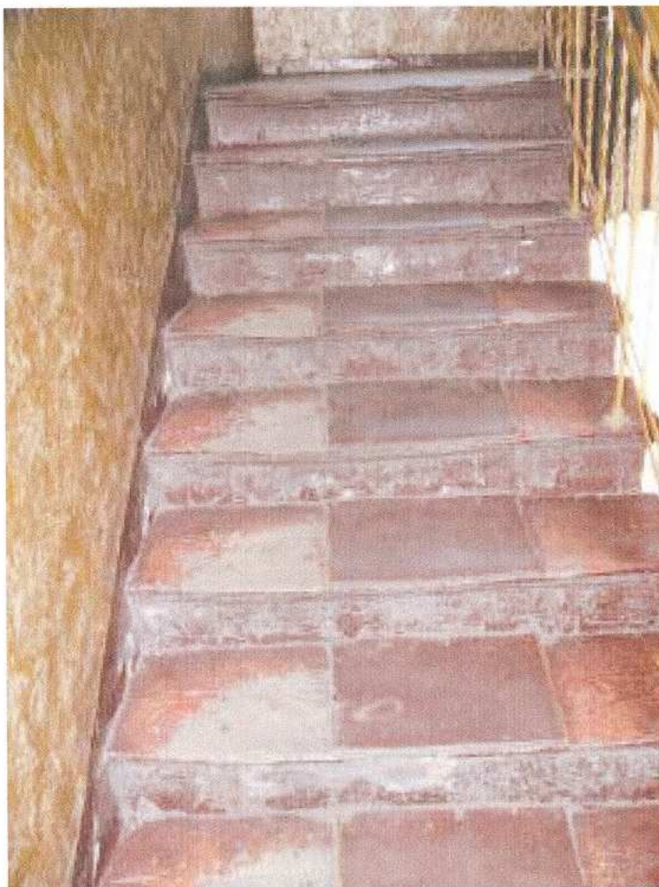
31. fragment klatki schodowej
