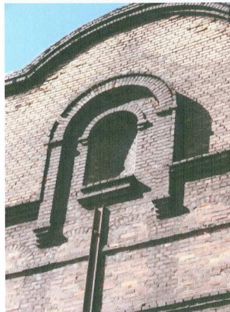
26. fragment elewacji wschodniej - detal
