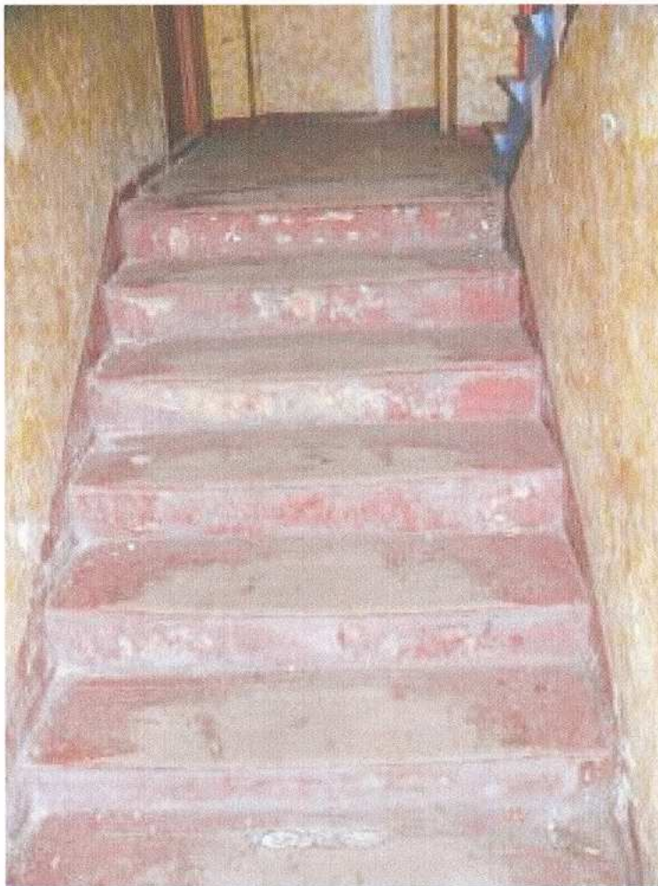
37. fragment klatki schodowej
