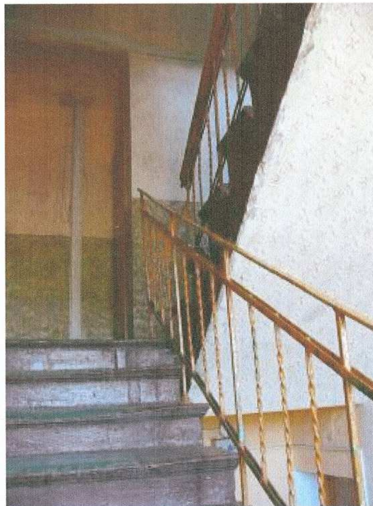
44. schody wraz z balustradą
