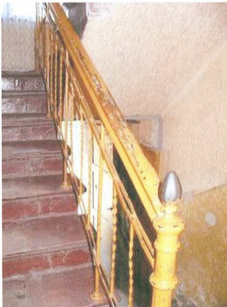
39. schody wraz z balustradą i słupkiem
