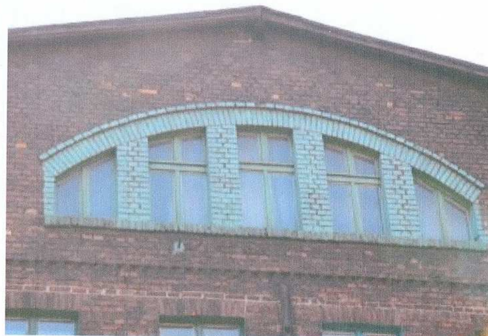
24. fragment elewacji północnej - okna
