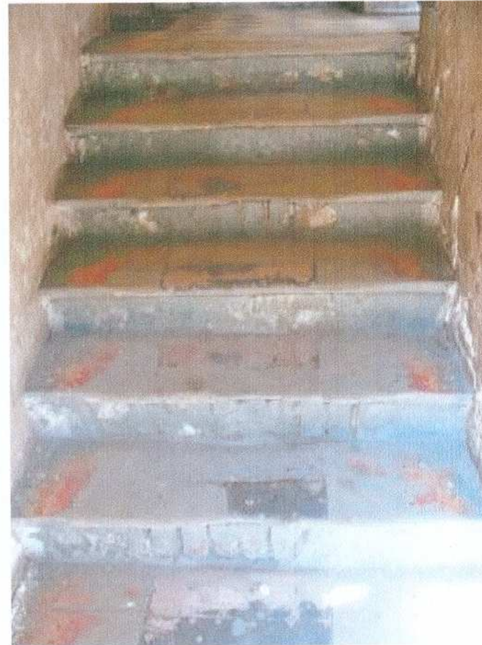
34. Klatka schodowa. Fragment schodów
