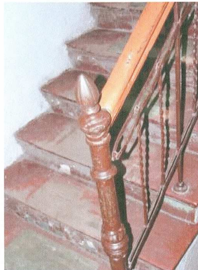
28. Klatka schodowa. Fragment bariery wraz ze słupkiem
