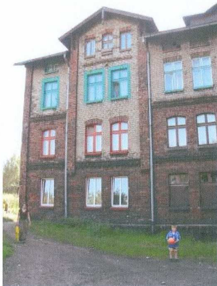
3. Fragment elewacji zachodniej
