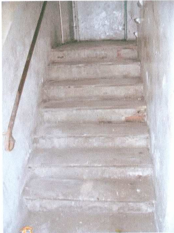
33. Klatka schodowa. Fragment schodów
