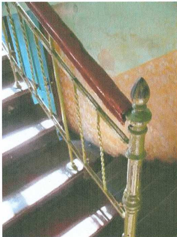
29. Klatka schodowa. Fragment bariery wraz ze słupkiem
