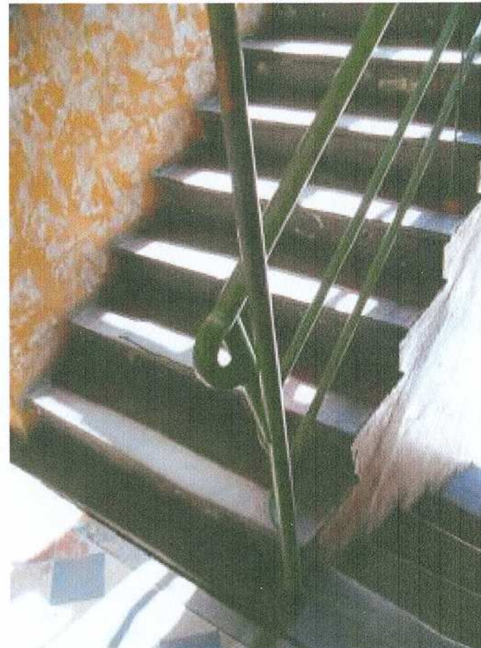
30. Klatka schodowa. Fragment bariery
