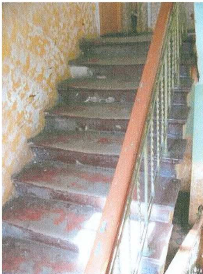
31. Klatka schodowa. Fragment schodów i bariery
