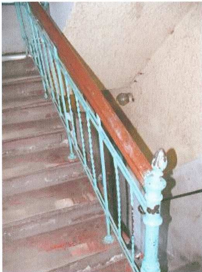
27. Klatka schodowa. Fragment bariery wraz ze słupkiem
