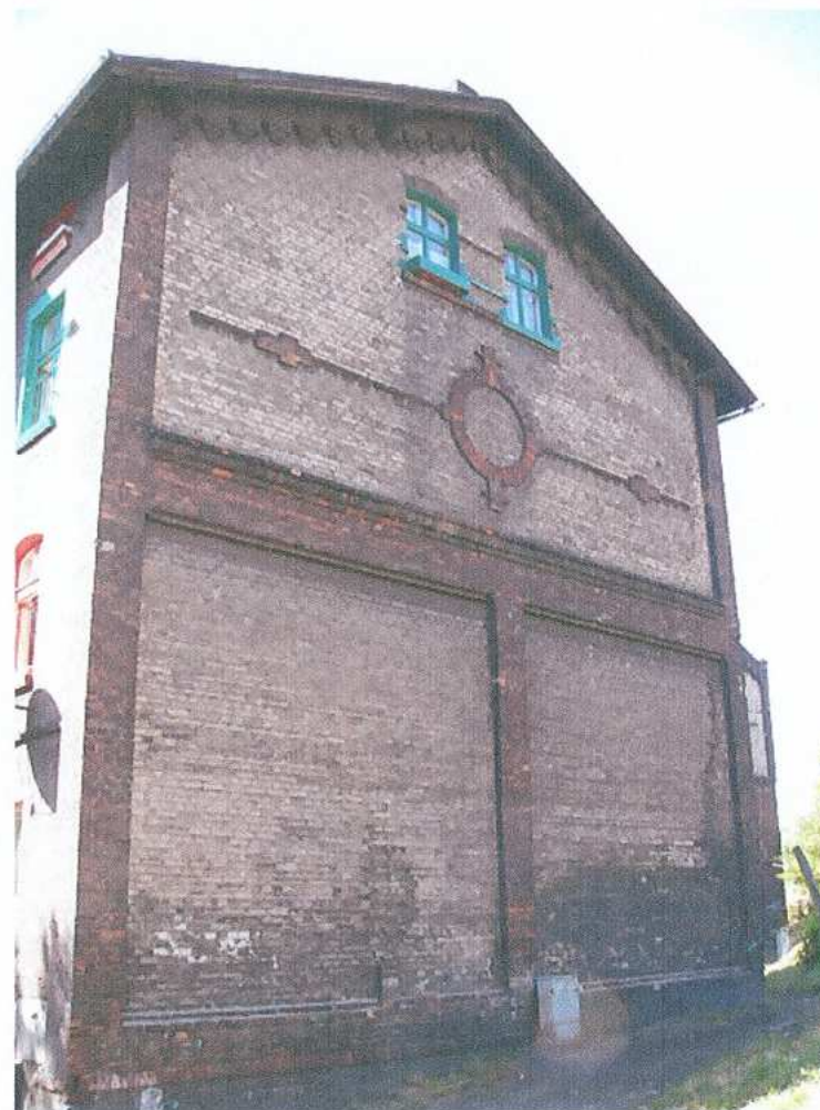
4. Elewacja północna. Widok od północnego - zachodu
