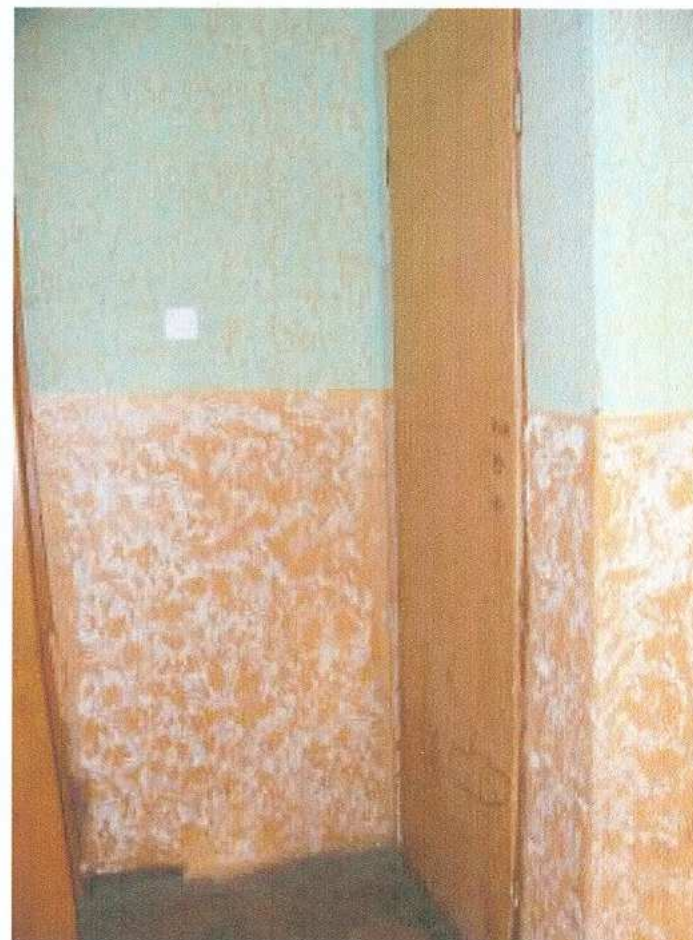
38. Klatka schodowa. Widok na toaletę
