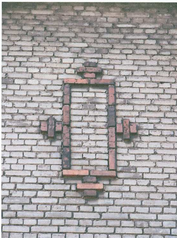
17. Fragment elewacji zachodniej
