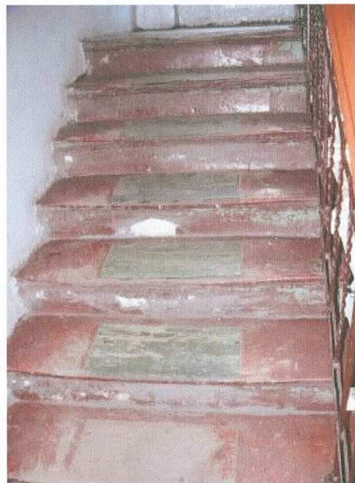
32. Klatka schodowa. Fragment schodów
