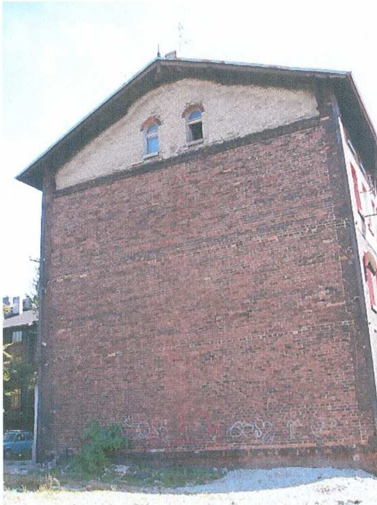
13. Skrzydło południowe. Elewacja zachodnia
