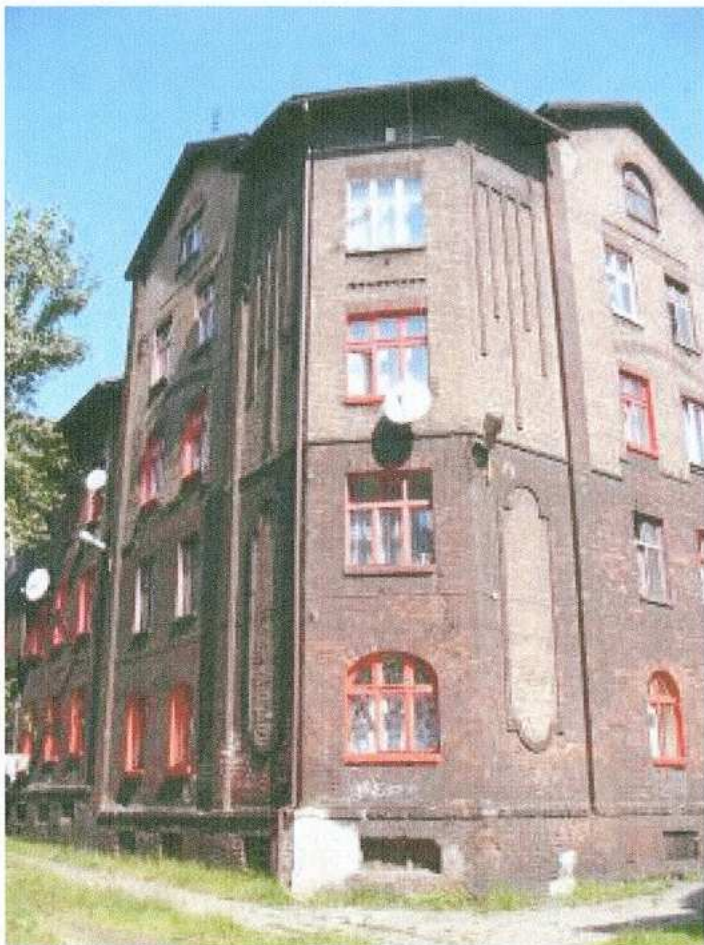
3. Fragment skrzydła wschodniego. Elewacja południowa. Widok od południowego - wschodu
