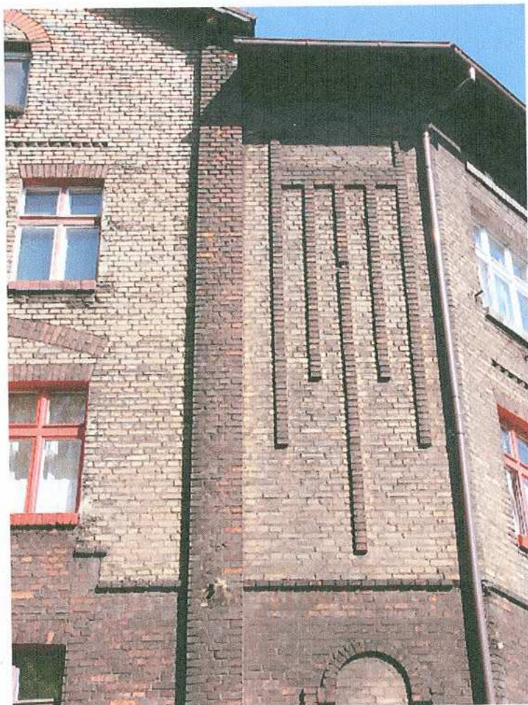
15. Skrzydło wschodnie. Fragment elewacji południowej - Detal
