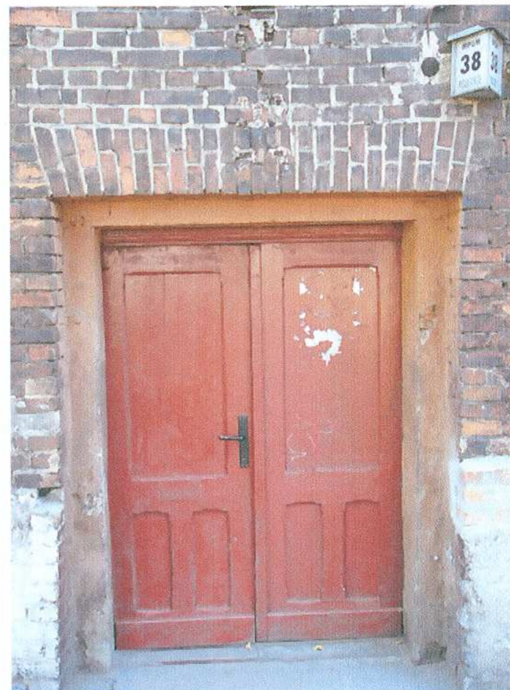
22. Skrzydło wschodnie. Fragment elewacji zachodniej. Drzwi zewnętrzne do klatki
