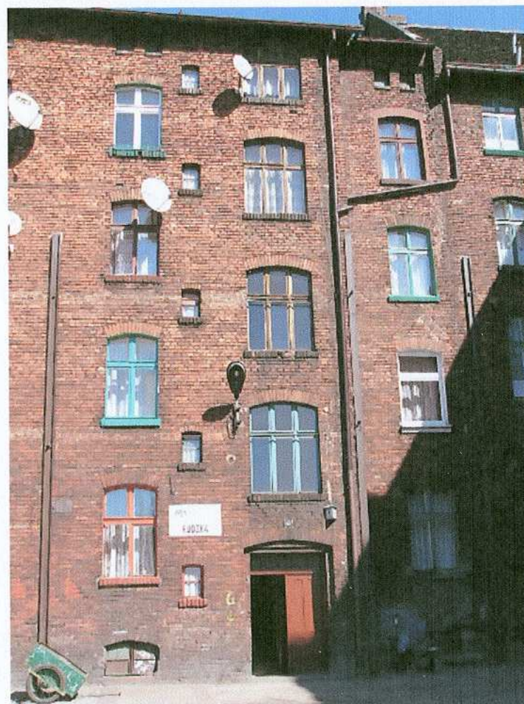
6. fragment elewacji południowej
