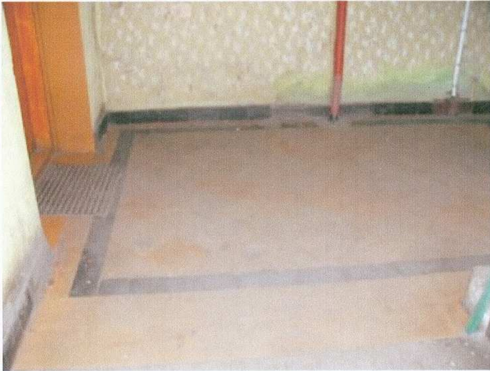
27. klatka schodowa - posadzka
