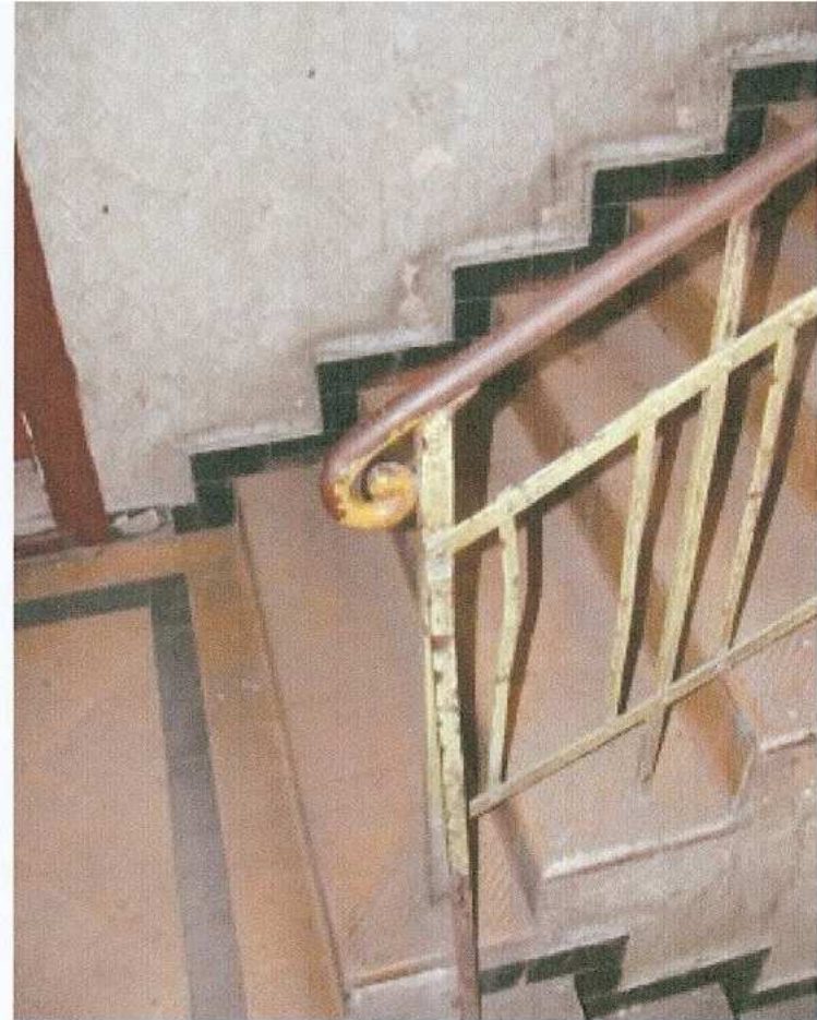
32. schody wraz z barierą
