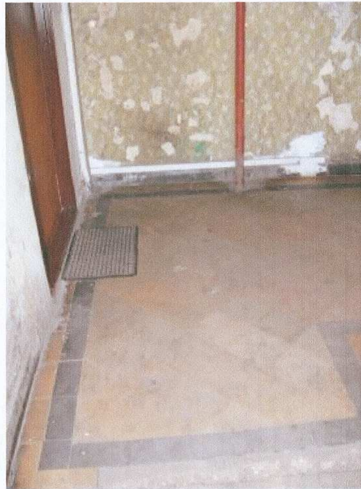
20 klatka schodowa – posadzka
