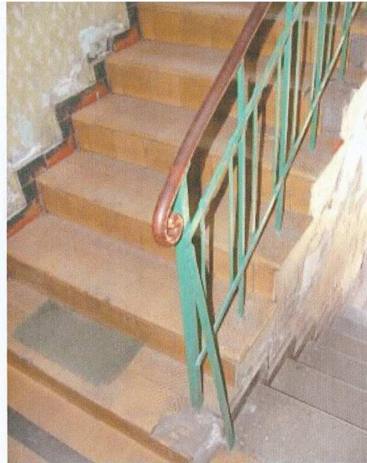
28. schody wraz z barierą
