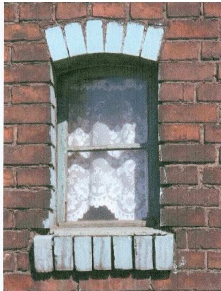
12. fragment elewacji północnej - okno
