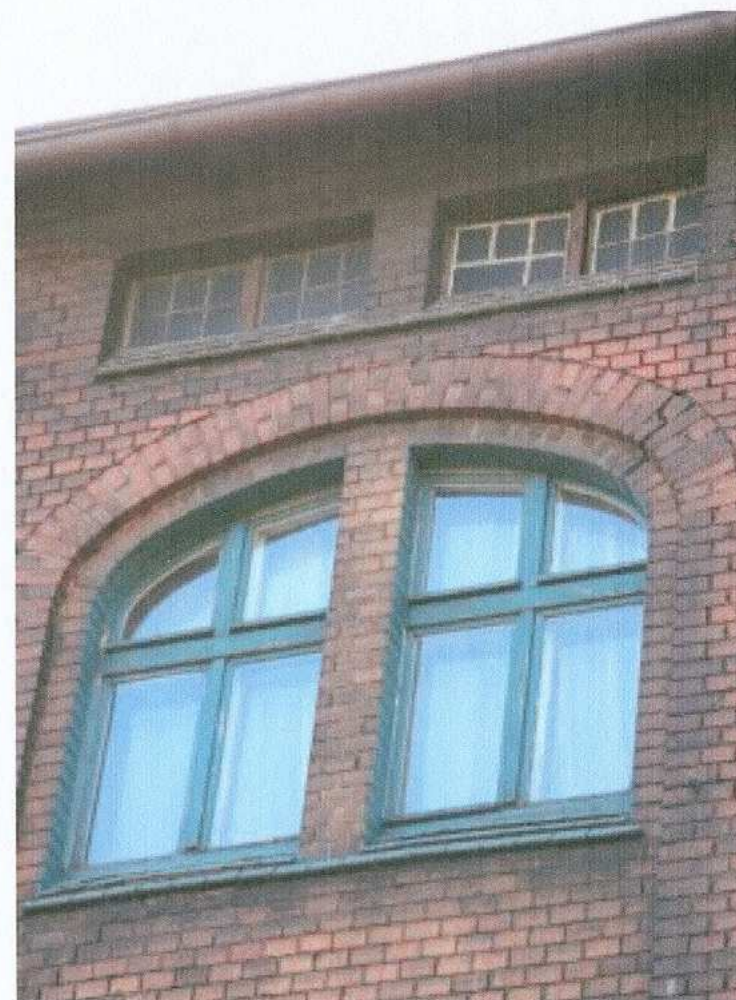
10. fragment elewacji północnej - okna
