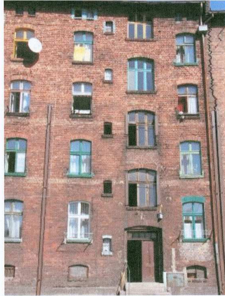
8. fragment elewacji południowej
