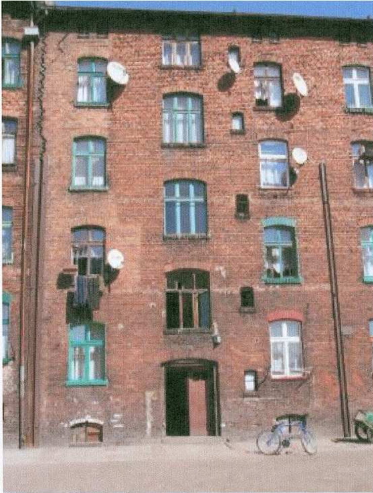
7. fragment elewacji południowej
