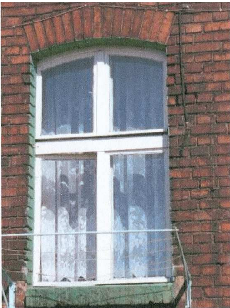
15. fragment elewacji południowej – okno
