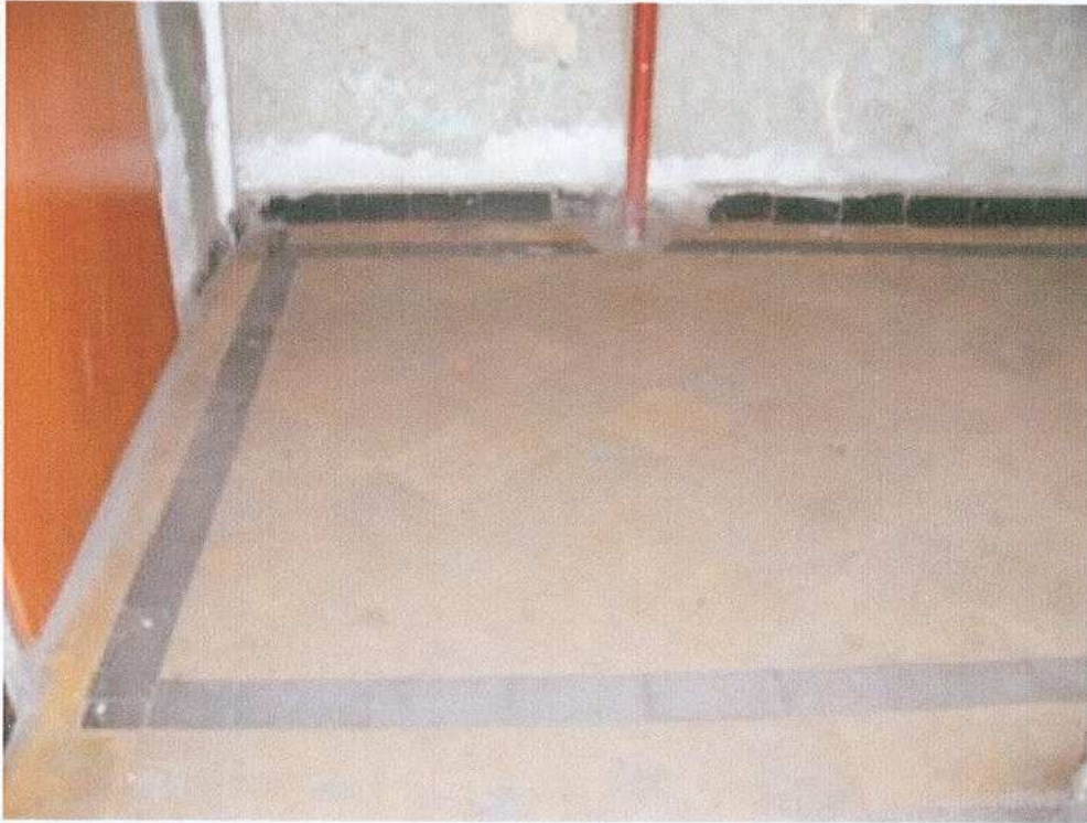
31. klatka schodowa - posadzka
