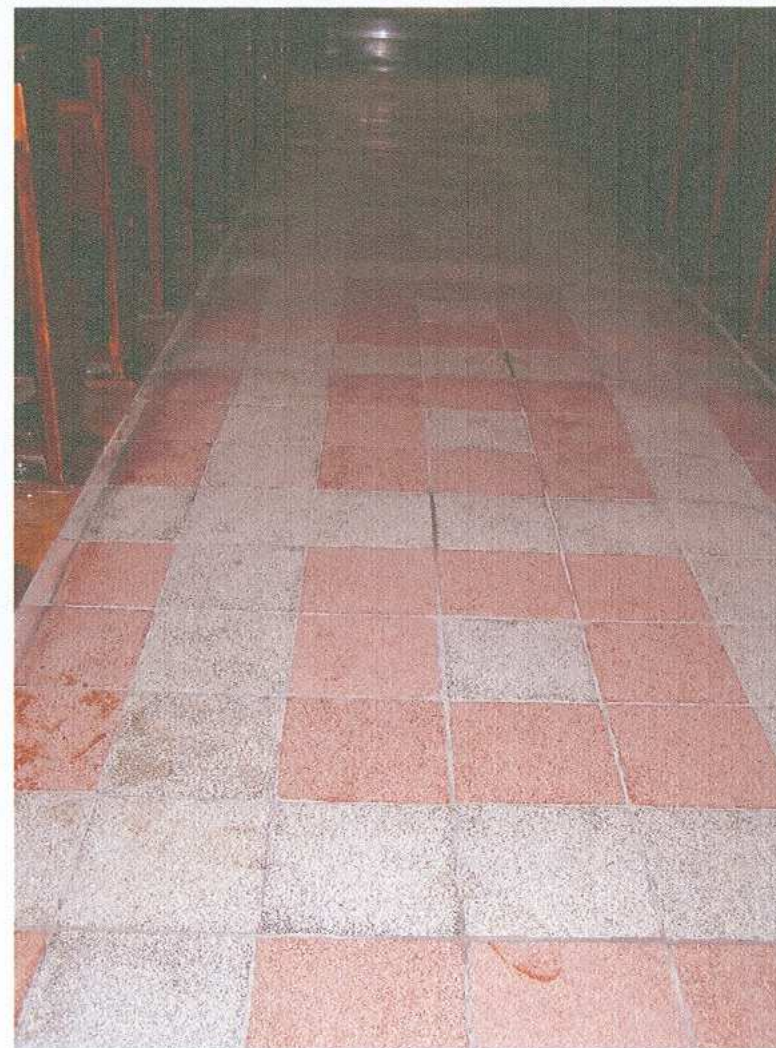
28. posadzka w nawie
