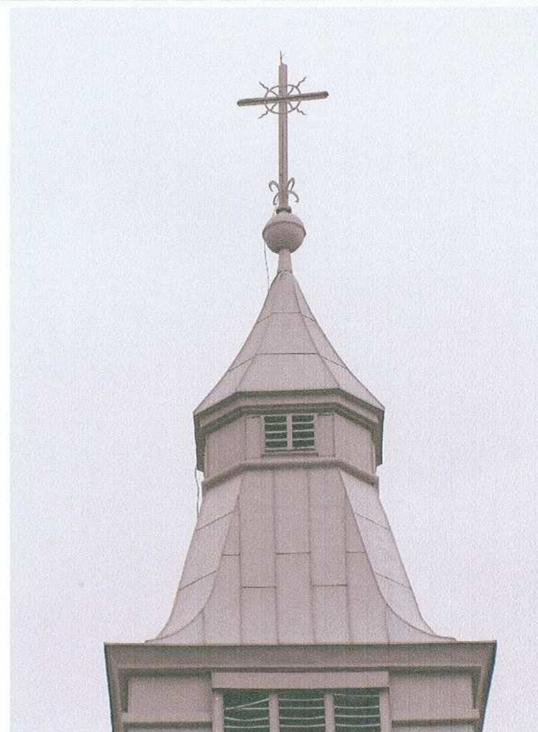
10. hełm wieży zachodniej
