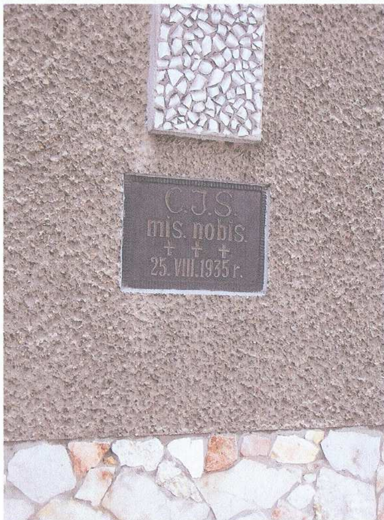
7. fragment elewacji wschodniej z tablicą upamiętniającą konsekrację kościoła i cokołem
