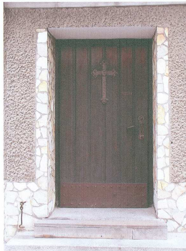
16. boczne drzwi zewnętrzne
