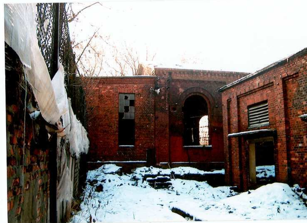
Ryc.12. Widok na elewację północną.
