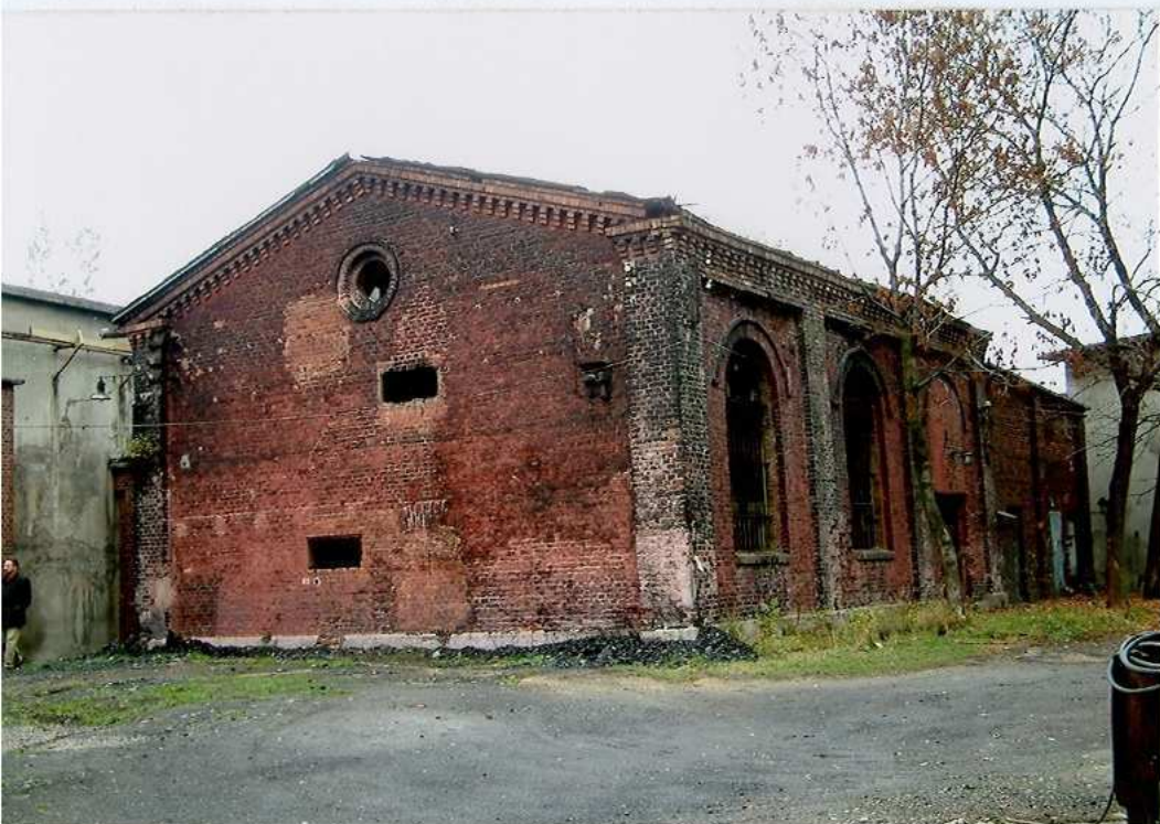
Ryc.11. Widok na budynek maszynowni.
