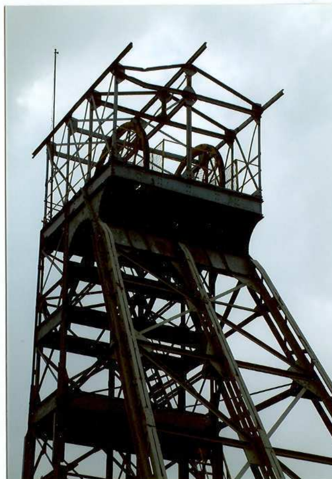
Ryc.10. Widok na szczyt wieży.
