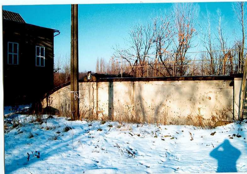
Ryc. 17. Bok kanału wentylacyjnego.
