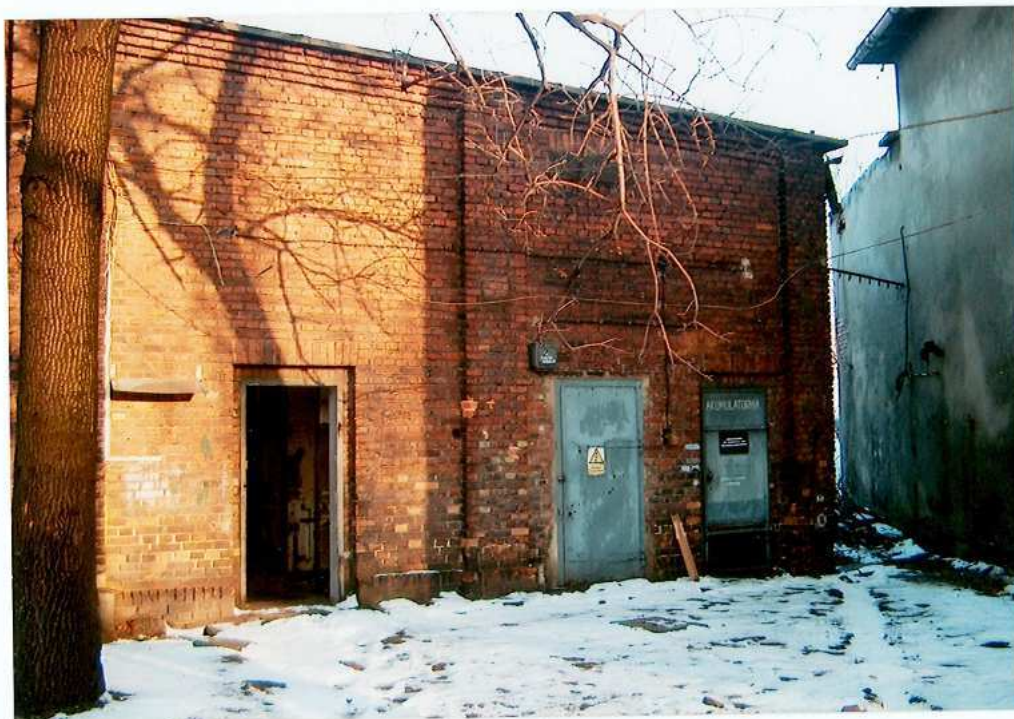
Ryc.11. Widok na budynek od strony południowej.
