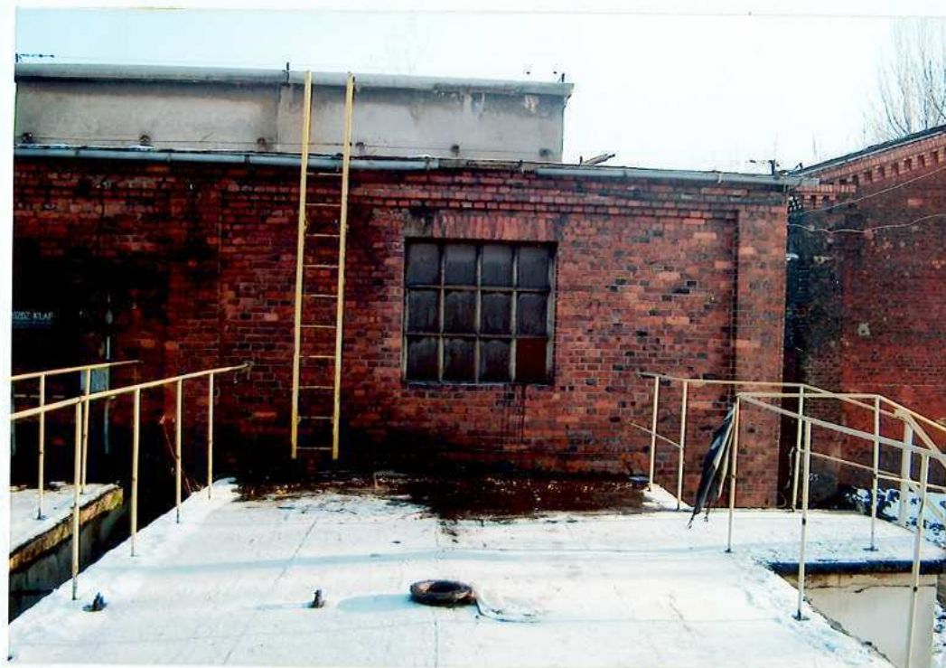
Ryc.12. Elewacja od strony kanału wentylacyjnego.
