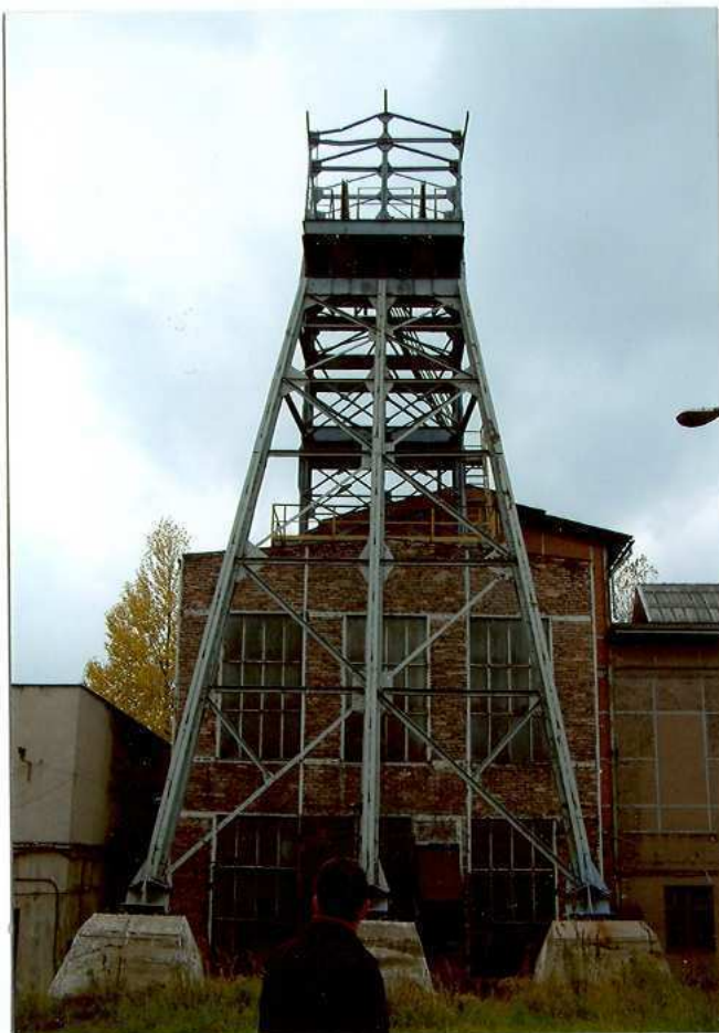
Ryc.9. Widok na trzon wieży od czoła .
