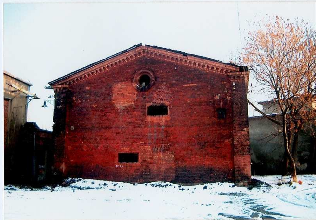
Ryc.12. Widok na elewację boczną.
