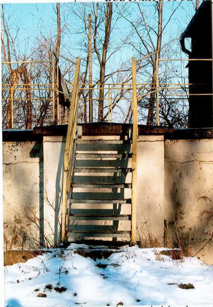
Ryc.15. Schody prowadzące na dach kanału wentylacyjnego
