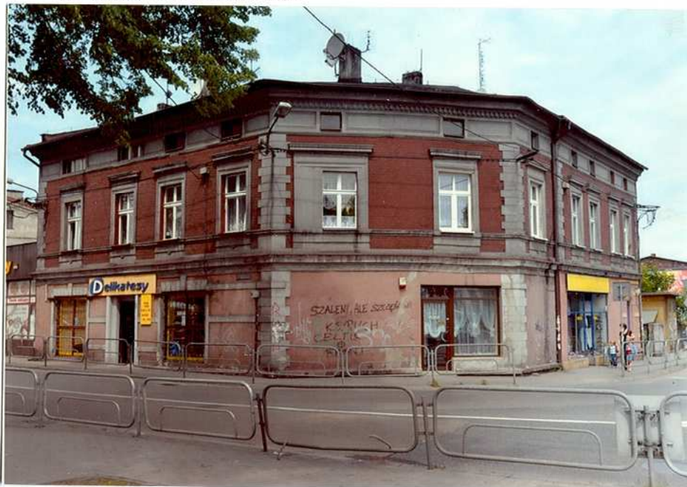
Ryc. 1. Widok ogólny od strony południowo - zachodniej.
