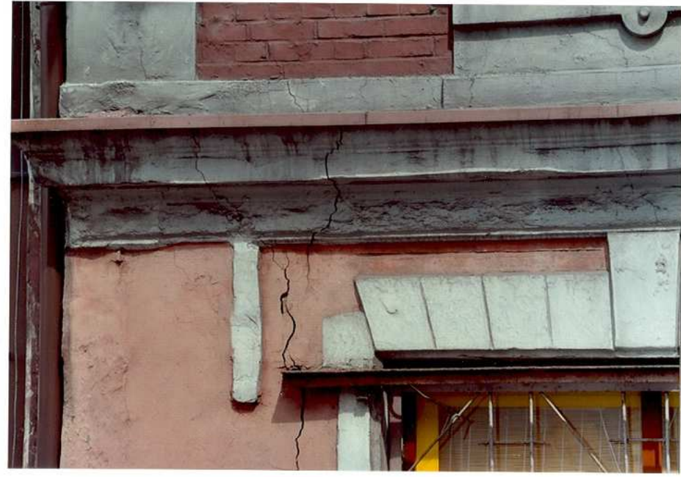
Fot. 7. Gzyms międzykondygnacyjny.
