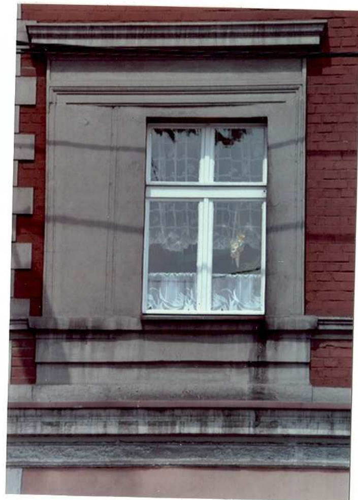
Fot. 14. Okno pierwszego piętra.
