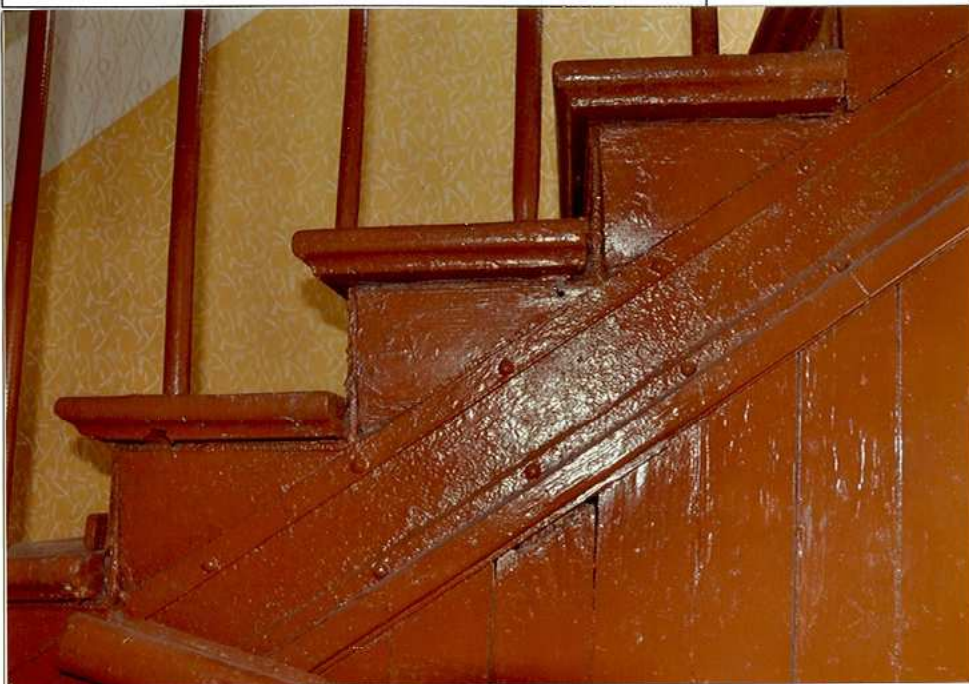
Fot. 36. Belka policzkowa schodów – parter.
