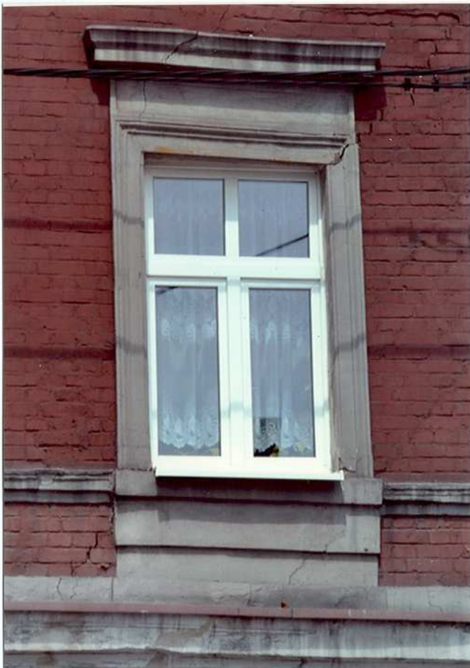
Fot. 15. Okno pierwszego piętra.
