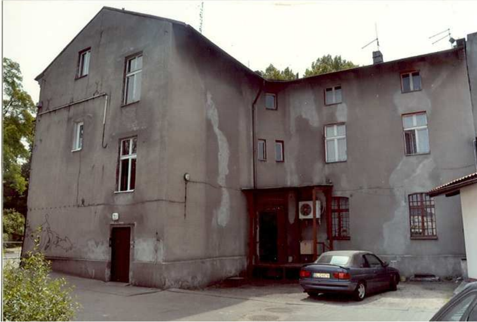
Fot. 23. Elewacja wschodnia.
