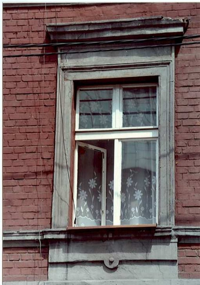
Fot. 9. Okno pierwszego piętra.
