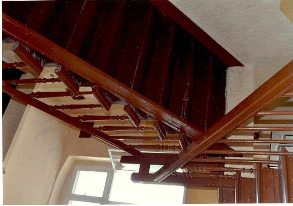
Fot. 39. Widok na spód biegu schodów.
