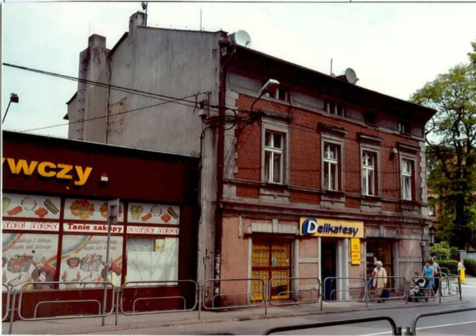
Fot. 1. Widok od strony północno – zachodniej
