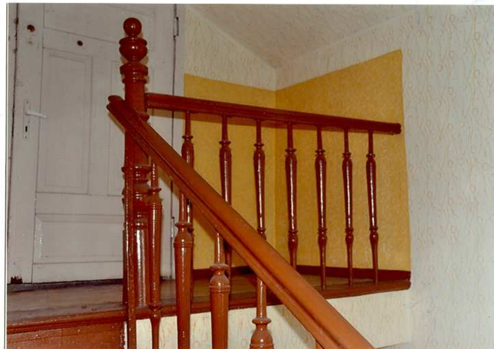
Fot. 38. Balustrada – piętro.
