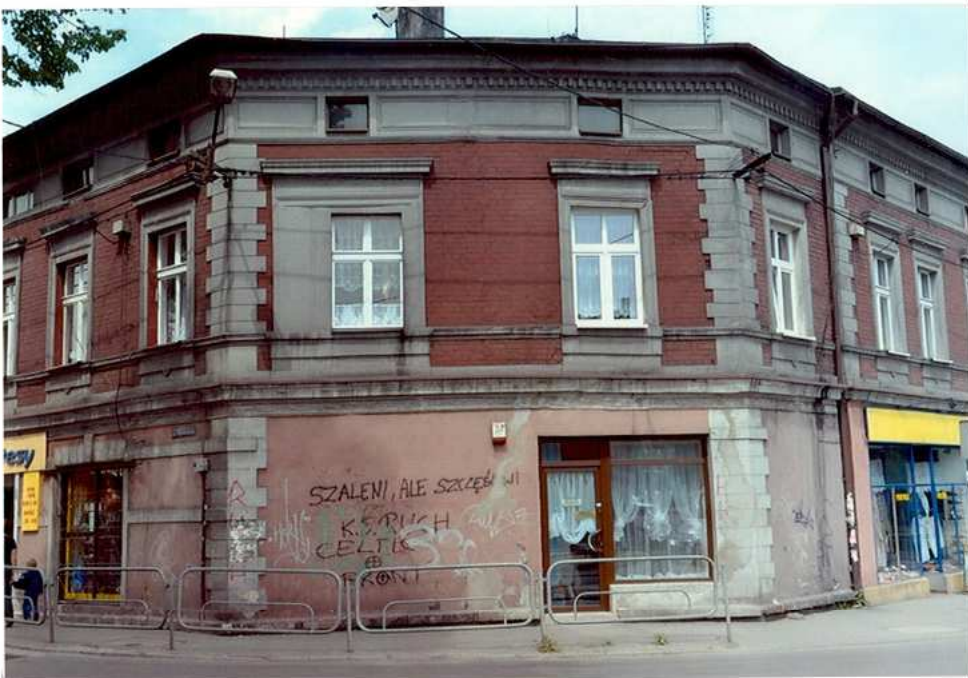
Fot. 12. Naroże – elewacja południowo – zachodnia.
