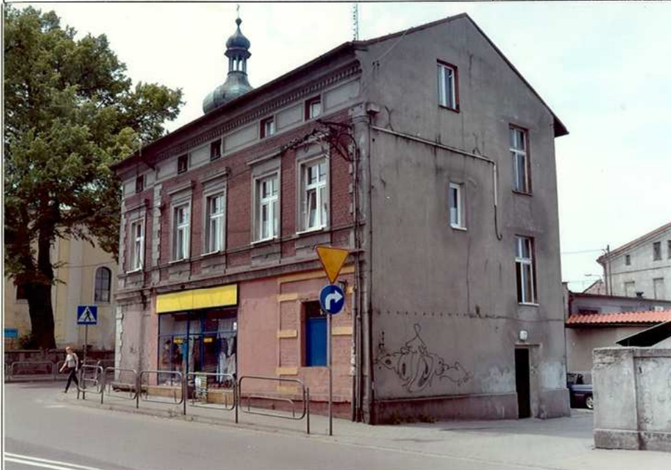
Fot. 22. Widok od strony południowo – wschodniej.
