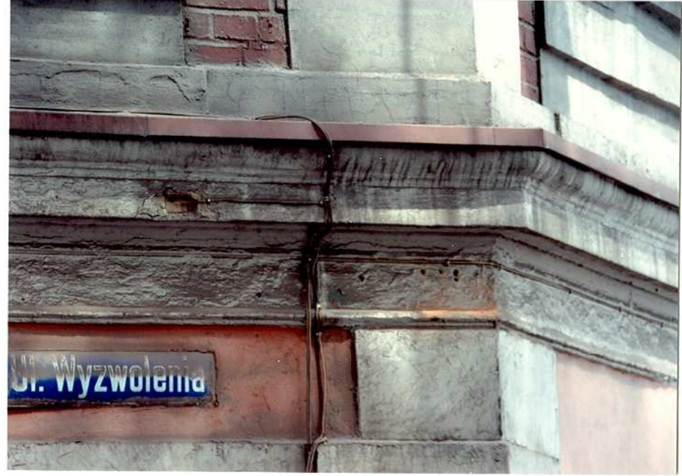
Fot. 8. Gzyms międzykondygnacyjny.
