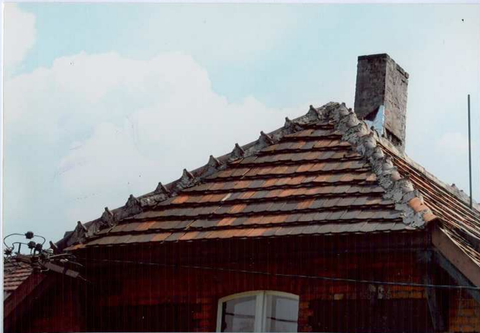
Fot. 26. Naczótek - elewacja północna.
