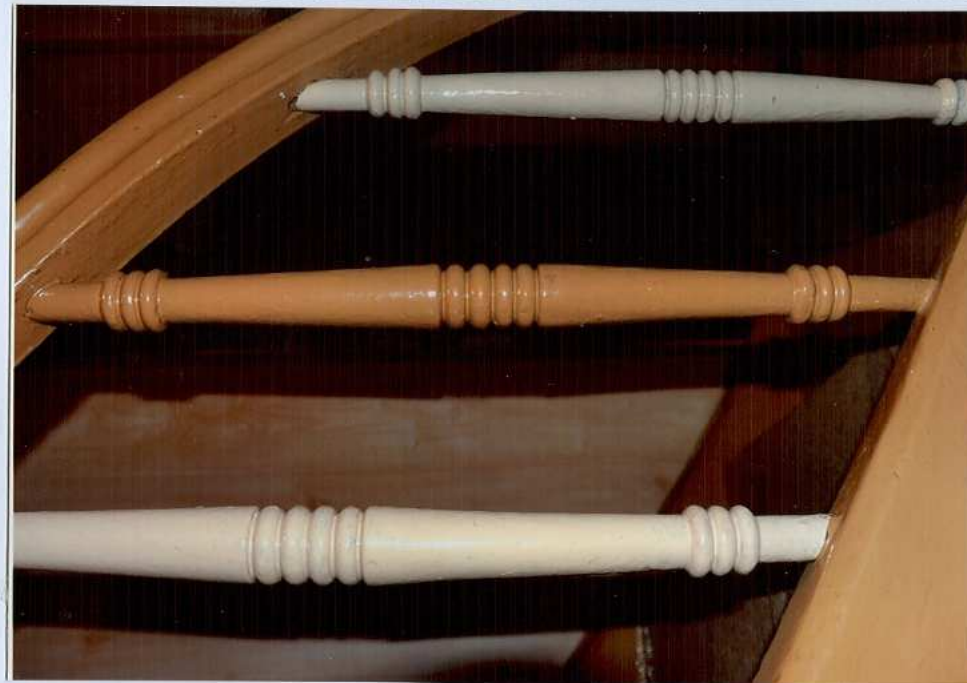
Fot. 38. Tralki balustrady.
