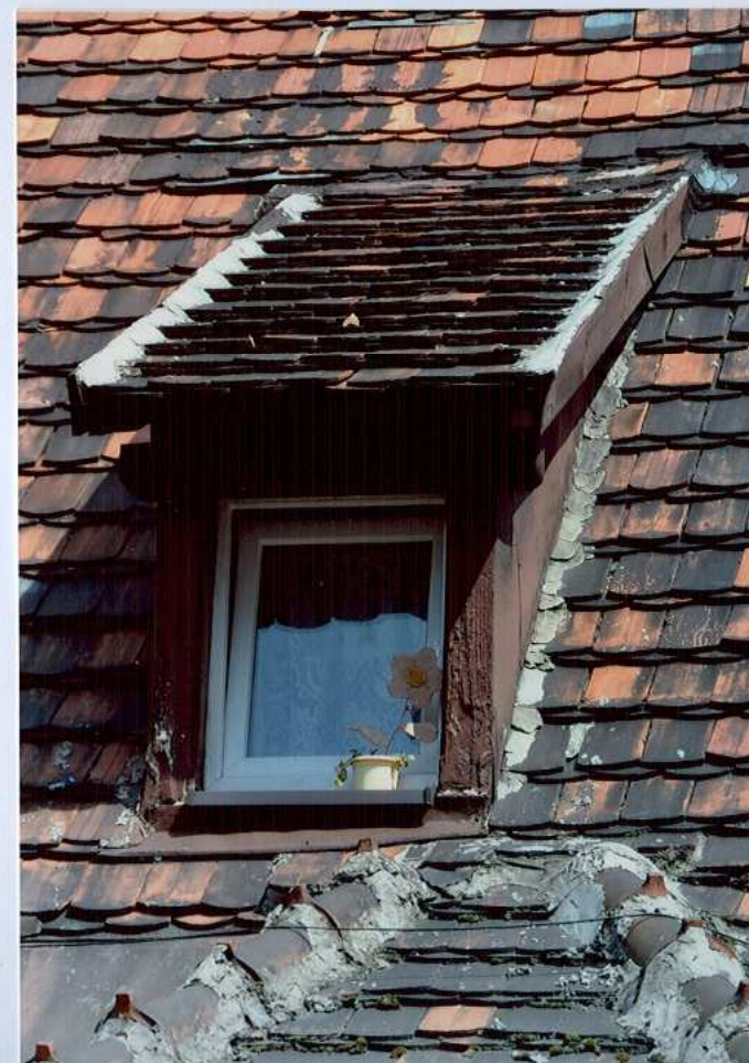
Fot. 16. Okno poddasza.
