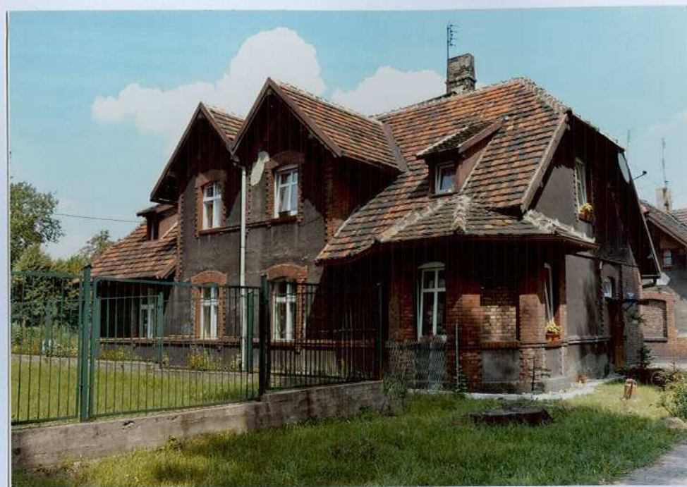
Fot. 12. Widok na budynek od strony południowo – zachodniej.
