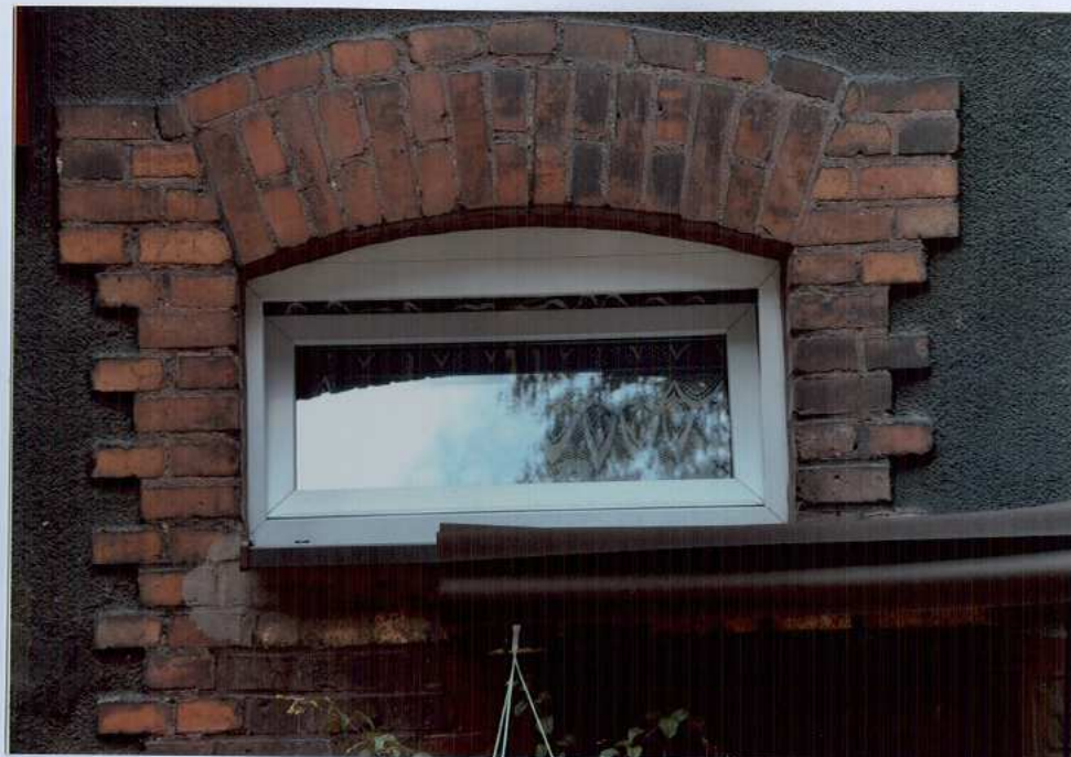
Fot. 6. Okno nad drzwiami – elewacja południowa.
