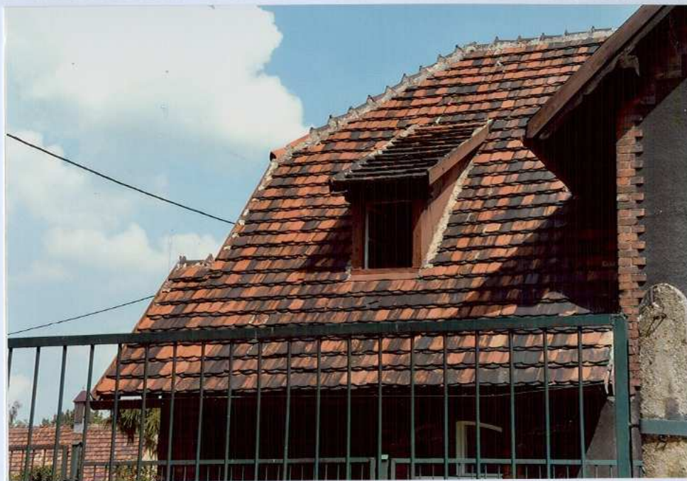
Fot. 14. Okno facjaty – elewacja zachodnia.
