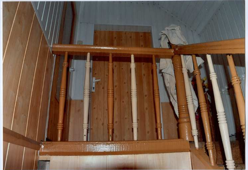
Fot. 40. Widok na piętro.
