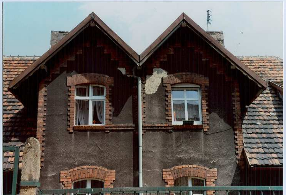
Fot. 19. Szczyty – elewacja zachodnia.
