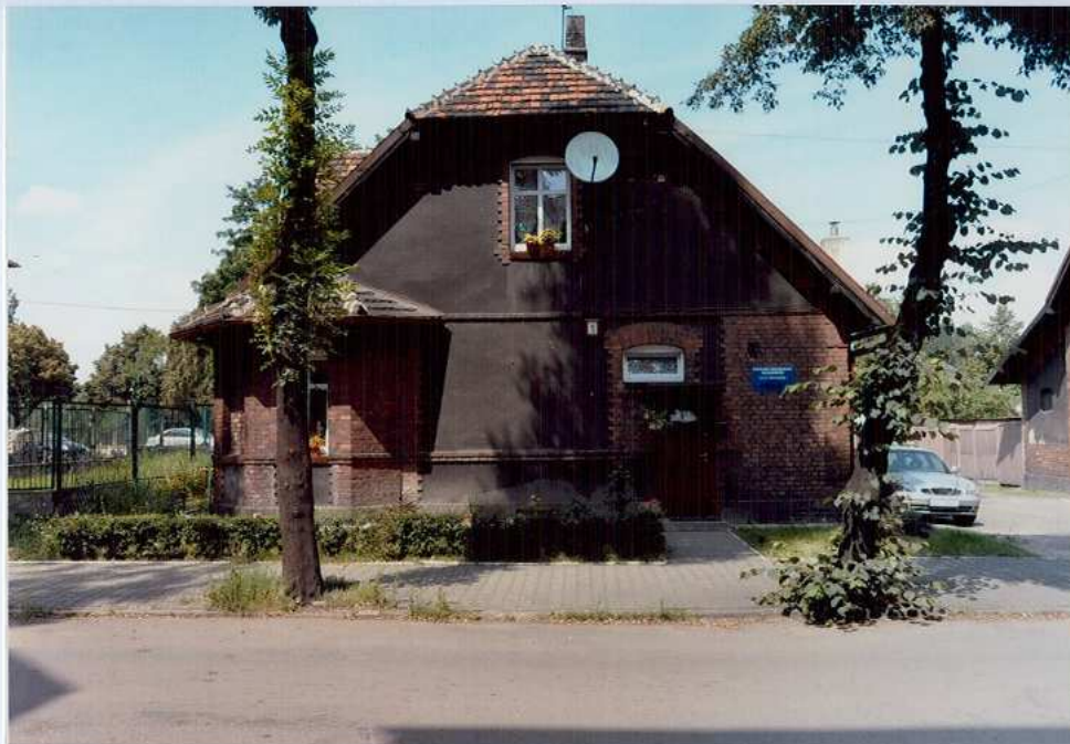
Fot. 1. Elewacja południowa.
