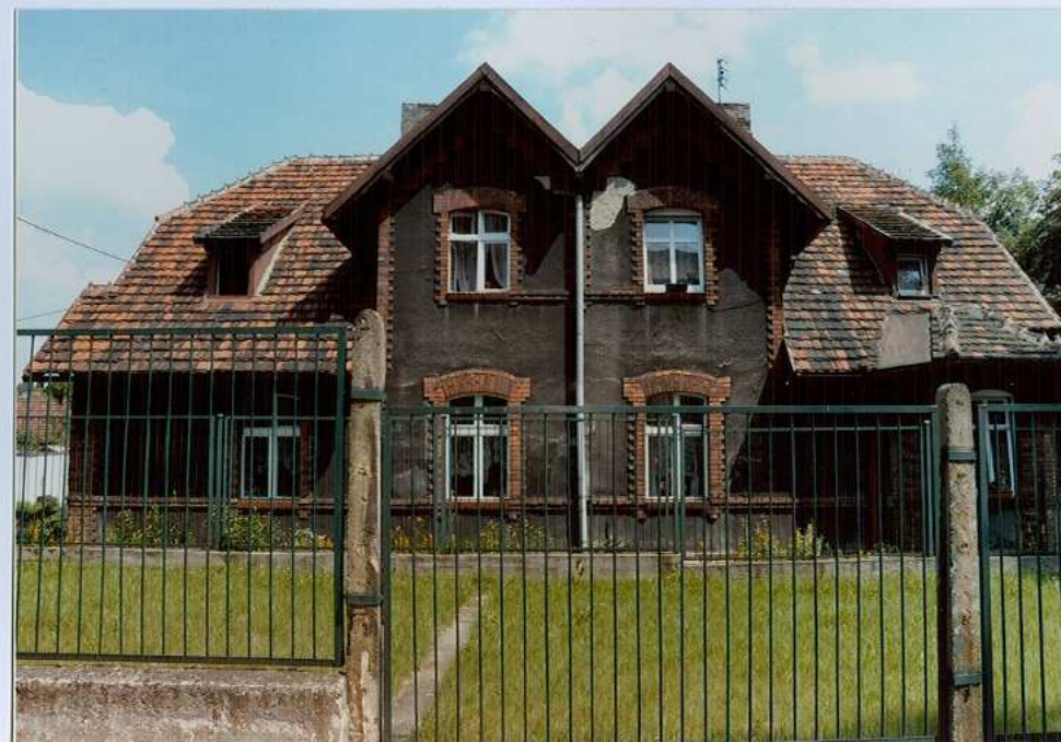
Fot. 13. Elewacja zachodnia.
