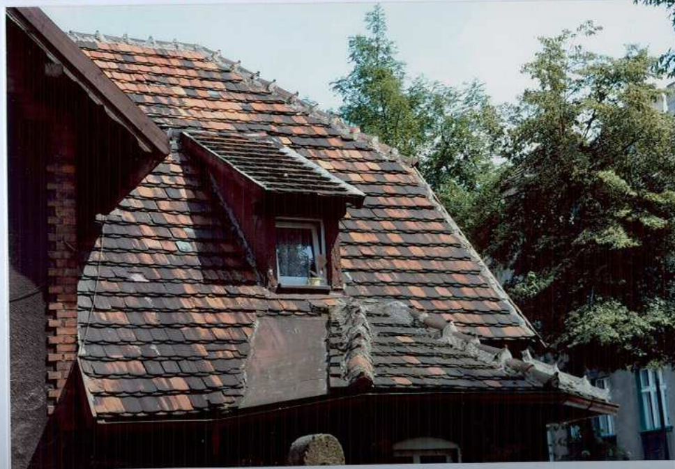
Fot. 15. Południowa strona dachu – elewacja zachodnia.
