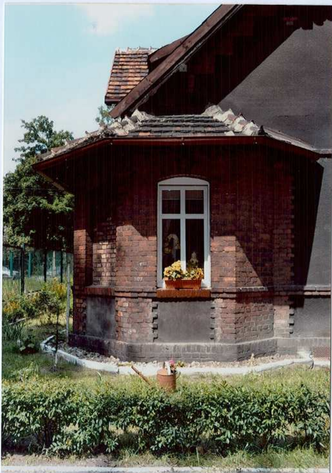
Fot. 8. Wykusze – elewacja południowa.
