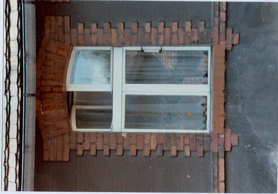
Fot. 34. Okno – elewacja wschodnia.
