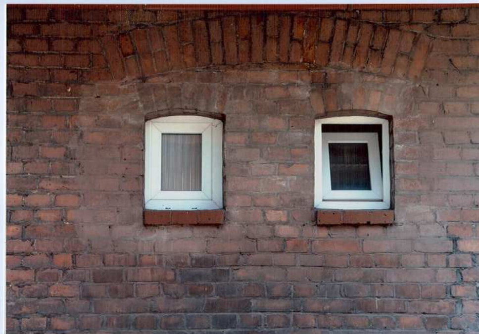
Fot. 32. Okna do łazienek – elewacja wschodnia.
