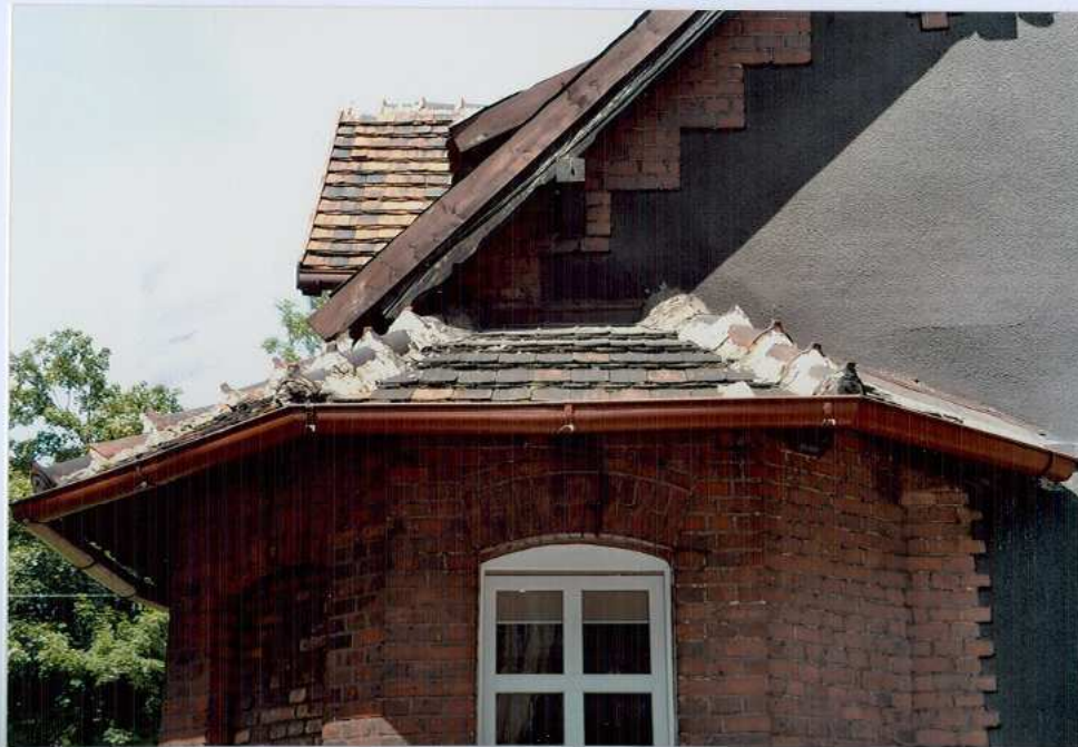
Fot. 2. Góma partia wykusza – elewacja południowa.
