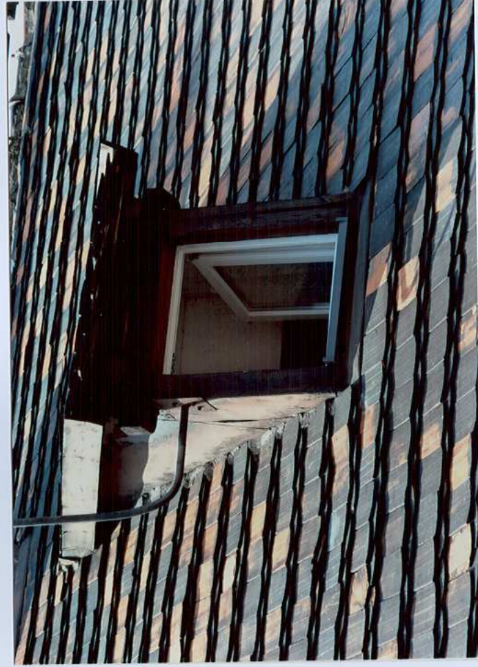
Fot. 36. Okno poddasza.
