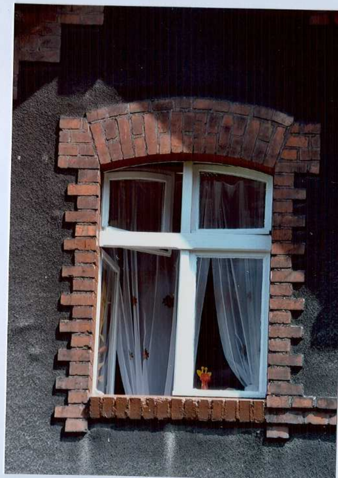
Fot. 21. Okno piętra – elewacja zachodnia.
