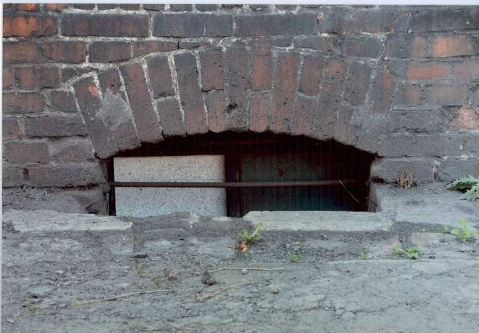
Fot. 31. Okno do piwnicy.
