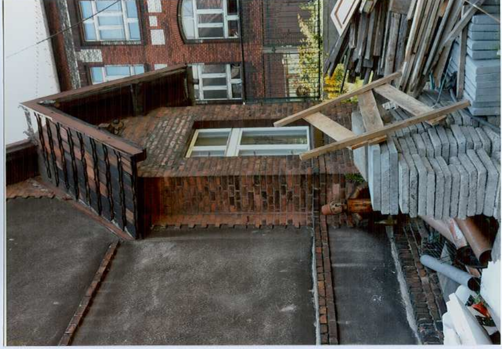
Fot. 24. Widok na ryzalit od strony północno – wschodniej.
