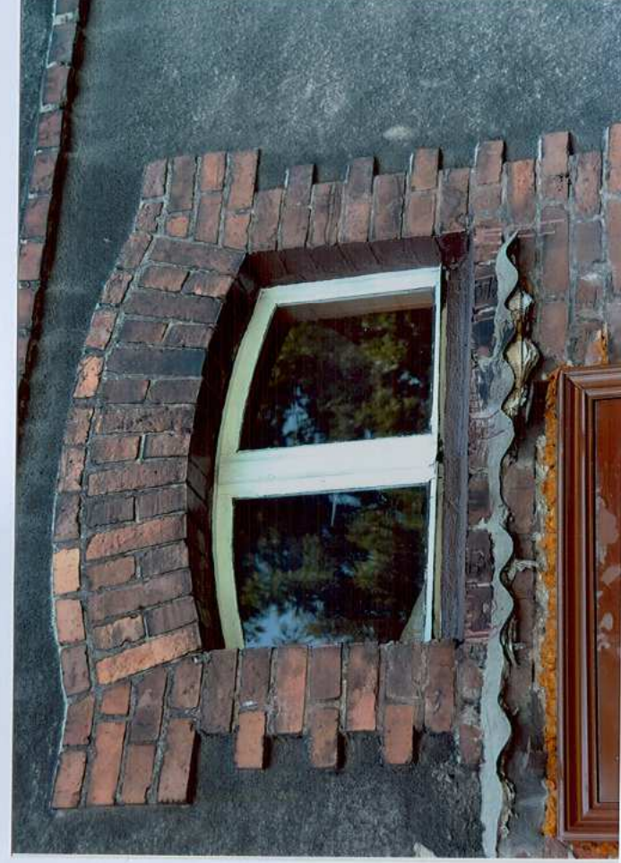
Fot. 30. Okno nad wejściem – doświetlające klatkę schodową.
