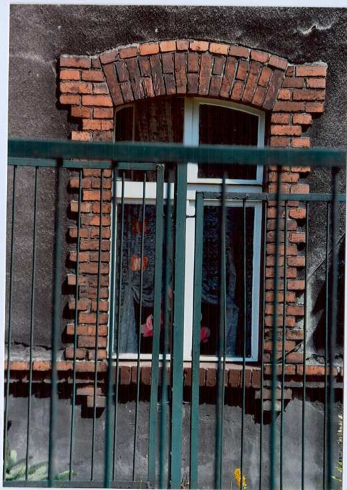
Fot. 20. Okno parteru – elewacja zachodnia.
