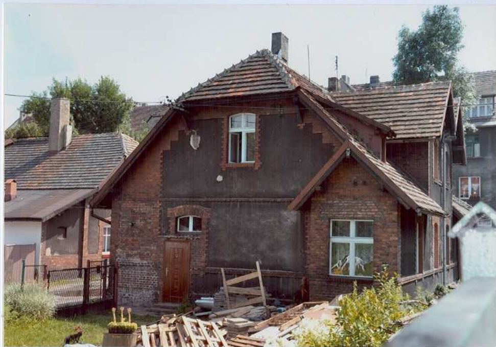
Fot. 25. Elewacja północna.
