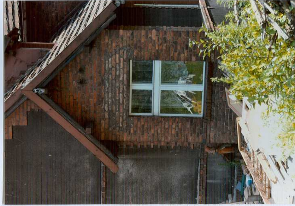
Fot. 23. Ryzalit – elewacja północna.
