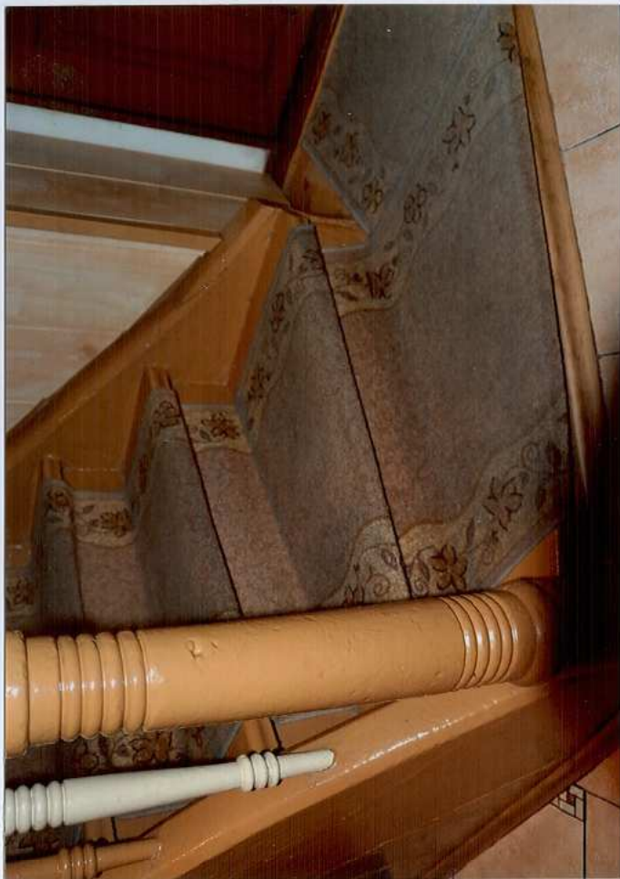
Fot. 36. Schody wewnętrzne – dolna partia.
