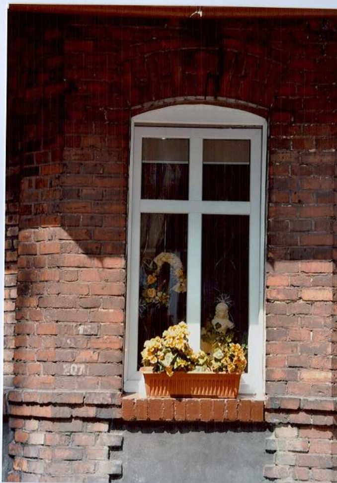
Fot. 9. Okno – wykusz.
