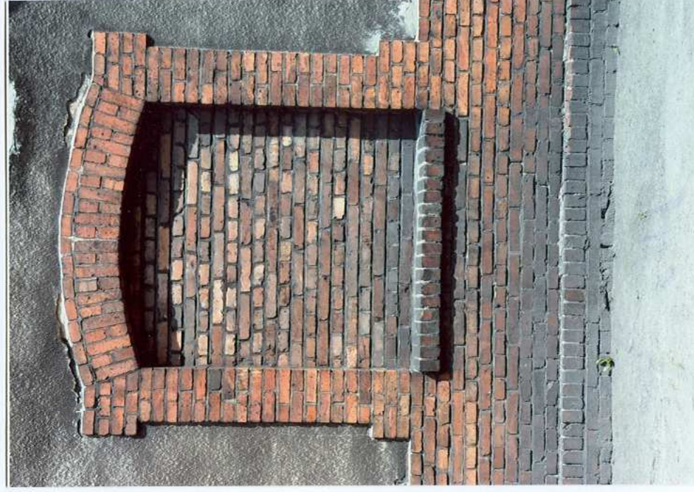
Fot. 22. Płycina ceglana – elewacja zachodnia.
