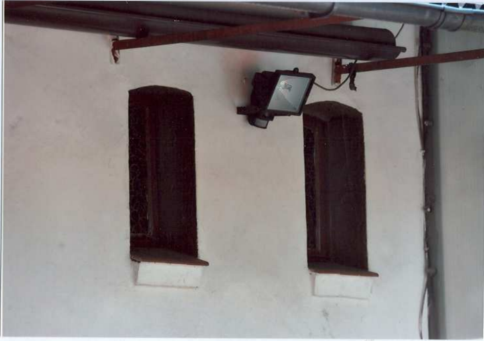
Fot. 33. Okna do łazienki— elewacja północna.
