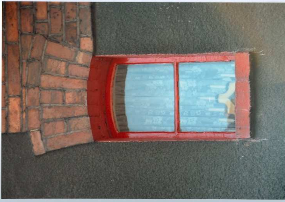
Fot. 30. Okno na piętrze – elewacja wschodnia.
