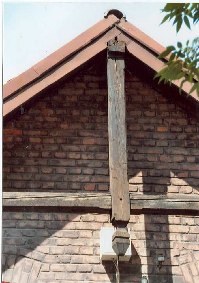
Fot. 14. Ściągacz więźby dachowej.
