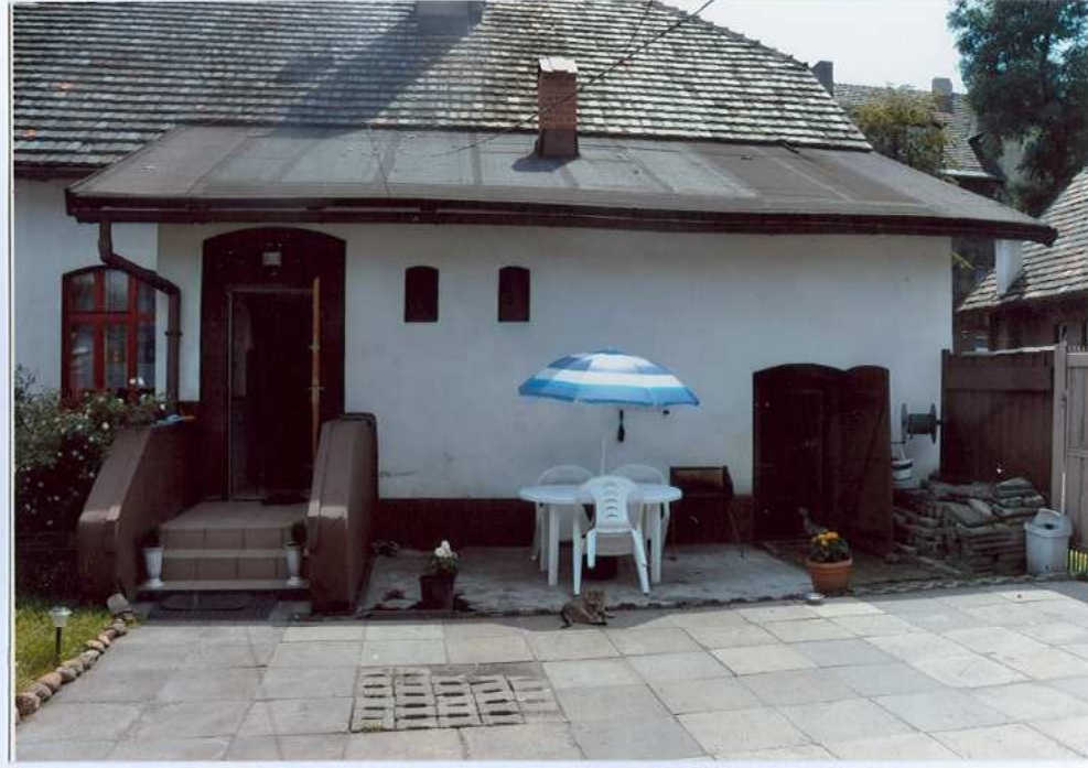
Fot. 34. Strona zachodnia elewacji północnej.
