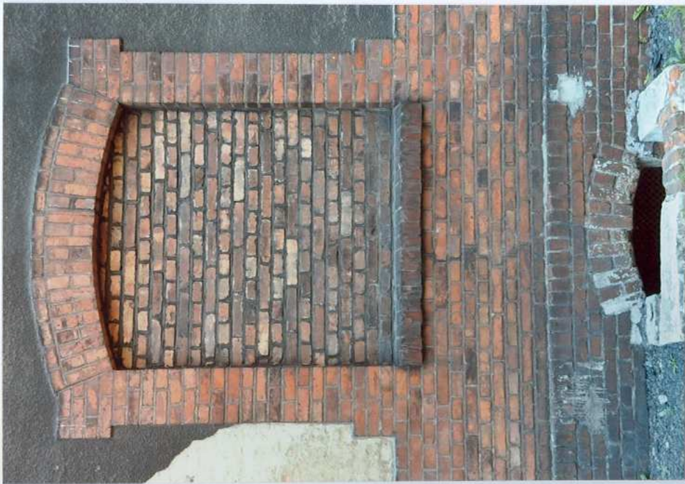
Fot. 29. Płyca ceglana – elewacja wschodnia.
