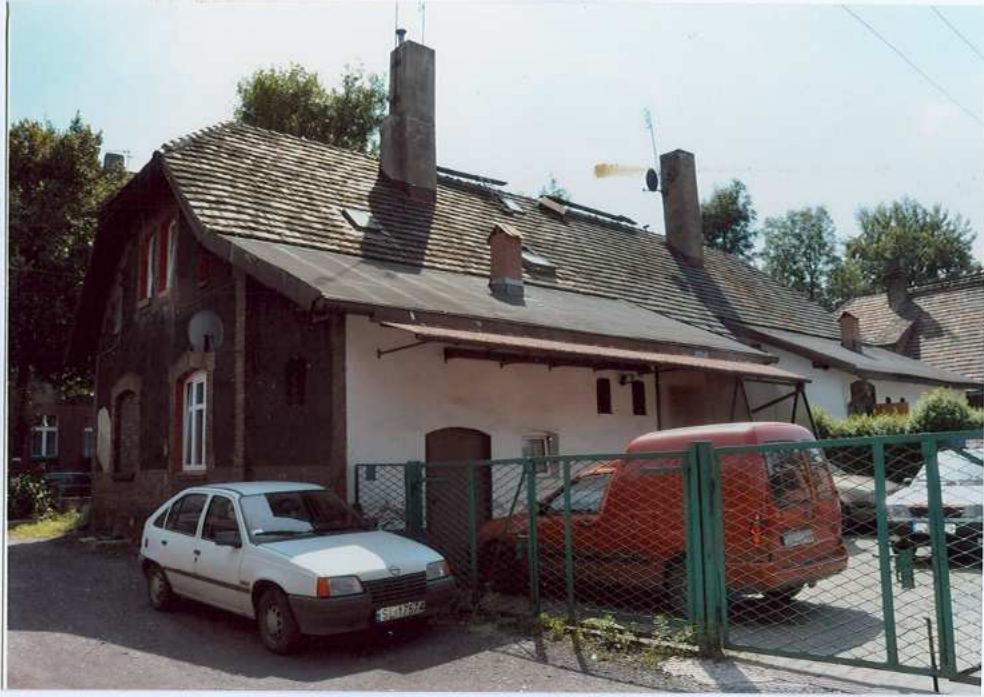
Fot. 32. Widok od strony północno wschodniej.
