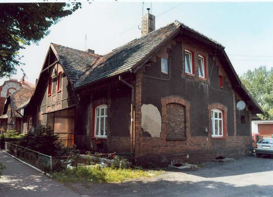
Ryc. 1. Widok ogólny od strony południowo – wschodniej.
