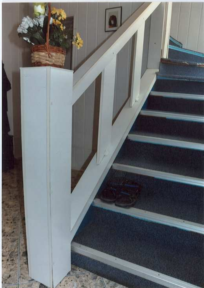
Fot. 39. Widok na balustradę schodów – mieszkanie po stronie zachodniej.
