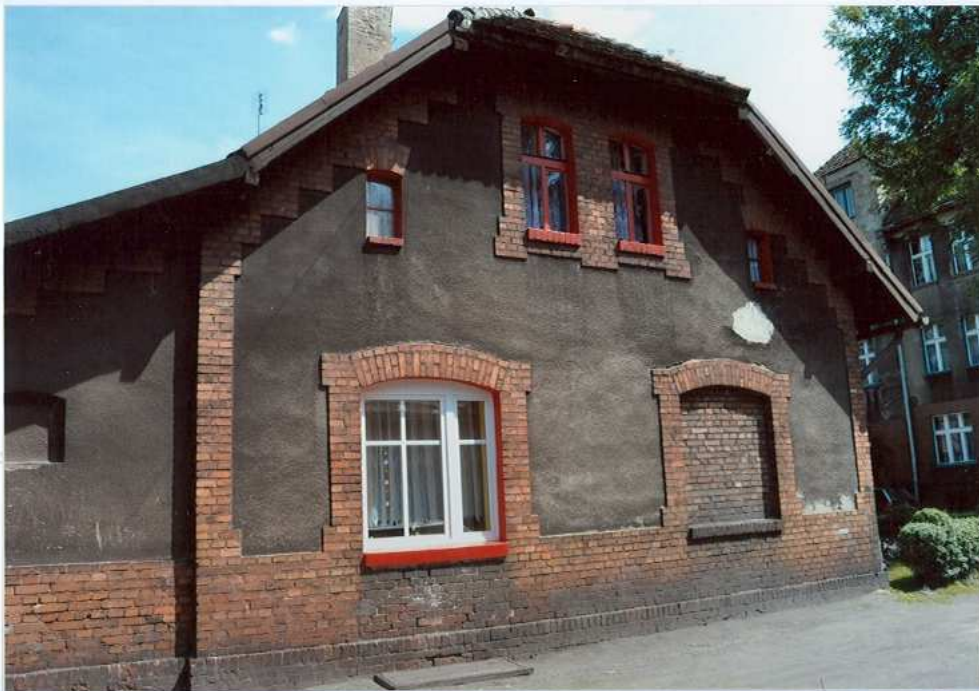
Fot. 17. Elewacja zachodnia.
