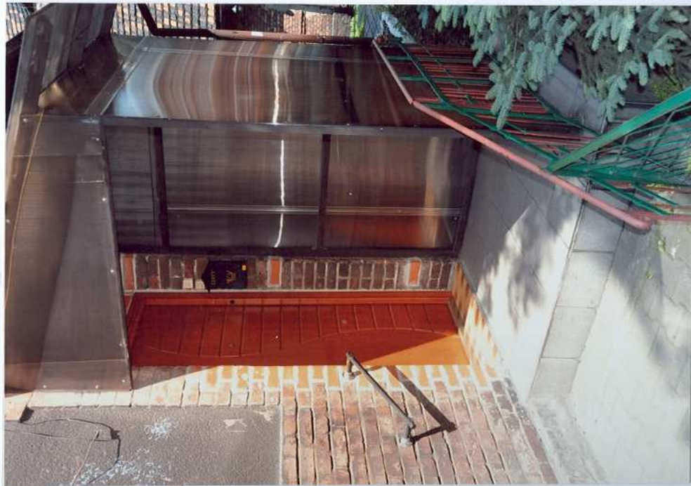
Fot. 11. Widok na drzwi wejściowe.
