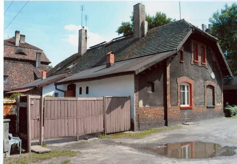
Fot. 18. Widok od strony północno – zachodniej.
