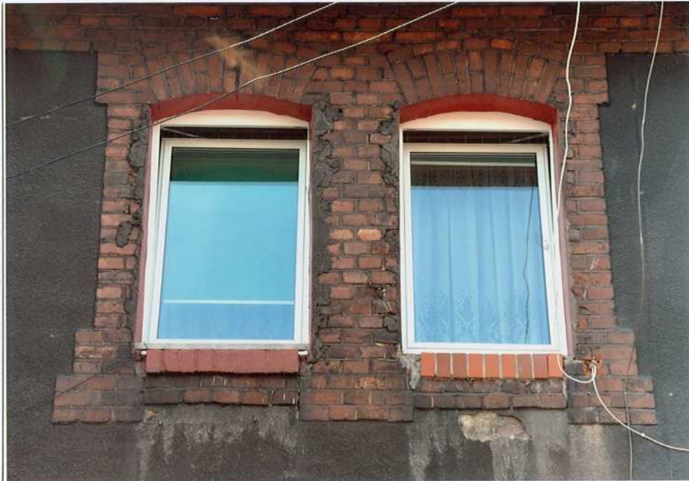
Fot. 27. Okna piętra – elewacja wschodnia.
