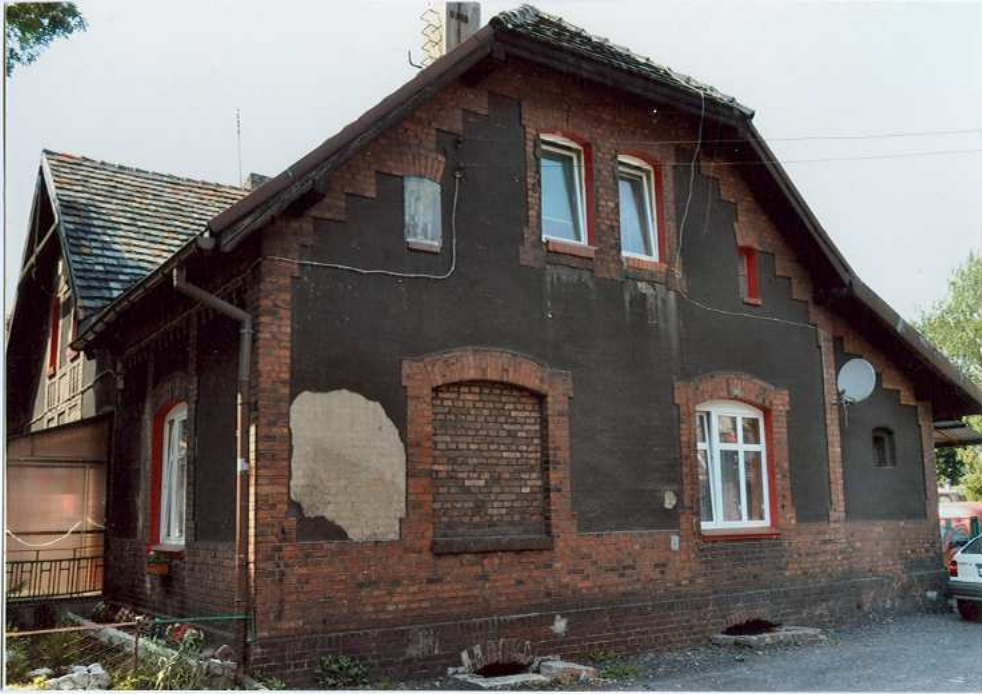
Fot. 26. Elewacja wschodnia.
