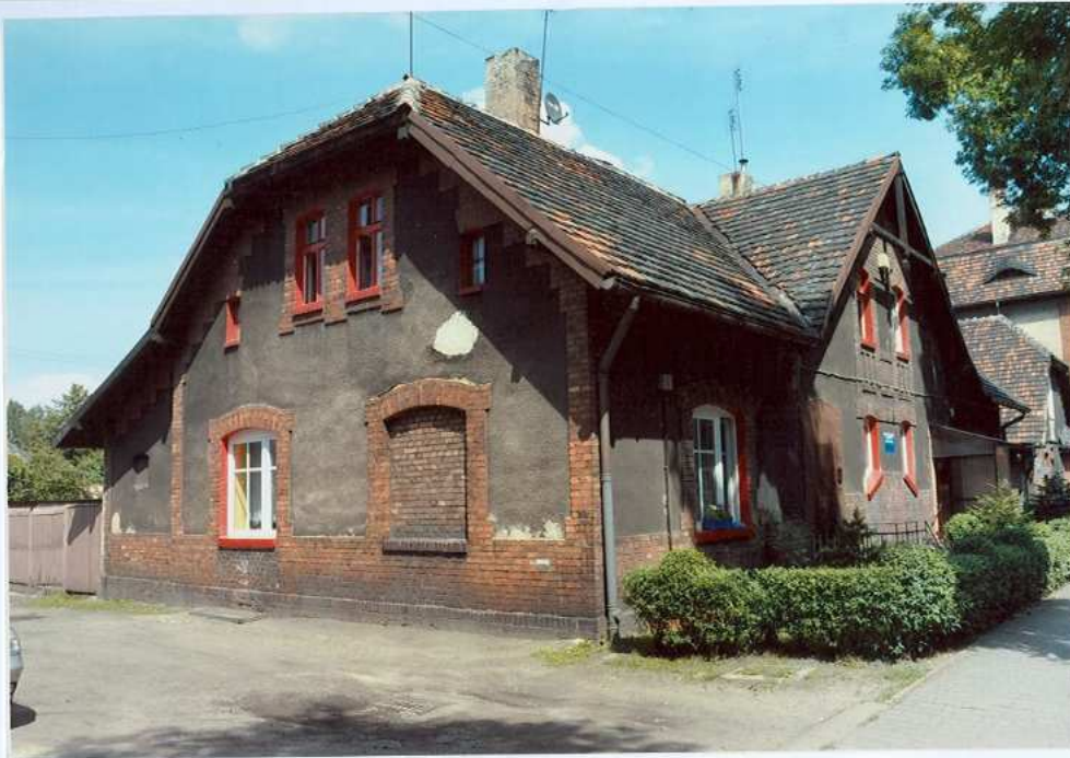
Fot. 16. Widok od strony południowo – zachodniej.
