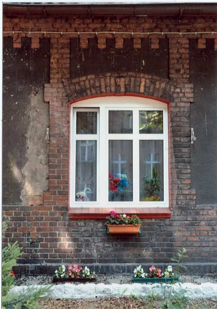
Fot. 13. Okno parteru – elewacja południowa.
