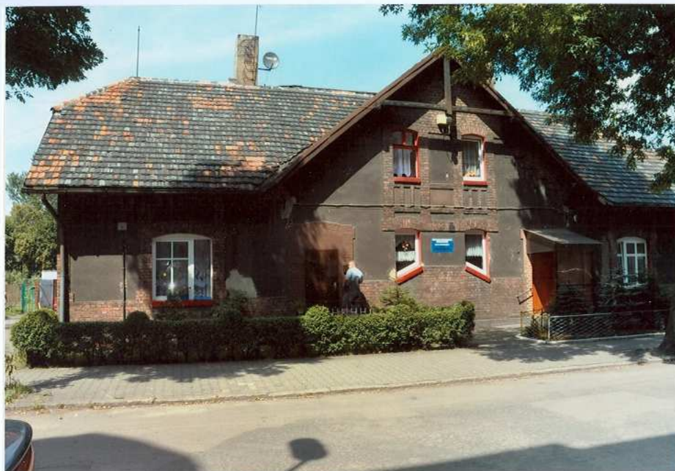
Fot. 1 Elewacja południowa.
