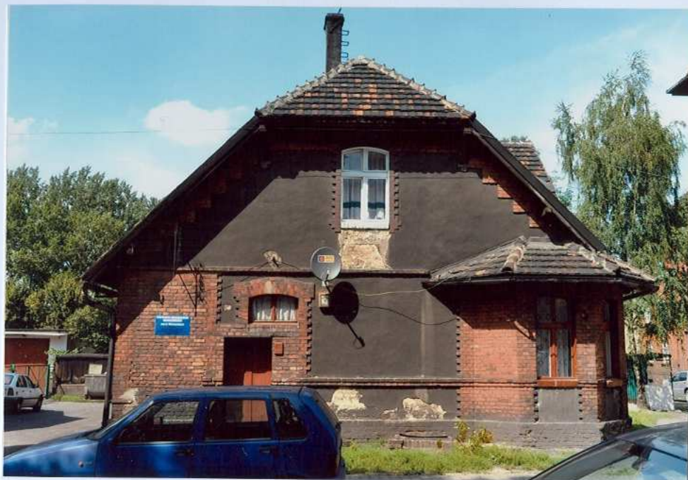
Fot. 1. Elewacja południowa.
