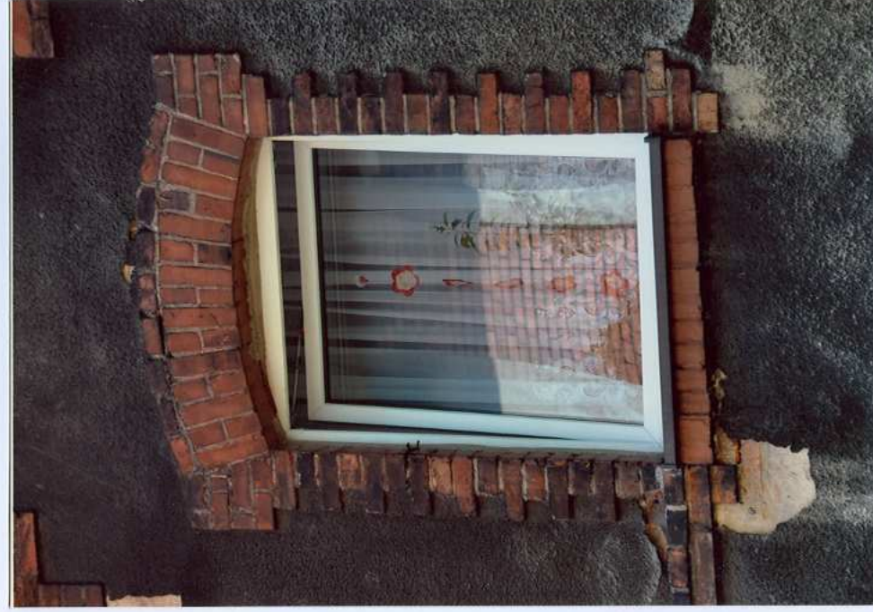
Fot. 20. Okno na piętrze - elewacja wschodnia.
