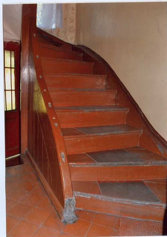
Fot. 44. Widok na klatkę schodową.
