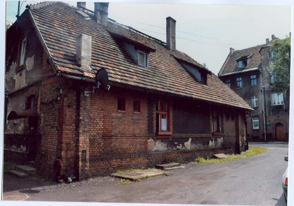
Fot. 25. Widok na budynek od strony północno – zachodniej.
