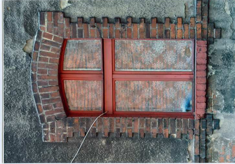
Fot. 19. Okno na parterze – elewacja wschodnia.
