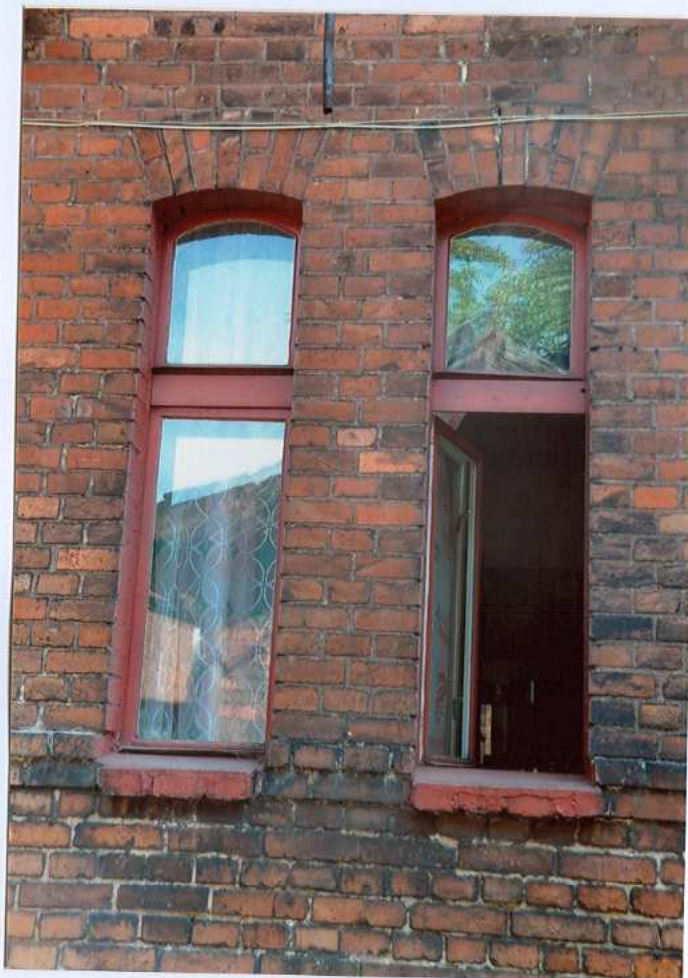
Fot. 38. Okna ryzalitu – elewacja północna.
