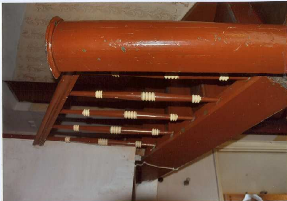
Fot. 46. Słupek balustrady.
