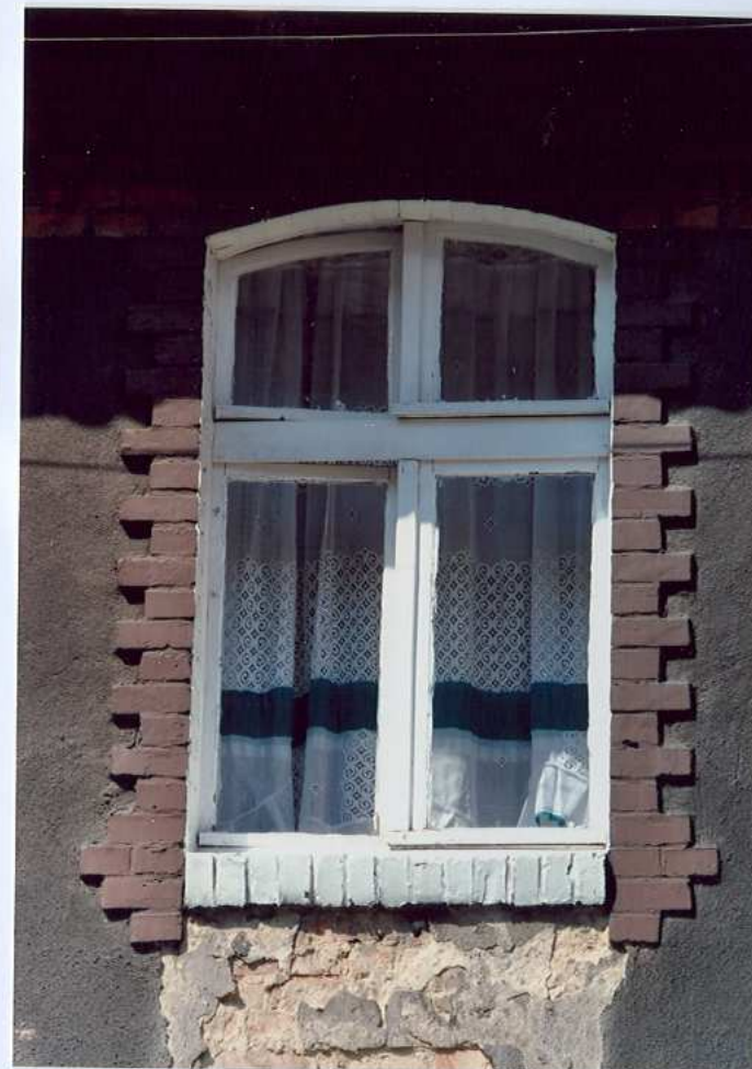
Fot. 9. Okno na piętrze – elewacja południowa.
