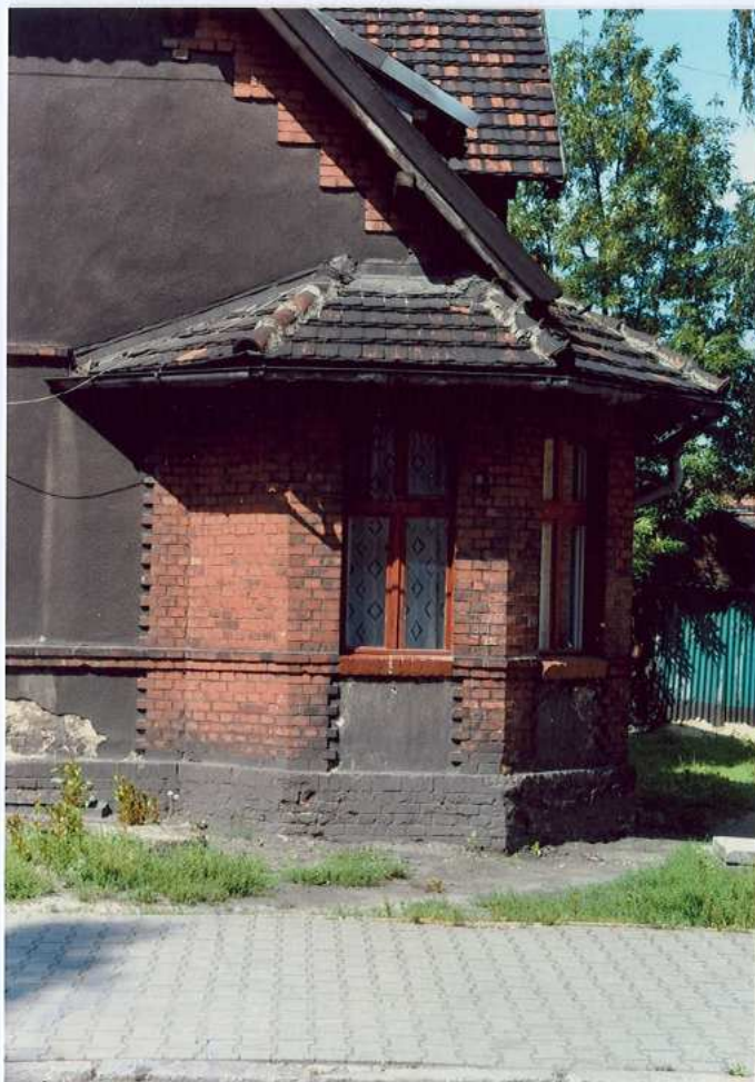
Fot. 7. Wykusze – elewacja południowa.
