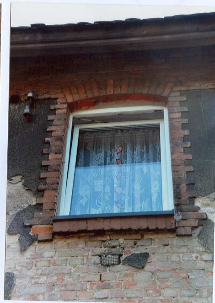
Fot. 39. Okno na piętrze – elewacja północna.
