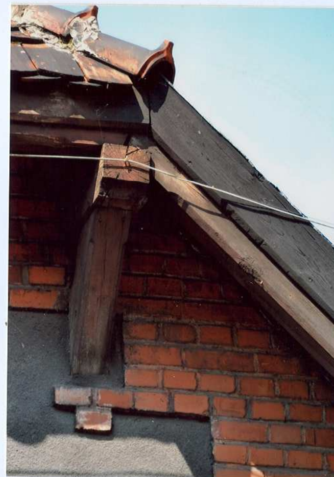
Fot. 3. Fragment połaci dachu wysuniętej i wspartej na drewnianych rysiach.
