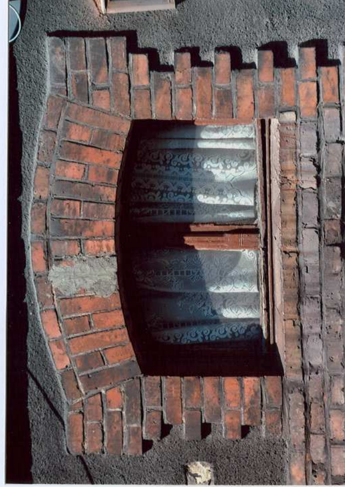
Fot. 6. Okno nad wejściem – doświetlające klatkę schodową.
