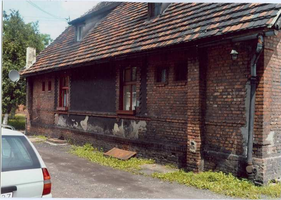
Fot. 23. Widok na budynek od strony południowo – zachodniej.
