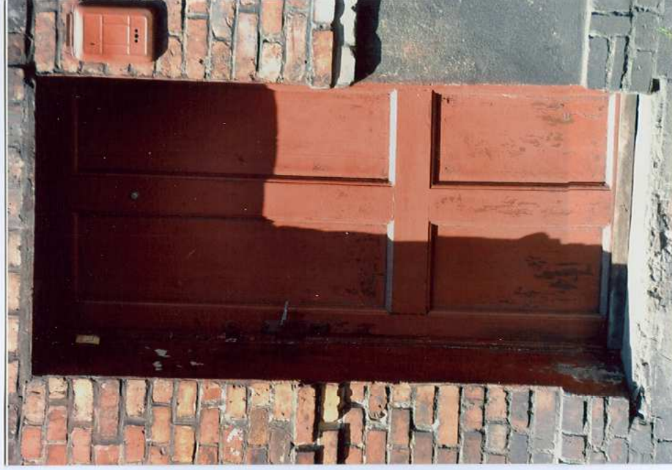
Fot. 5. Drzwi wejściowe – elewacja południowa
