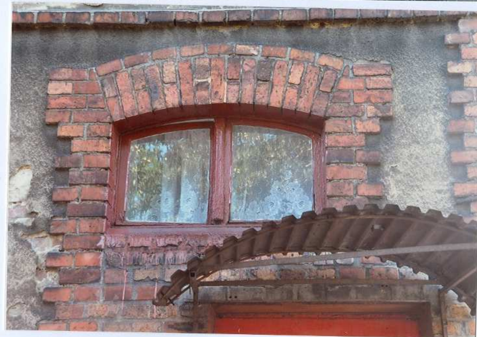
Fot. 36. Okno do klatki schodowej- elewacja północna.
