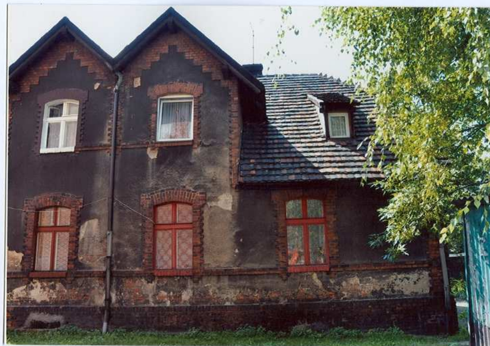
Fot. 12. Fragment północny elewacji wschodniej.
