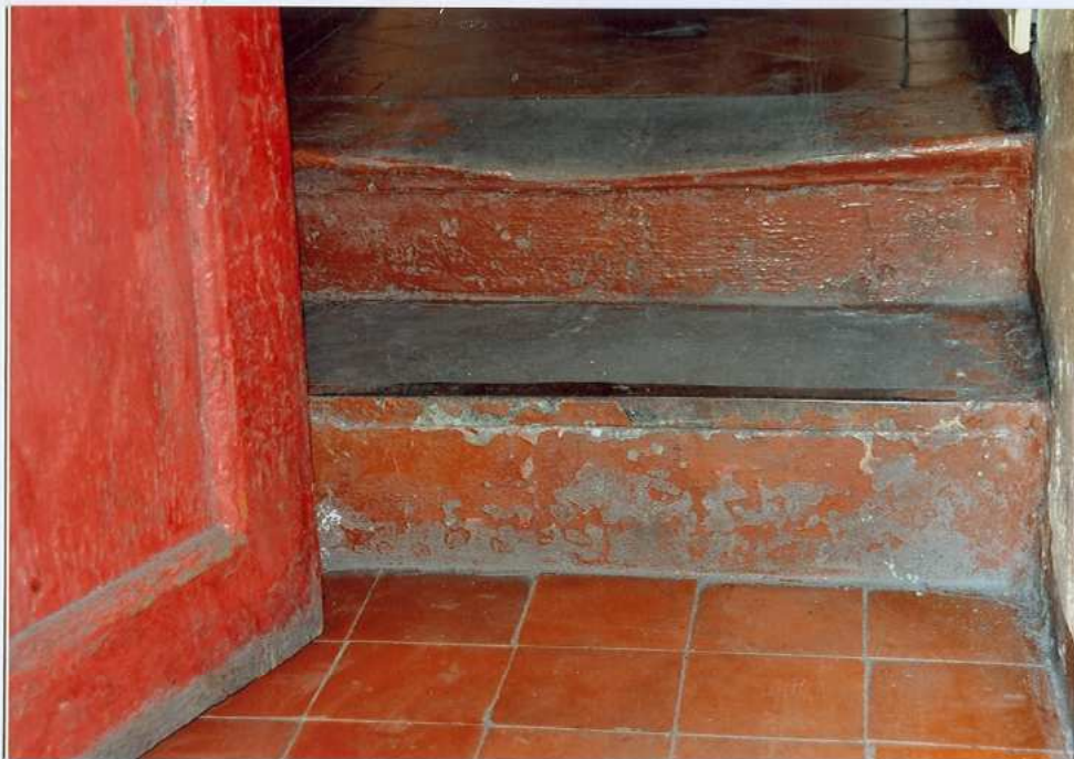
Fot. 42. Schody wewnętrzne –dolna partia.
