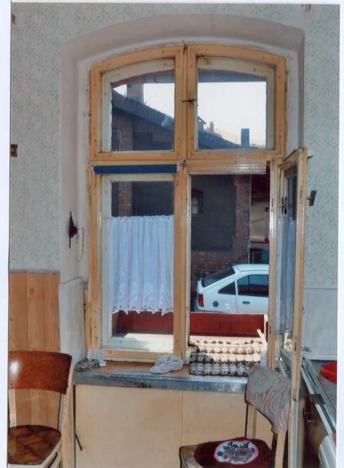
Fot. 51. Okno na parterze – widok z wnętrza.
