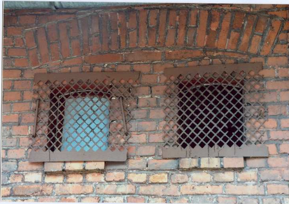
Fot. 24. Okna do łazienki – elewacja zachodnia.
