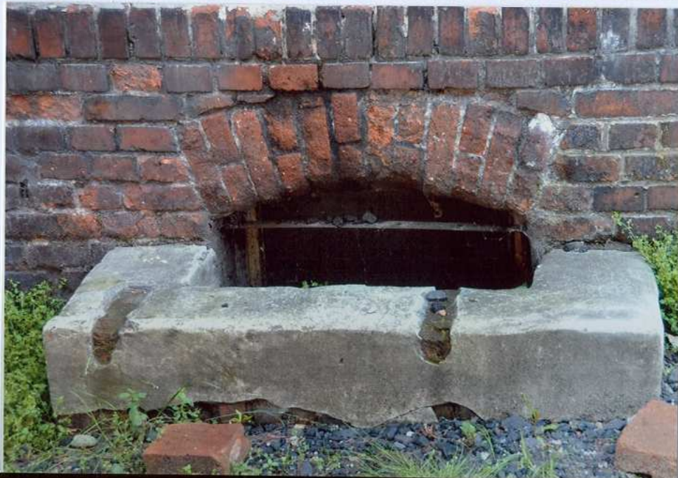
Fot. 35. Okno do piwnicy.
