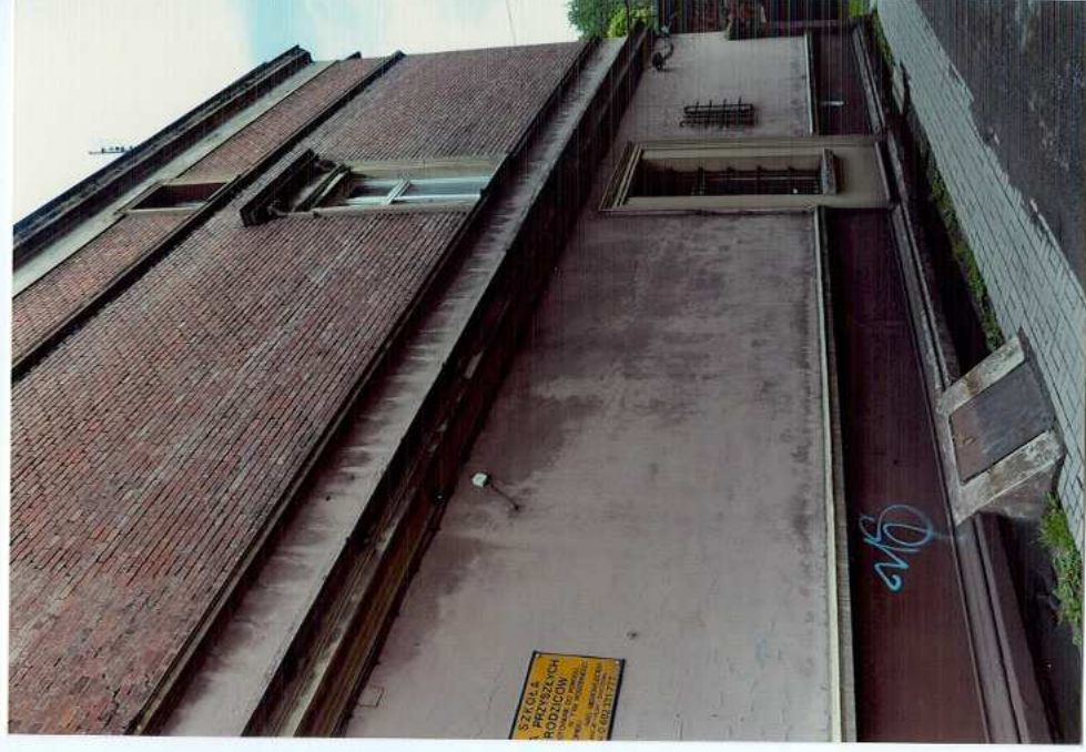
Fot. 46. Elewacja południowa.
