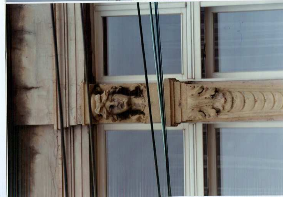
Fot. 36. Górna partia słupka międzyokiennego.
