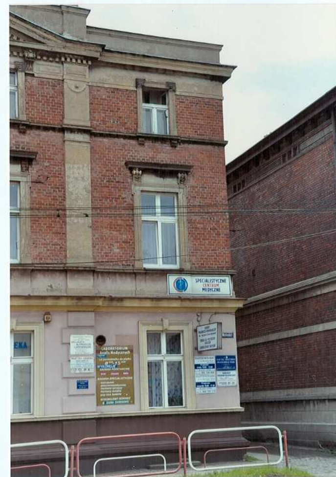
Fot. 25. Elewacja zachodnia - część południowa.
