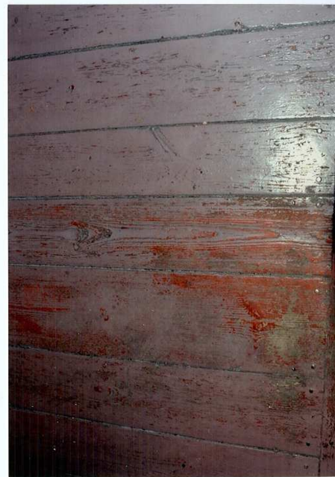
Fot. 96. Posadzka drewniana.
