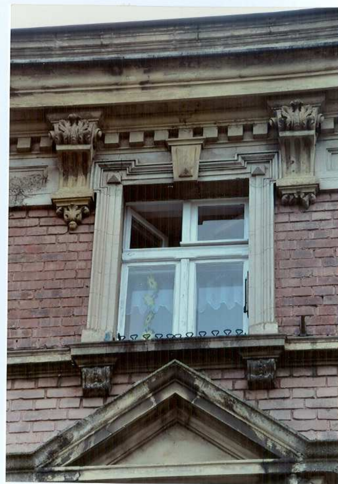
Fot. 7. Okno na II piętrze – elewacja północna.
