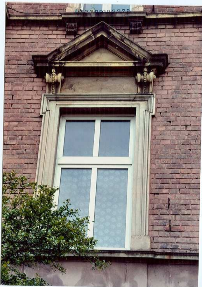
Fot. 14. Okno pierwszego piętra – elewacja północna.
