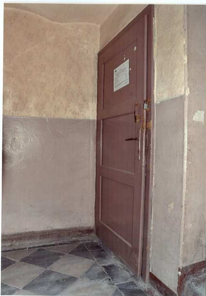
Fot. 73. Drzwi do piwnicy.
