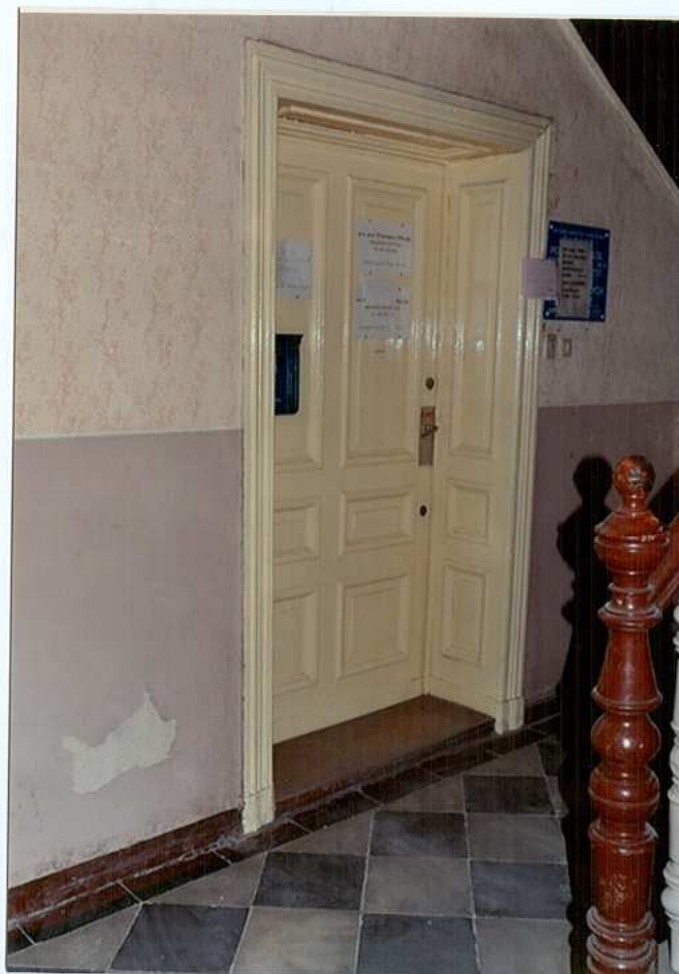
Fot. 70. Drzwi na parterze.
