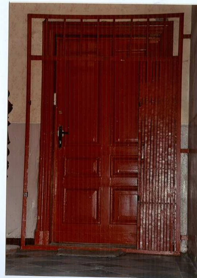
Fot. 71. Drzwi na parterze.
