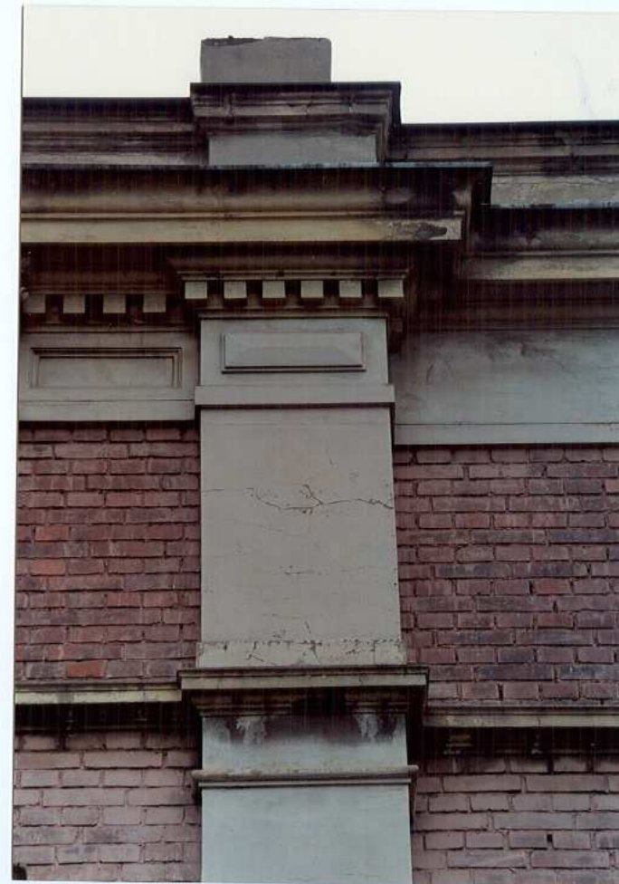
Fot. 10. Górna partia pilastra – elewacja północna.
