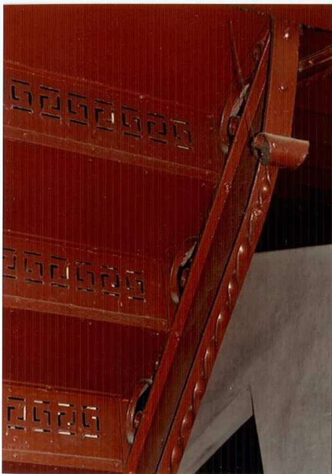
Fot. 94. Fragment belki policzkowej – widok od spodu.
