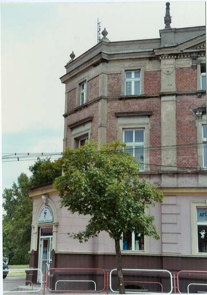
Fot. 23. Elewacja zachodnia – część północna.
