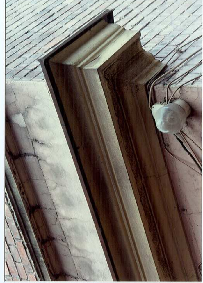
Fot. 50. Fragment gzymsu międzykondygnacyjnego.
