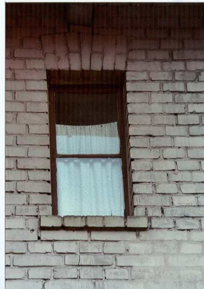
Fot. 65. Okno poddasza – elewacja północna.
