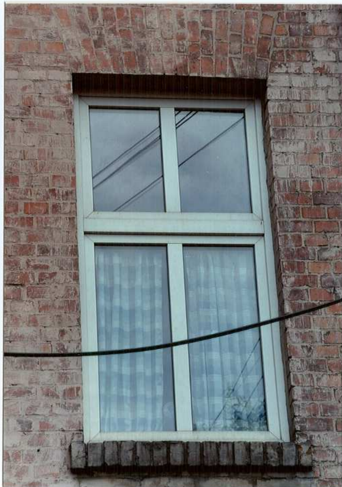
Fot. 63. Okno I piętra – elewacja północna.
