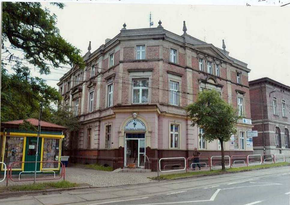
Ryc. 1. Widok ogólny od strony północno - zachodniej.
