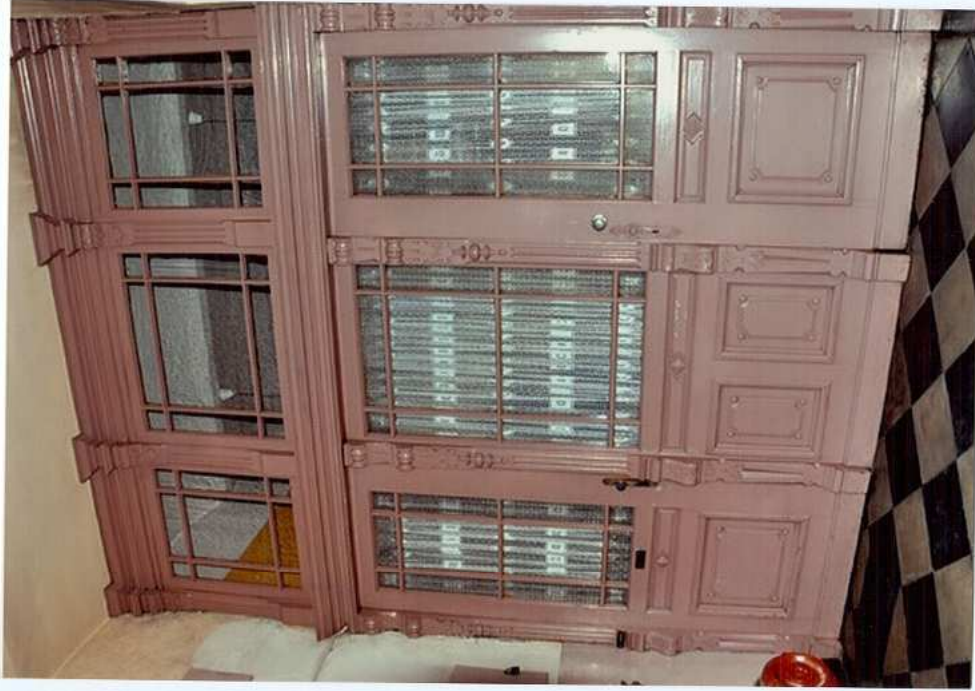
Fot. 79. Drzwi do mieszkań.
