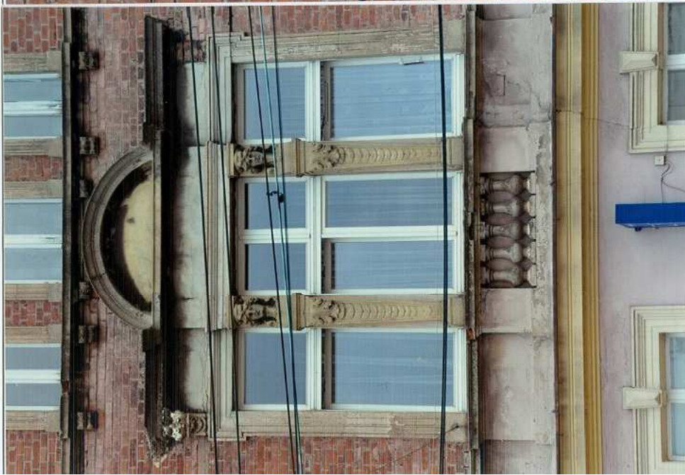
Fot. 34. Okno pierwszego piętra – elewacja zachodnia.
