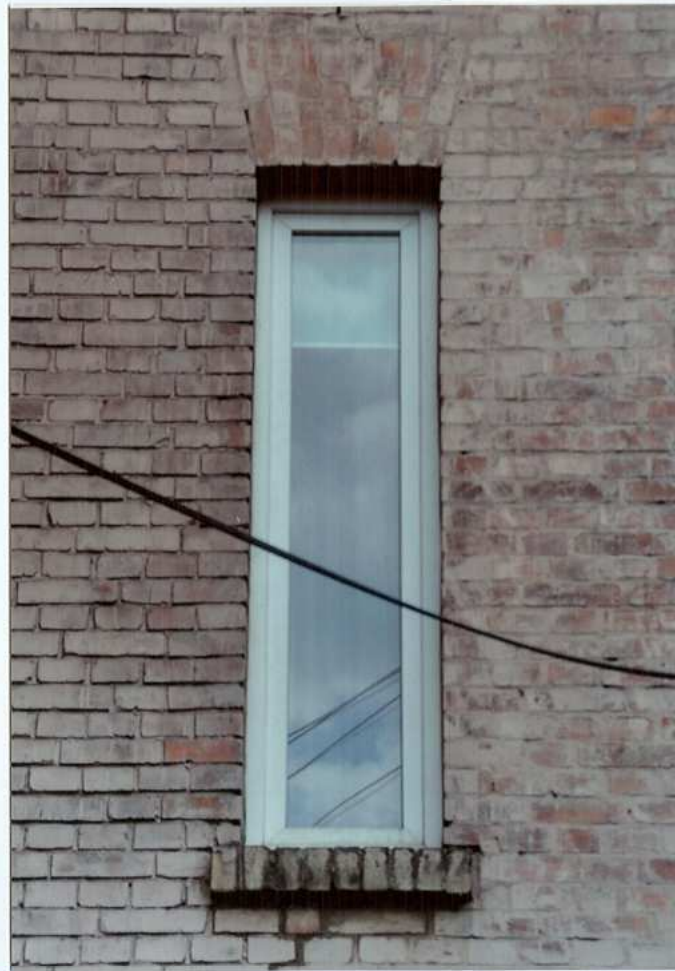
Fot. 64. Okno I piętra – elewacja północna.
