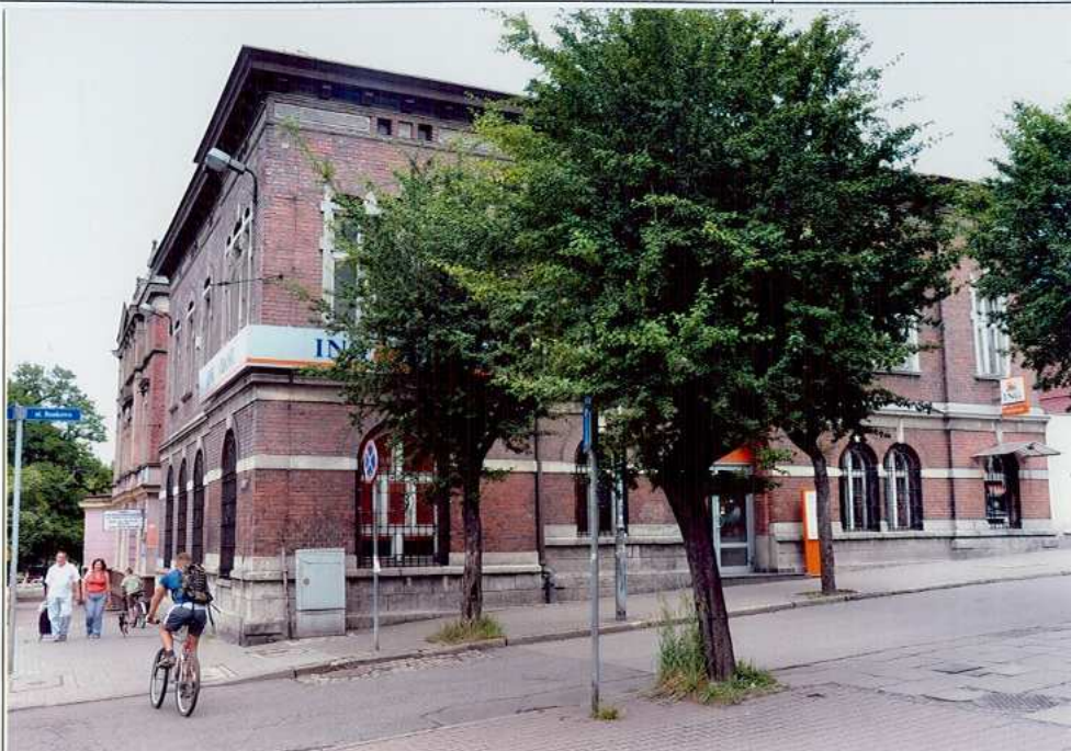
Fot. 20. Widok na budynek od strony płd. – zachodniej.
