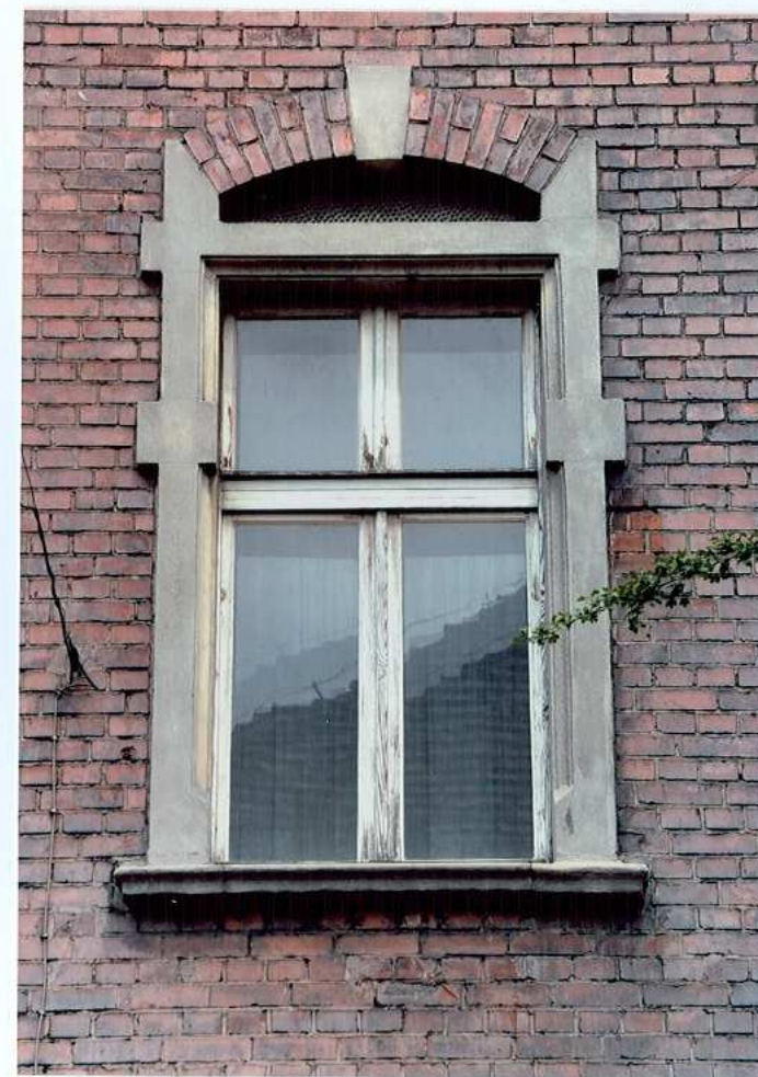
Fot. 26. Okno na piętrze – elewacja południowa.
