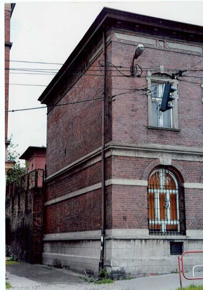
Fot. 3. Widok na budynek od strony północno – zachodniej (elewacja północna).
