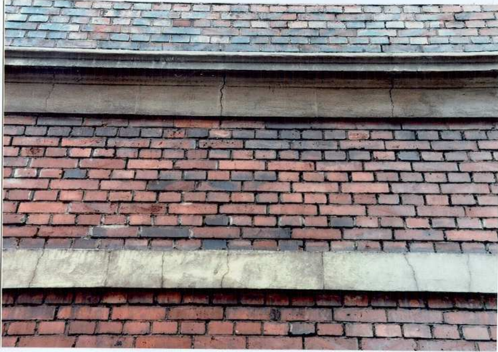
Fot. 4. Ściana z cegły.
