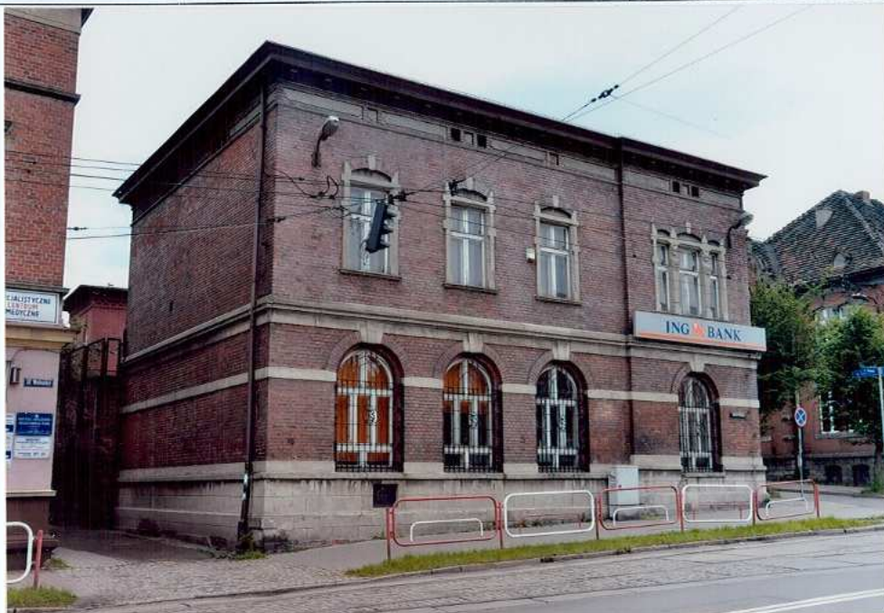
Fot. 1. Widok na budynek od strony pín. – zachodniej.
