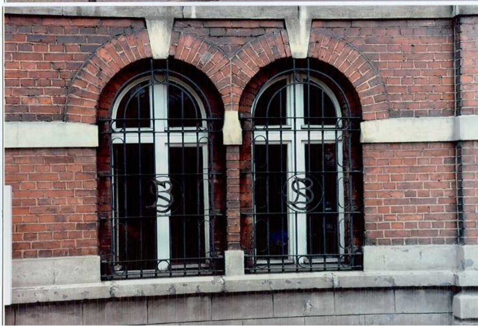
Fot. 23. Okno parteru – elewacja południowa.
