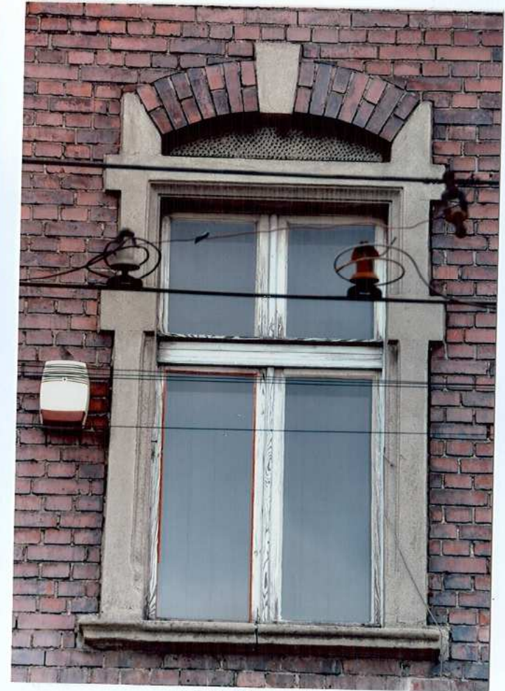
Fot. 13. Okno – piętro.
