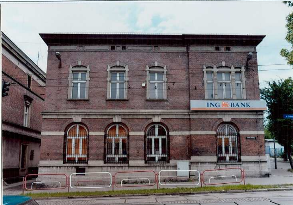
Fot. 7. Elewacja zachodnia.
