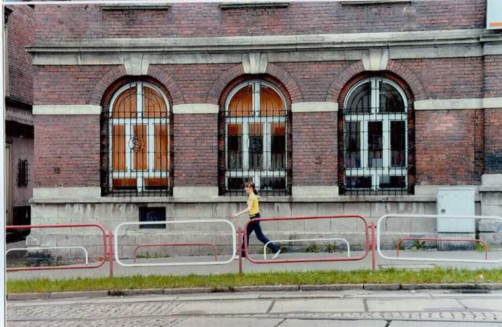
Fot. 8. Dolna partia elewacji zachodniej.
