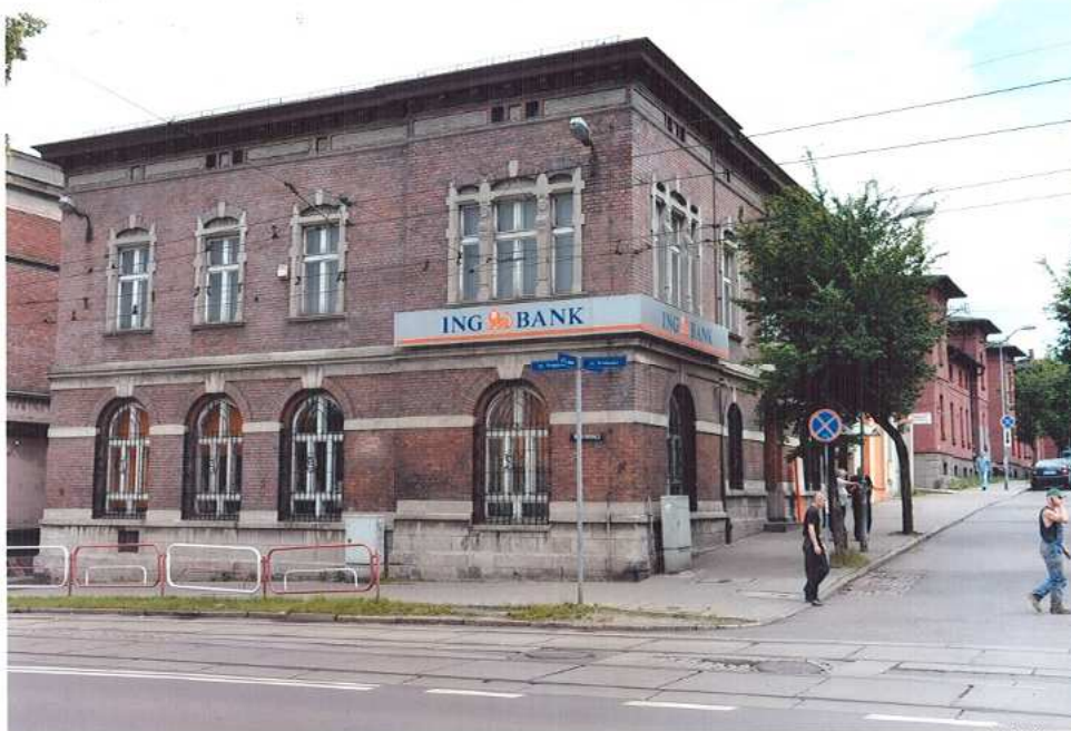
Ryc. 1. Widok ogólny od strony południowo – zachodniej.
