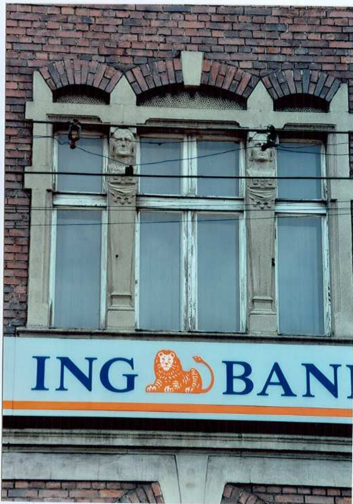
Fot. 14. Okna pierwszego piętra.
