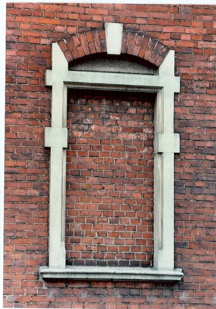
Fot. 32. Plycina w formie okna – elewacja wschodnia.
