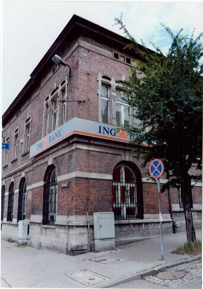
Fot. 11. Widok na budynek od strony południowo – zachodniej.
