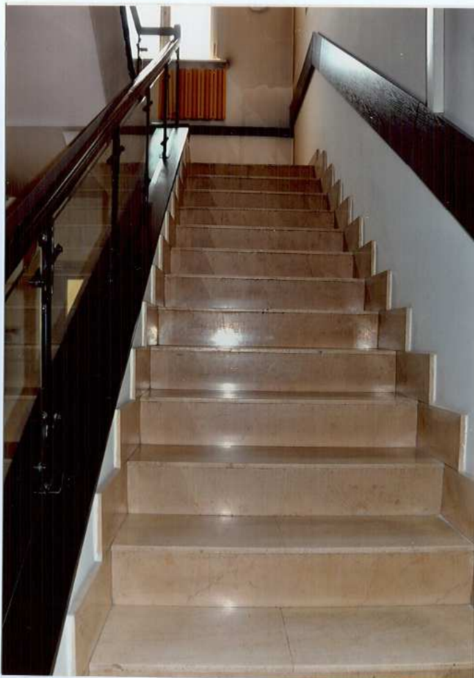
Fot. 39. Klatka schodowa.
