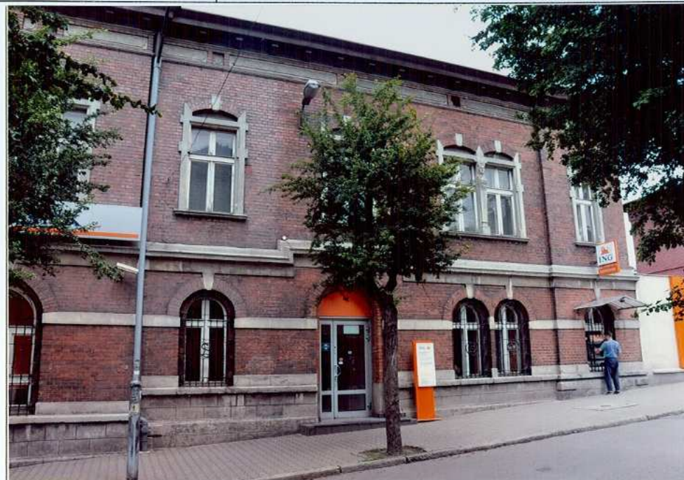
Fot. 22. Elewacja południowa.
