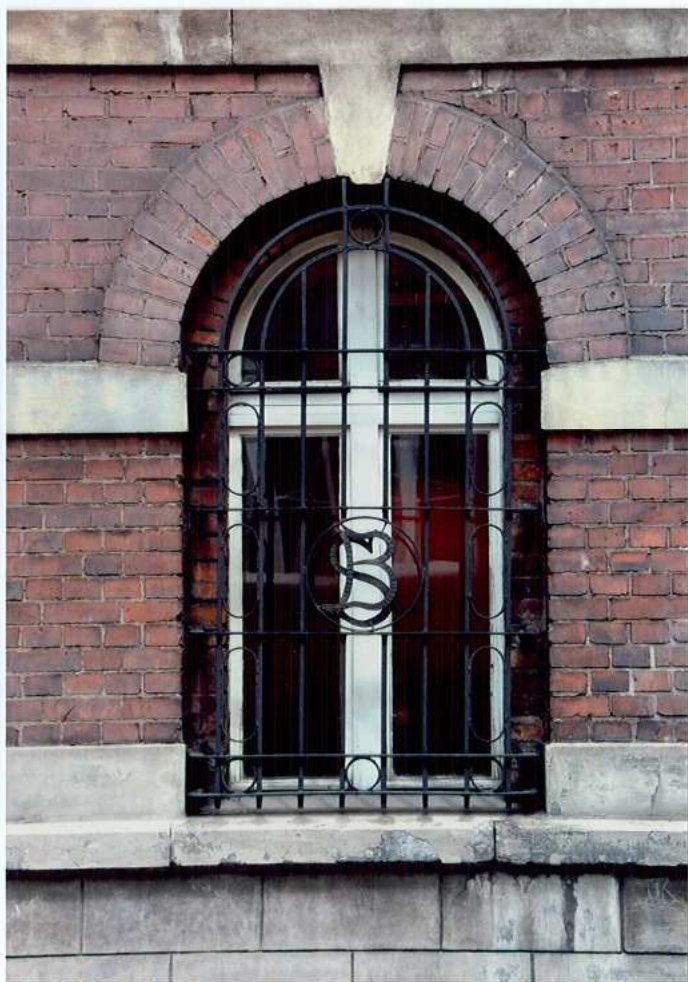
Fot. 24. Okno parteru – elewacja południowa.
