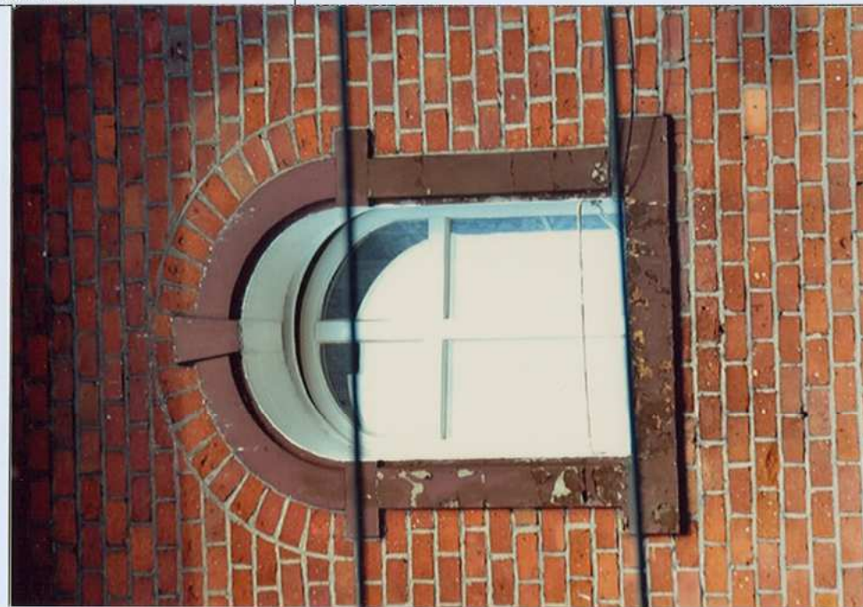
Fot. 12. Okno poddasza – ryzalit.
