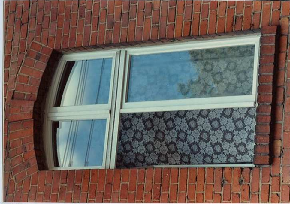
Fot. 48. Okno 1 piętra – elewacja wschodnia.
