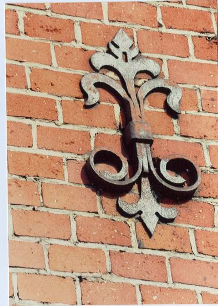
Fot. 20. Ściąg żeliwny.
