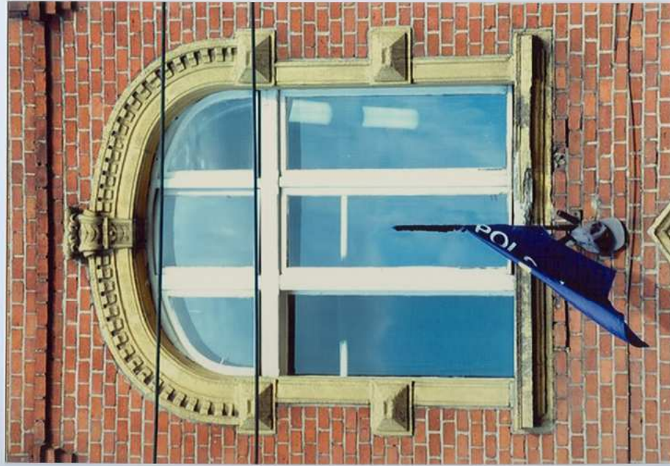
Fot. 11. Okno 1 piętra – ryzalit.
