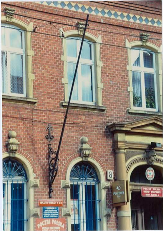
Fot. 18. Maszt żeliwny – elewacja zachodnia.
