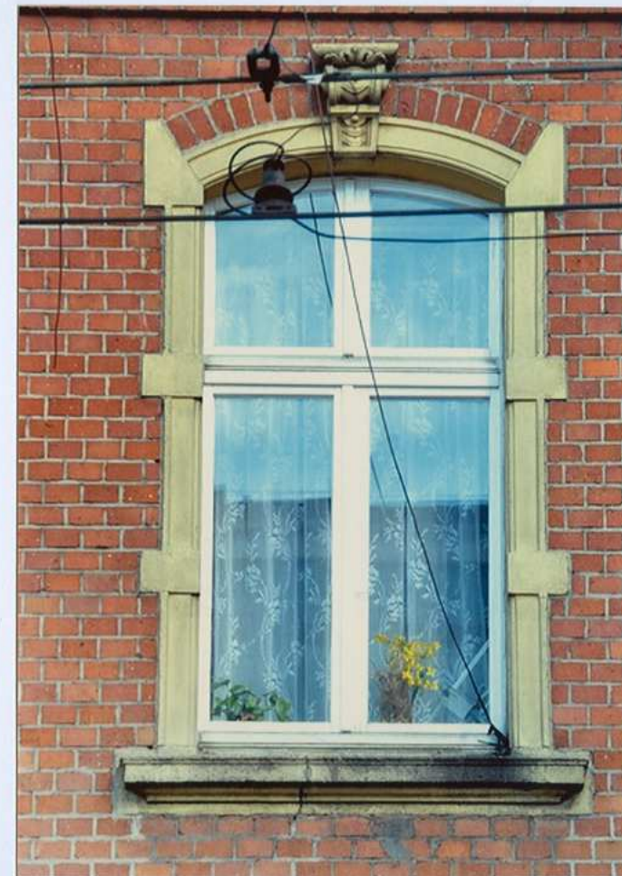
Fot. 17. Okno 1 piętra – część środkowa elewacji zach.
