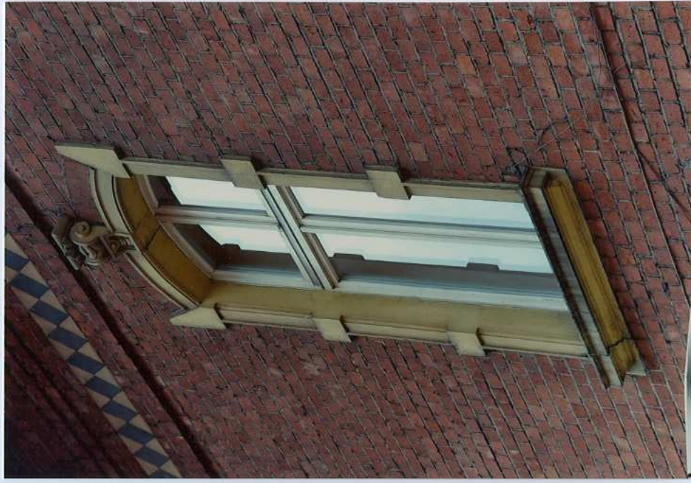
Fot. 40. Okno, 1 piętro – elewacja południowa.
