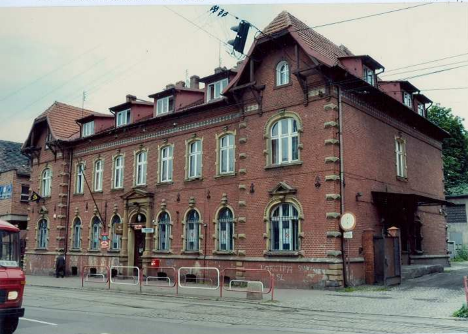
Ryc. 1. Widok ogólny od strony południowo – zachodniej.
