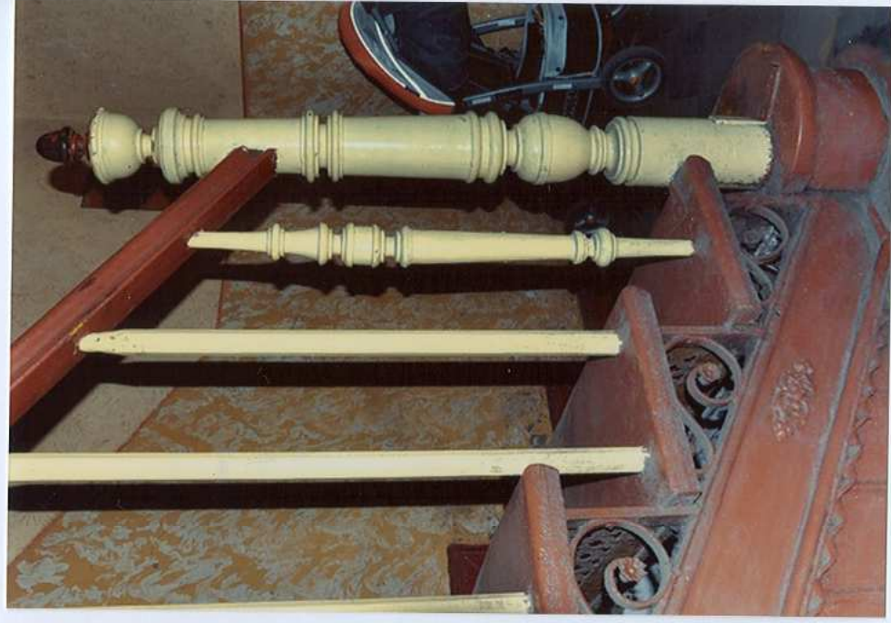
Fot. 58. Słupek balustrady.
