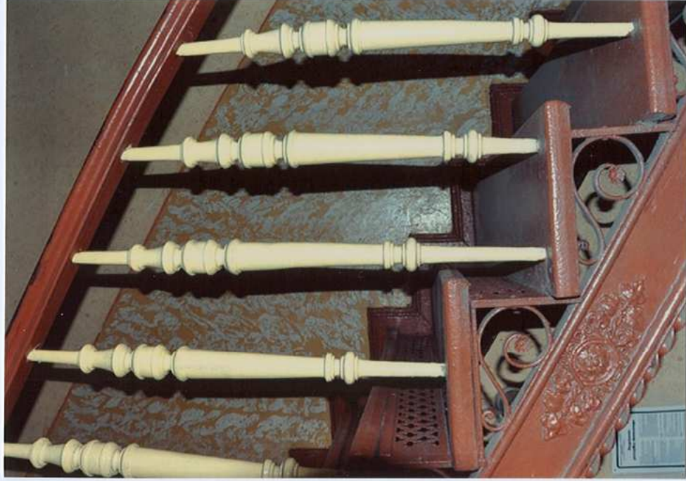
Fot. 57. Tralki – balustrada schodów.
