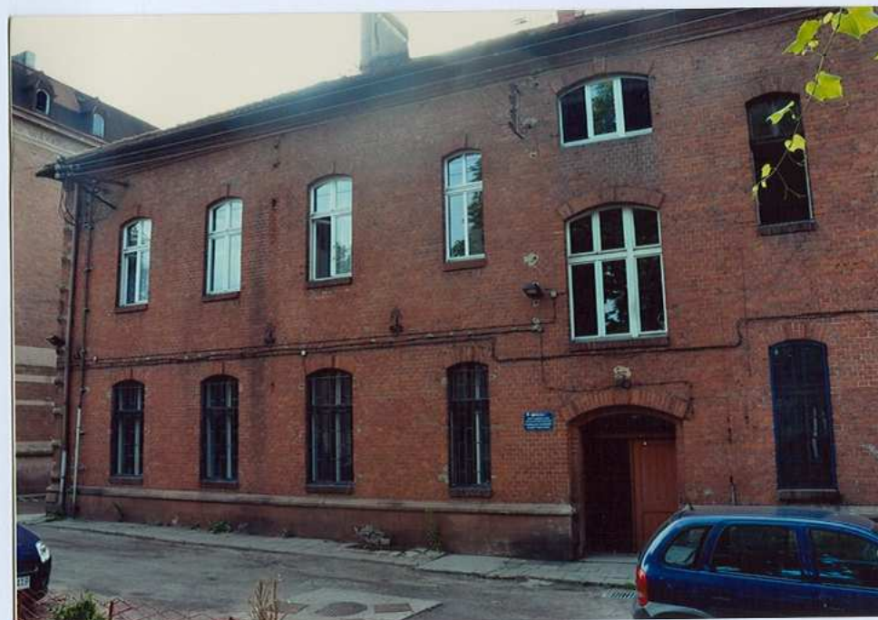
Fot. 43. Elewacja wschodnia.
