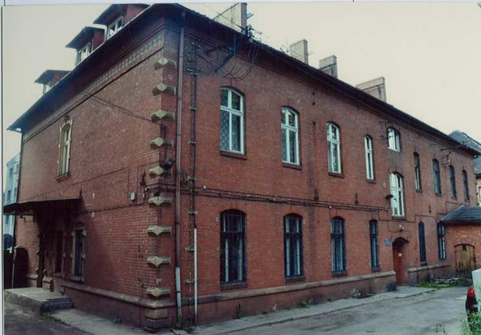
Fot. 41. Elewacja wschodnia – widok od strony płd.
