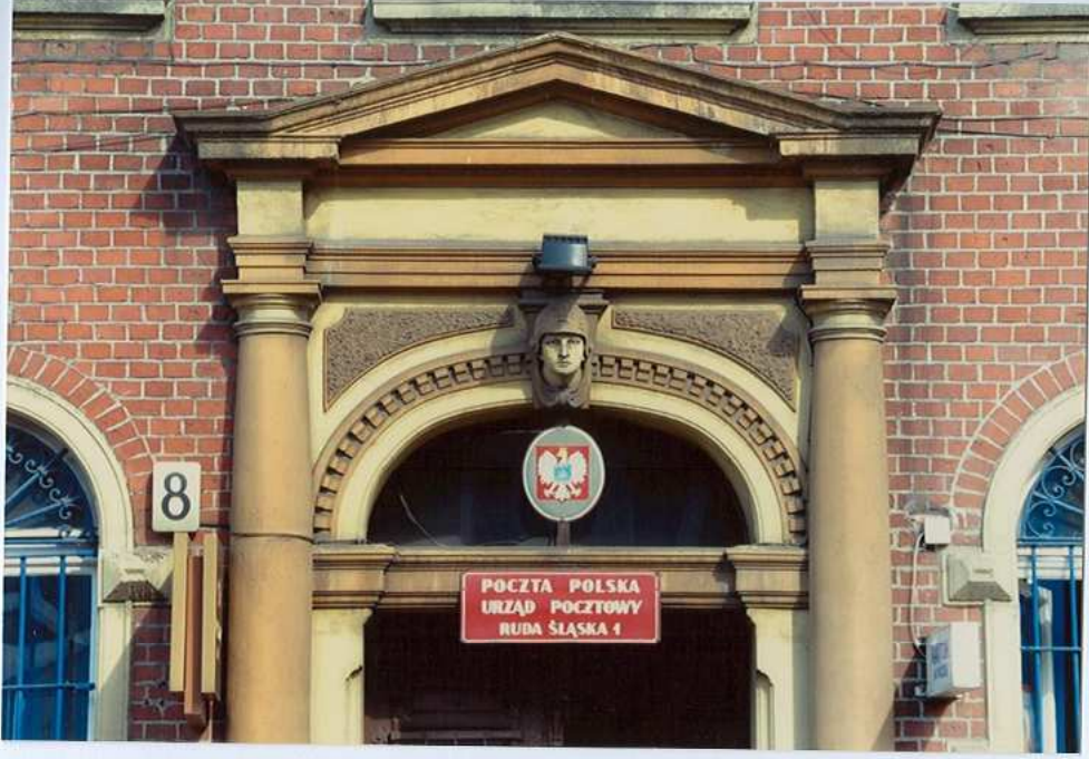
Fot. 25. Górna partia portalu.
