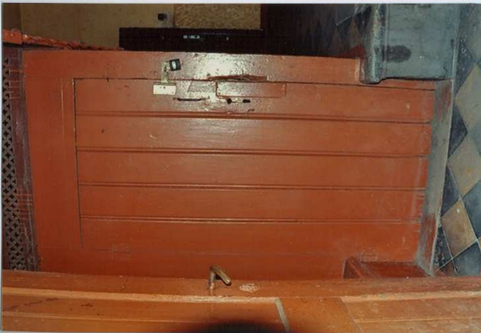
Fot. 53. Drzwi do piwnicy.
