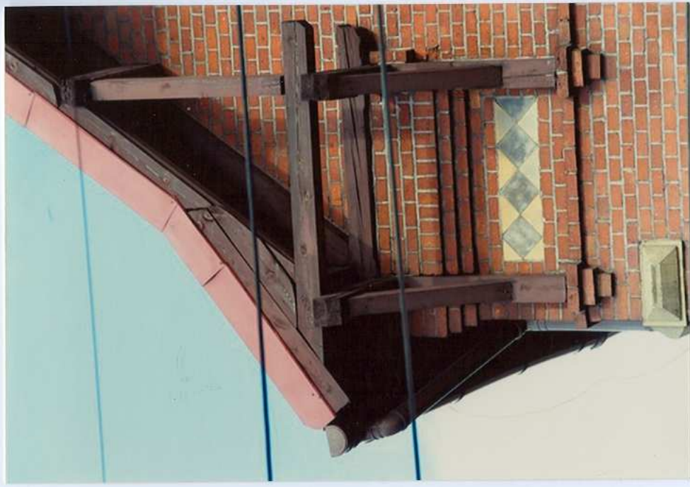
Fot. 6. Zastrzały – fragment więźby dachowej.
