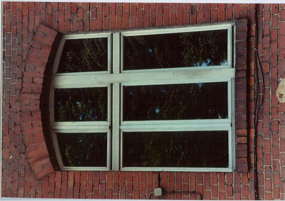
Fot. 47. Okno – klatka schodowa – elewacja wschodnia.
