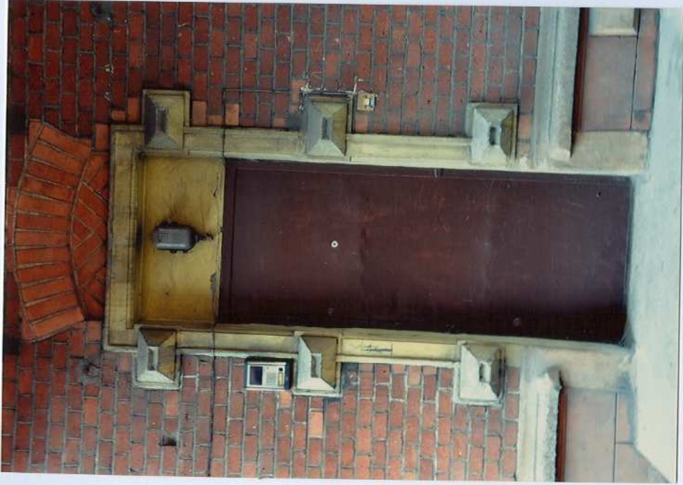
Fot. 37. Drzwi wejściowe – elewacja południowa.
