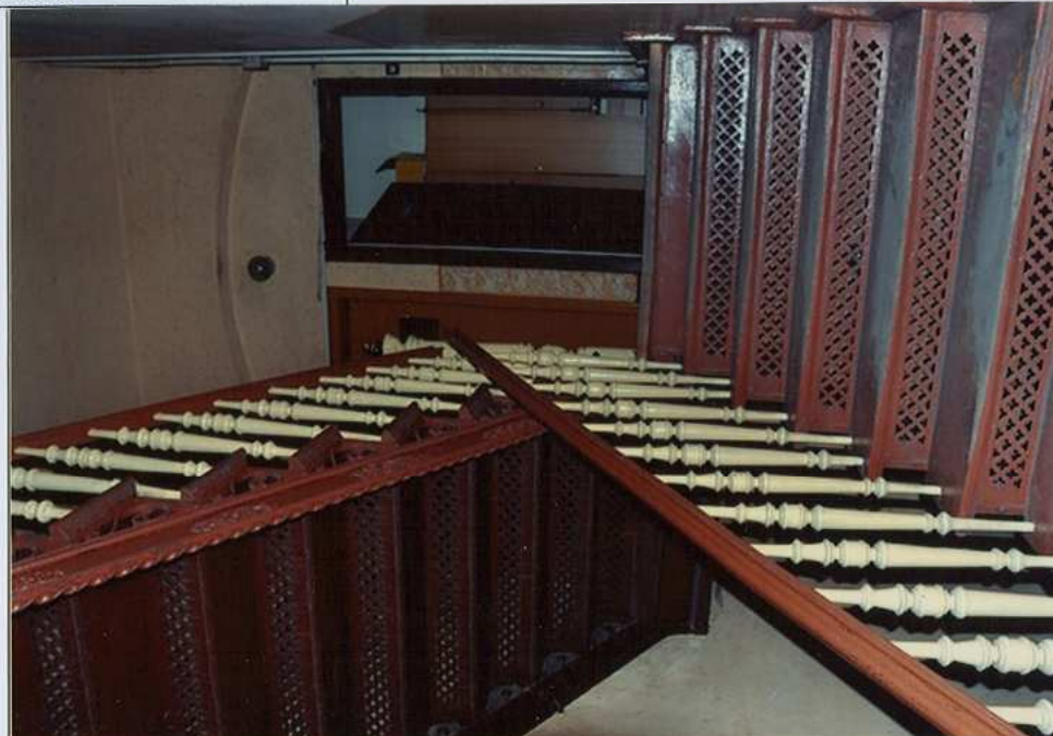
Fot. 56. Klatka schodowa.
