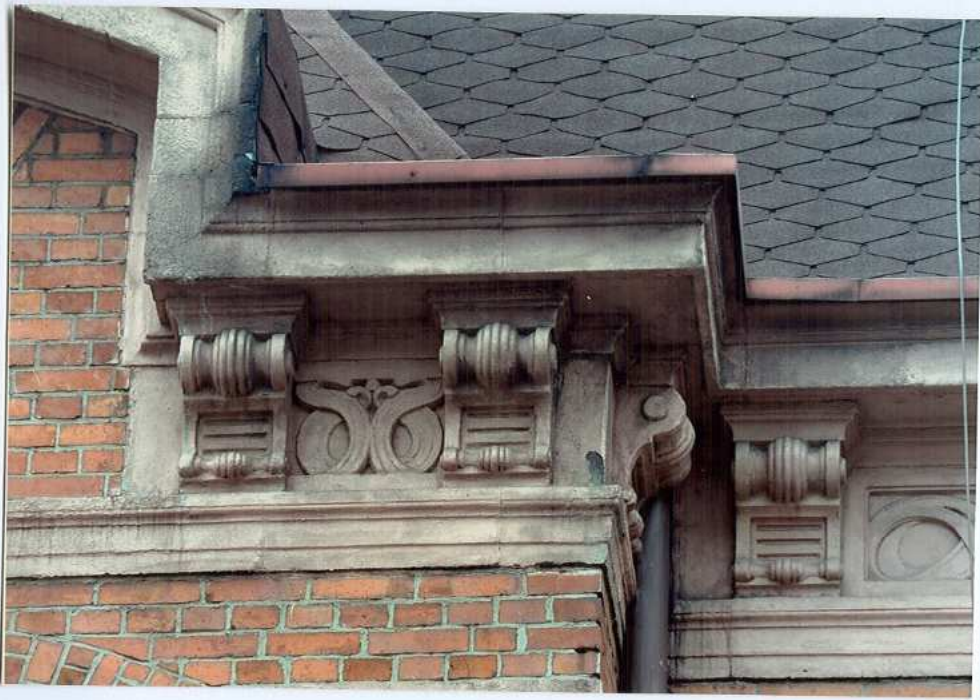
Fot. 5. Fragment gzymsu wieńczącego z kroksztynami.
