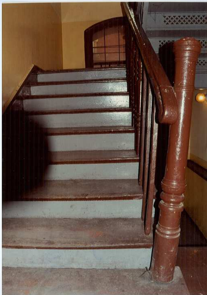
Fot. 48. Klatka schodowa – północna
