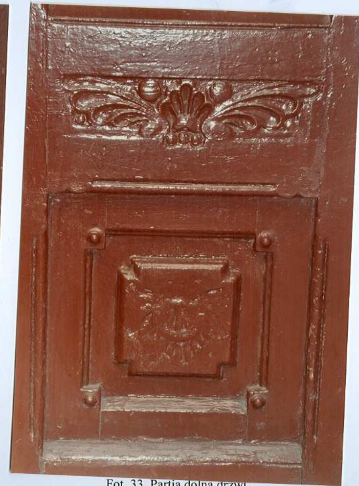
Fot. 33. Partia dolna drzwi.
