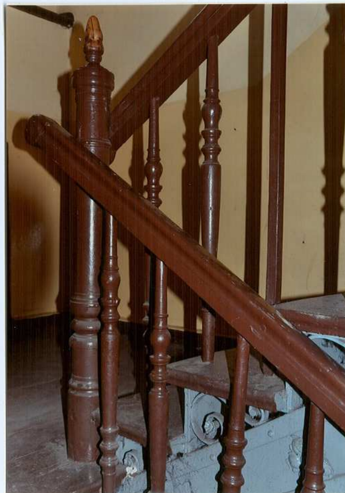
Fot. 52. Słupek i balustrada schodów.
