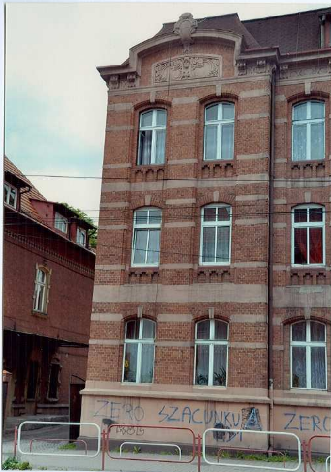
Fot. 9. Elewacja zachodnia – strona północna.
