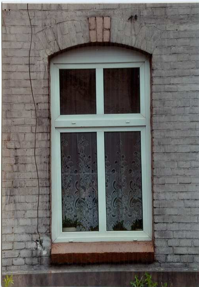
Fot. 39. Okno parteru – elewacja wschodnia.
