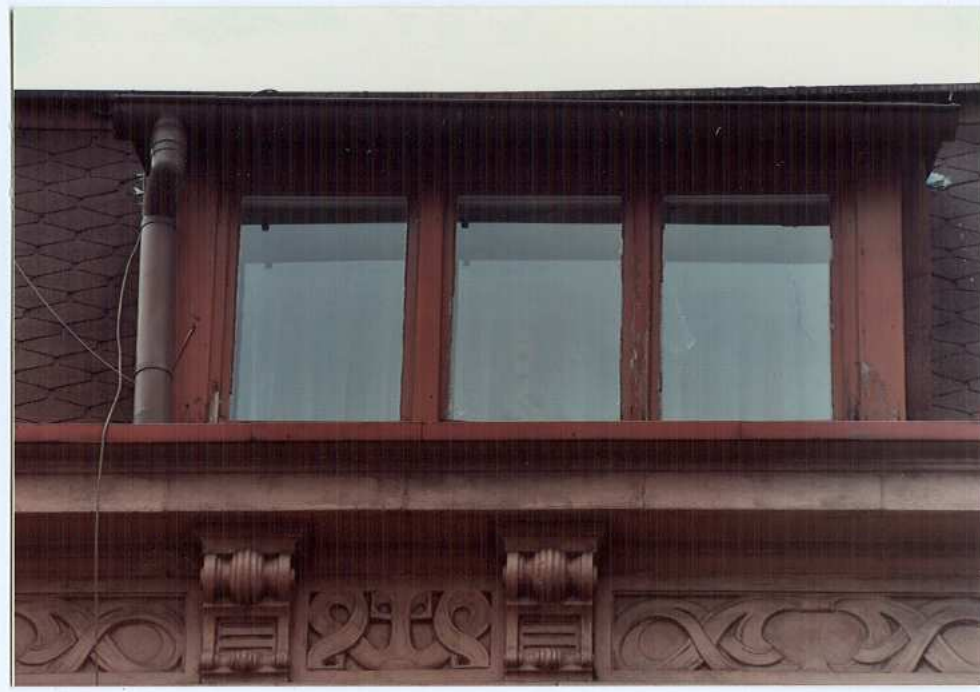
Fot. 7. Okna poddasza.
