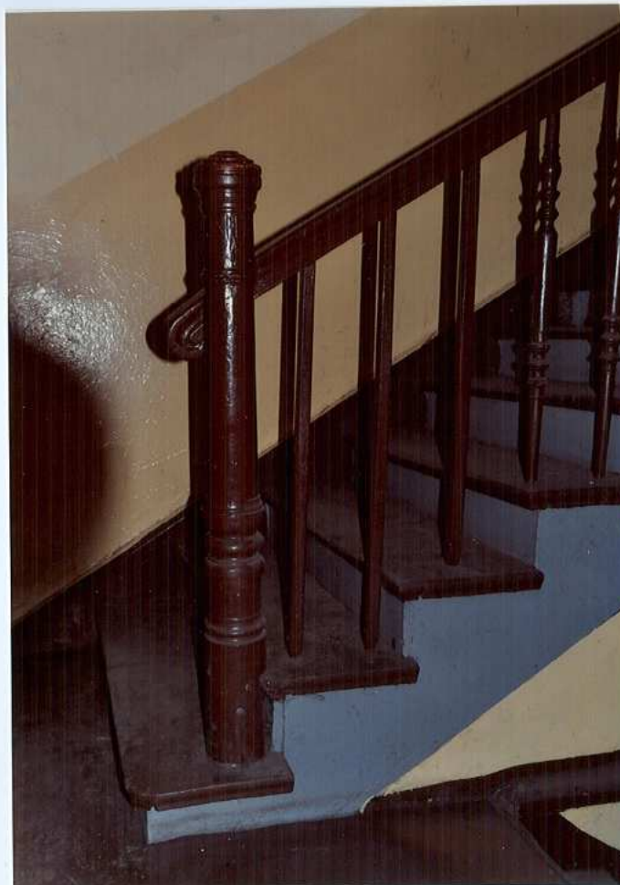
Fot. 49. Balustrada schodów.
