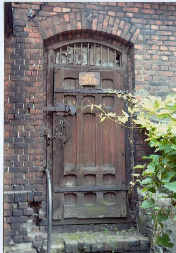
Fot. 44. Drzwi do budynku gospodarczego.
