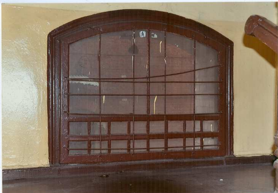
Fot. 64. Okno na klatce schodowej.
