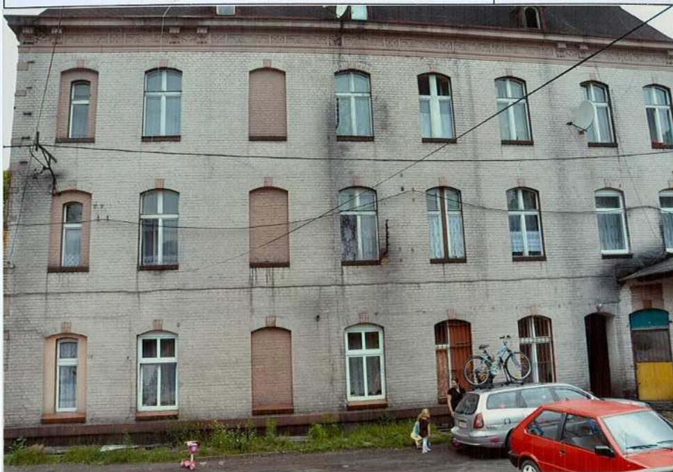
Fot. 36. Elewacja wschodnia.
