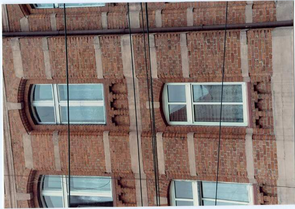
Fot. 12. Okna 1 i 2 piętra.
