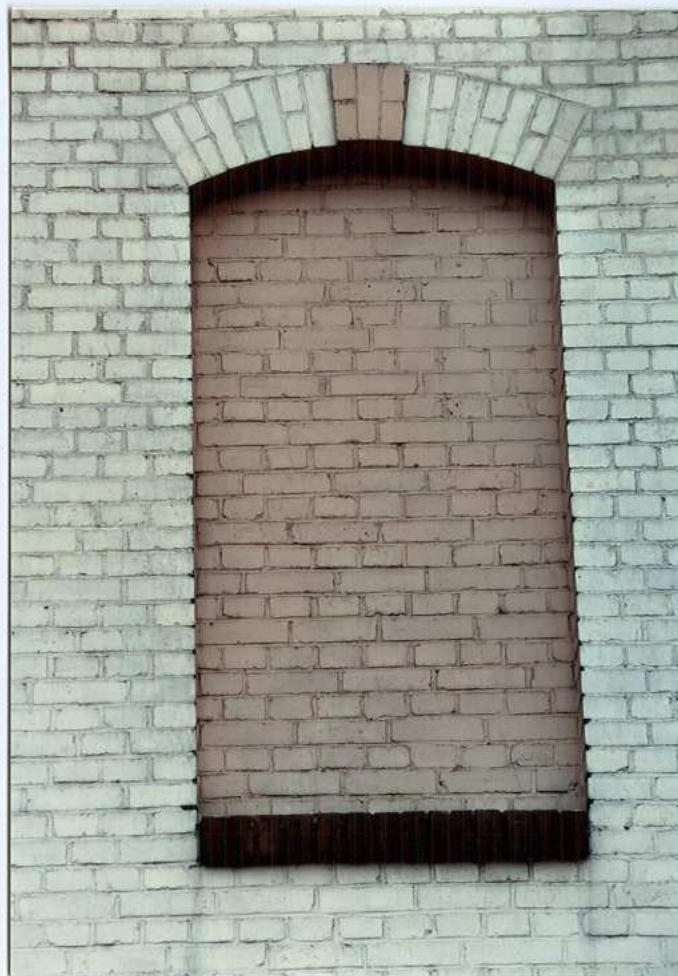
Fot. 40. Płycina w formie okna – parter.
