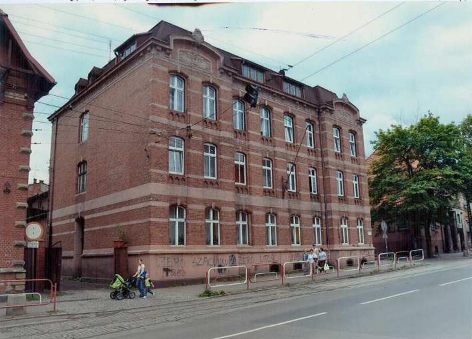
Ryc. 1. Widok ogólny od strony północno - zachodniej.
