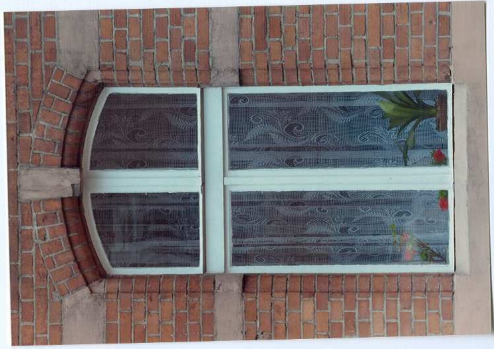
Fot. 15. Okno 3 piętra.
