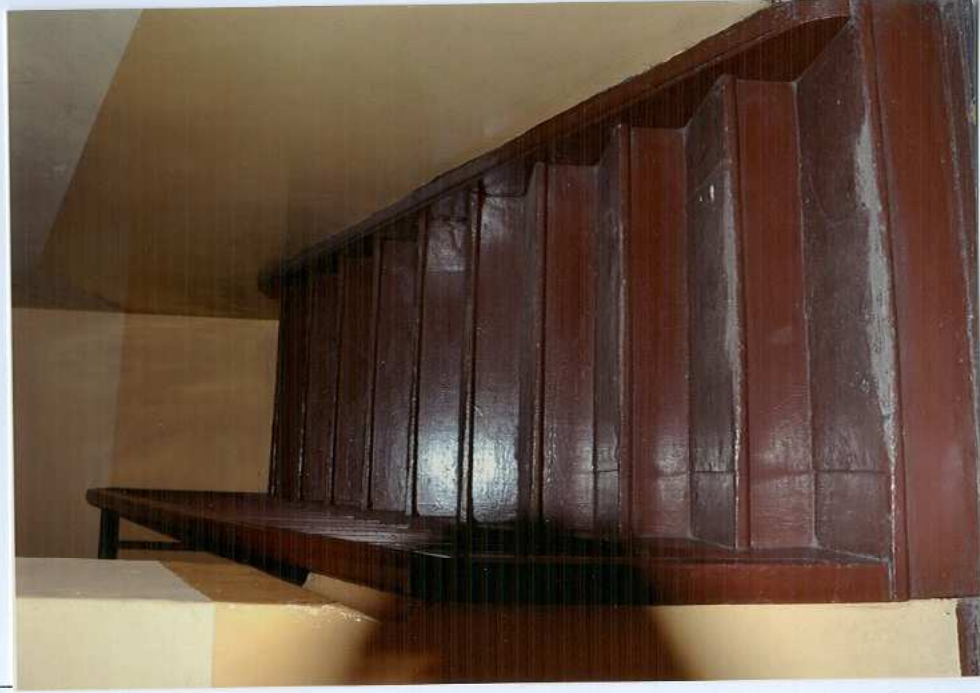
Fot. 45. Widok na klatkę schodową – południowa.
