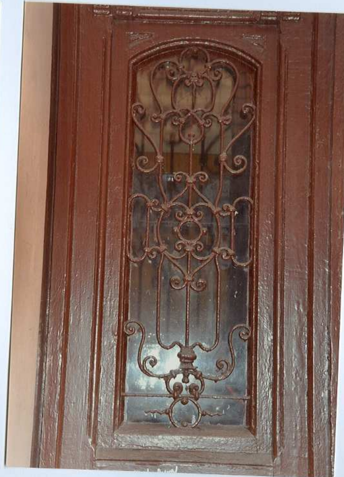
Fot. 32. Partia szklona drzwi.
