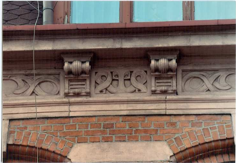
Fot. 8. Gzyms wieńczący z kroksztynami.
