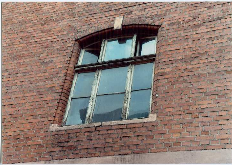
Fot. 20. Okno – klatka schodowa – elewacja północna.
