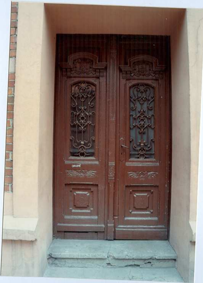
Fot. 31. Drzwi zewnętrzne – elewacja południowa.
