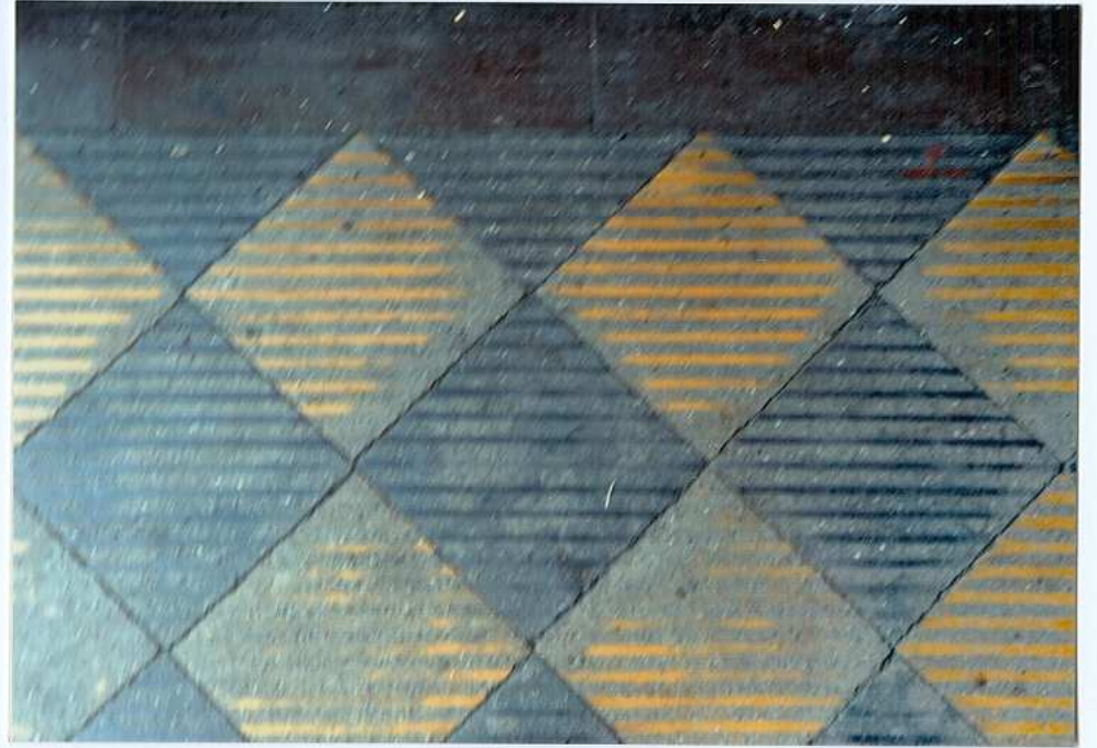
Fot. 59. Posadzka – klatka schodów.
