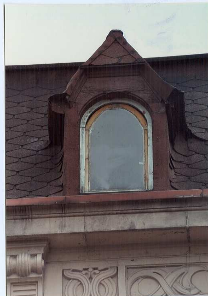
Fot. 41. Okno poddasza – elewacja wschodnia.
