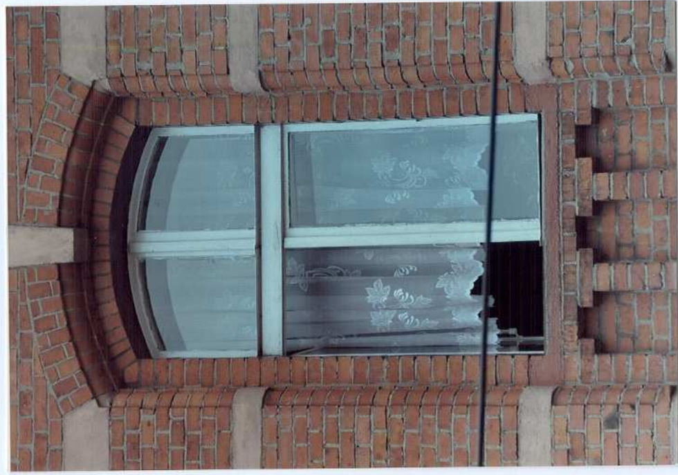
Fot. 13. Okno 1 piętra.
