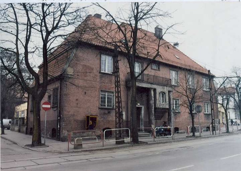
Ryc. 1. Widok ogólny od strony północno – zachodniej.
