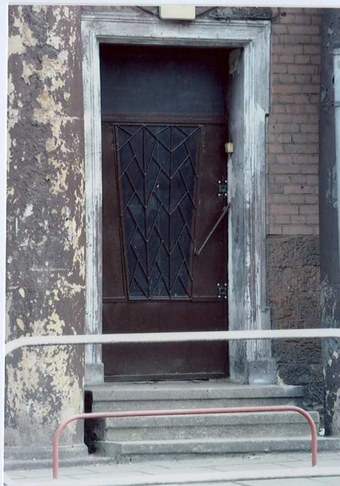
Fot. 10. Drzwi wejściowe – elewacja zachodnia.
