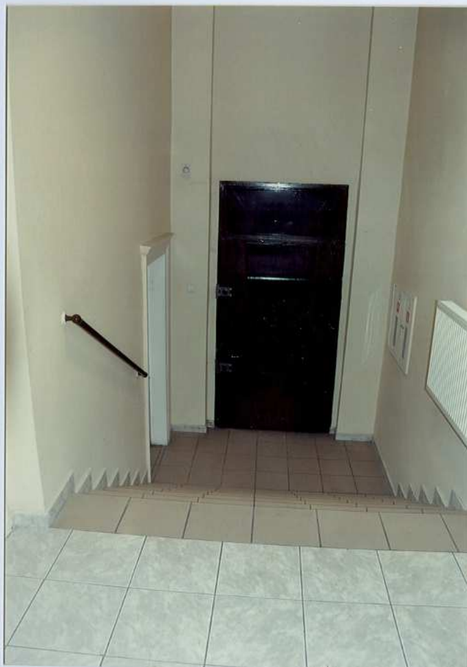
Fot. 37. Wejście do budynku – hall.
