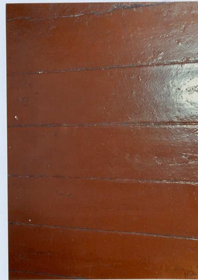
Fot. 39. Podłoga na opoczniku.
