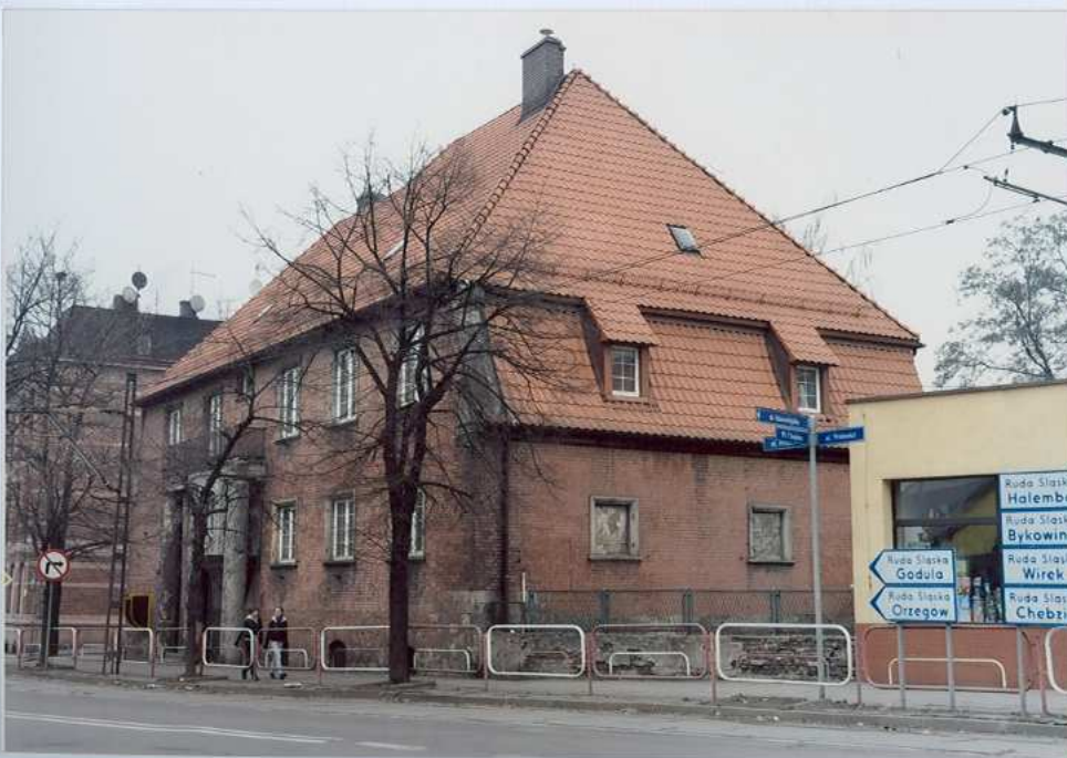
Fot. 2. Widok od strony południowo – zachodniej.
