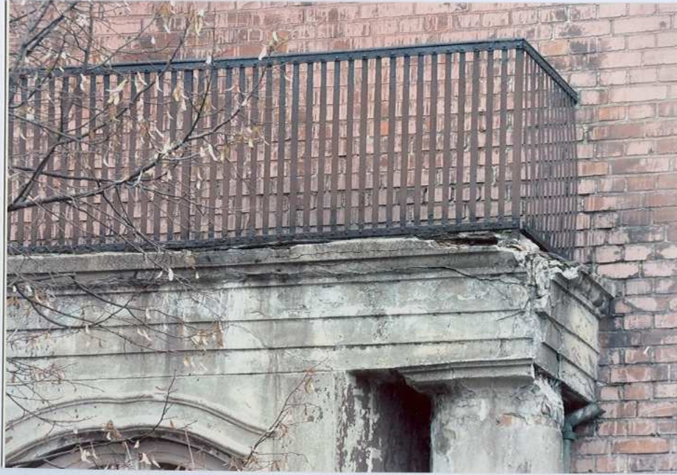
Fot. 13. Balustrada balkonu.
