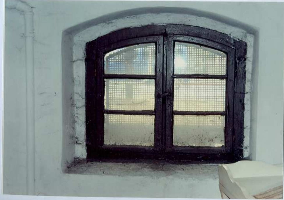
Fot. 54. Okno – piwnica.
