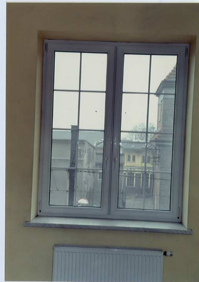
Fot. 45. Okno – piętro.
