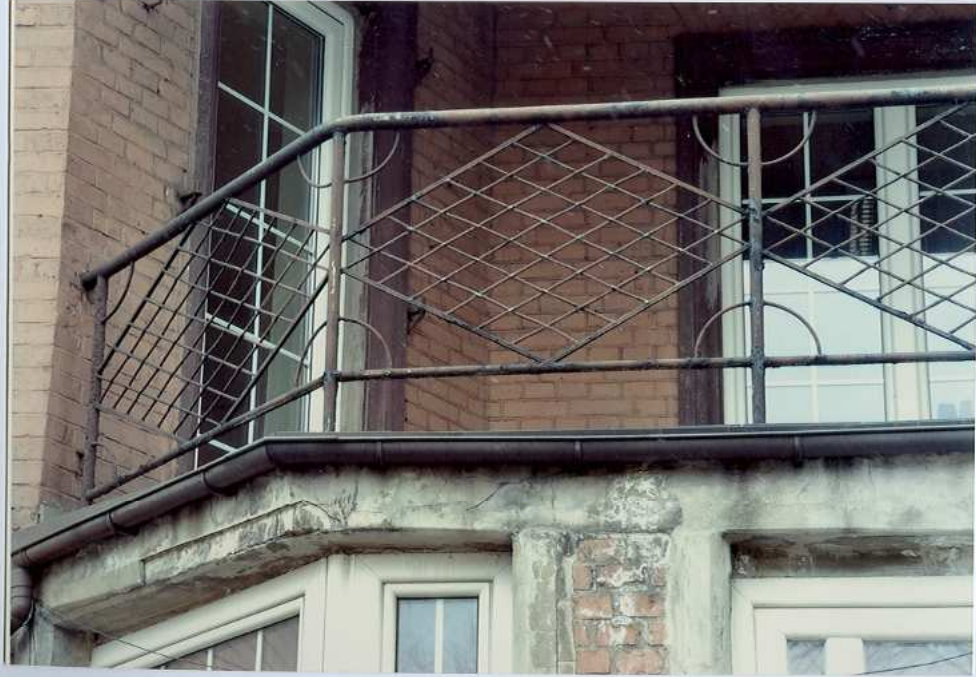
Fot. 28. Balustrada balkonu.
