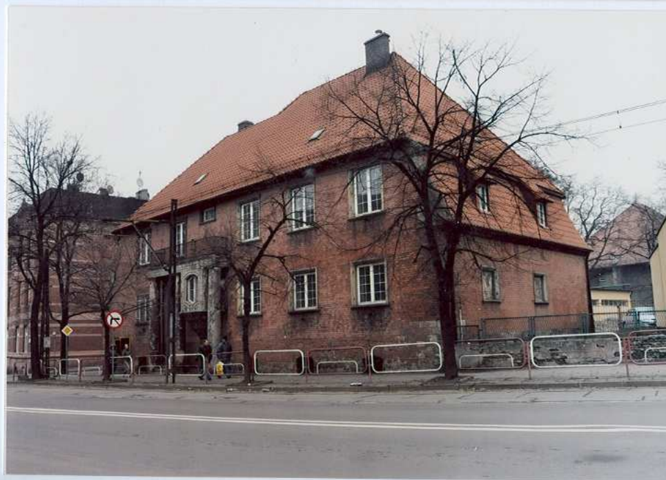
Fot. 4. Widok na elewację zachodnią.
