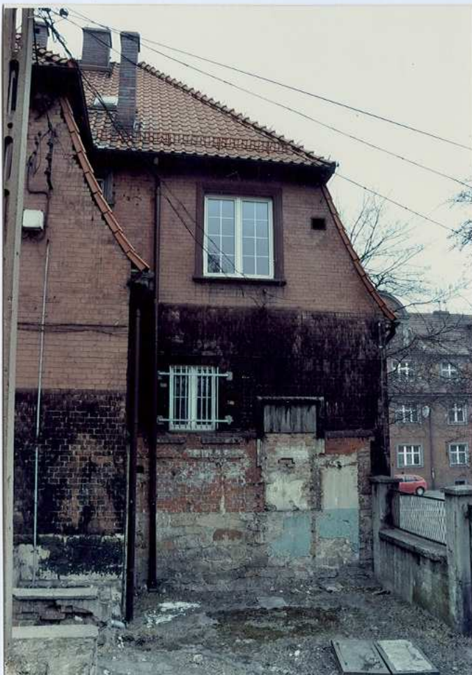
Fot. 20. Elewacja wschodnia – część północna.
