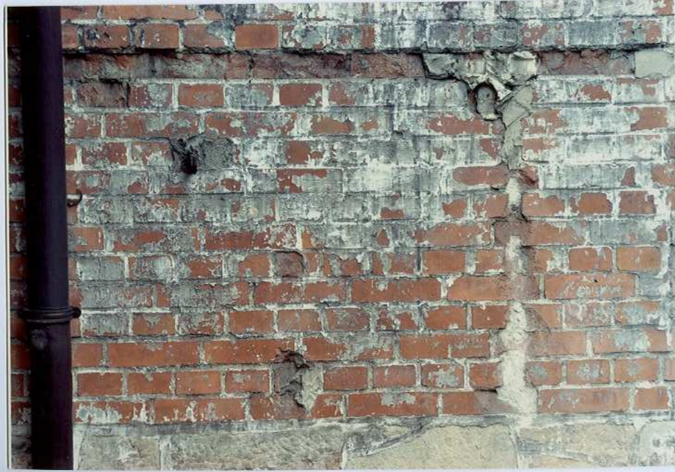
Fot. 34. Ściana – cegła.
