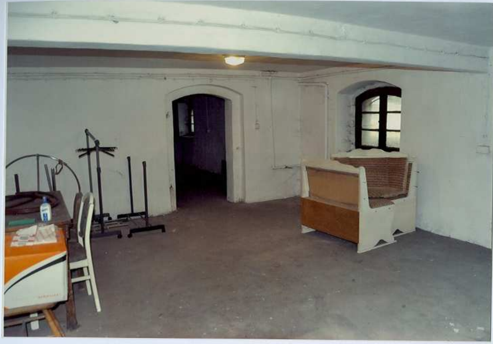
Fot. 53. Piwnica – wnętrze.
