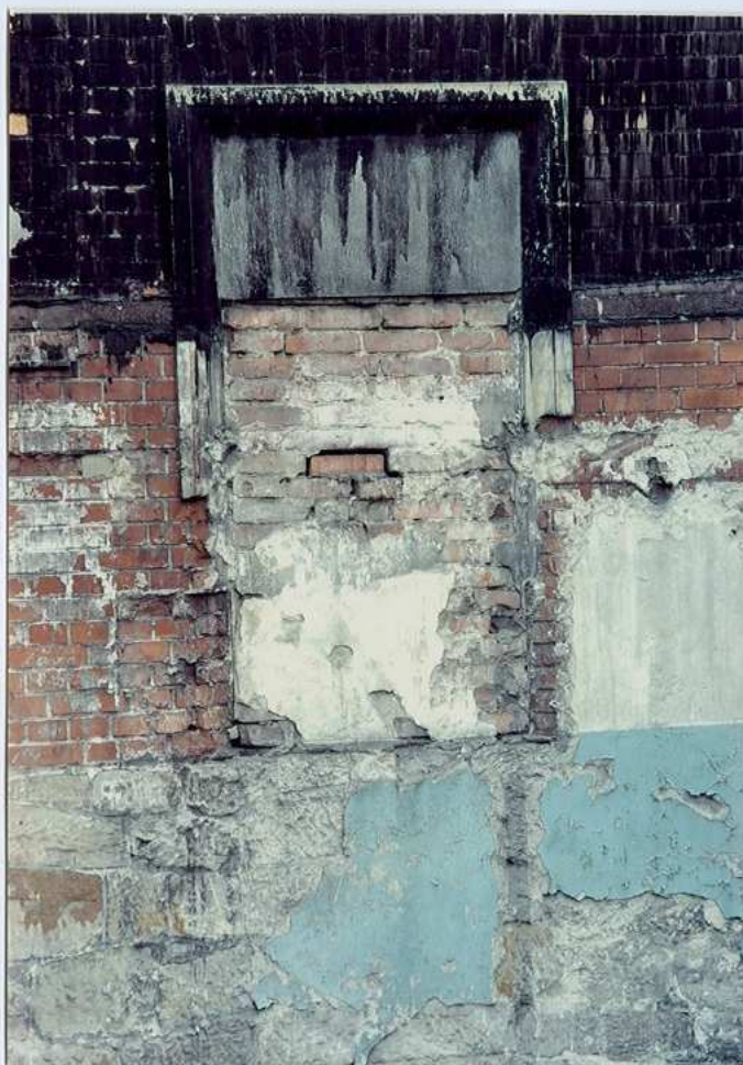
Fot. 21. Zamurowane drzwi – elewacja wschodnia.
