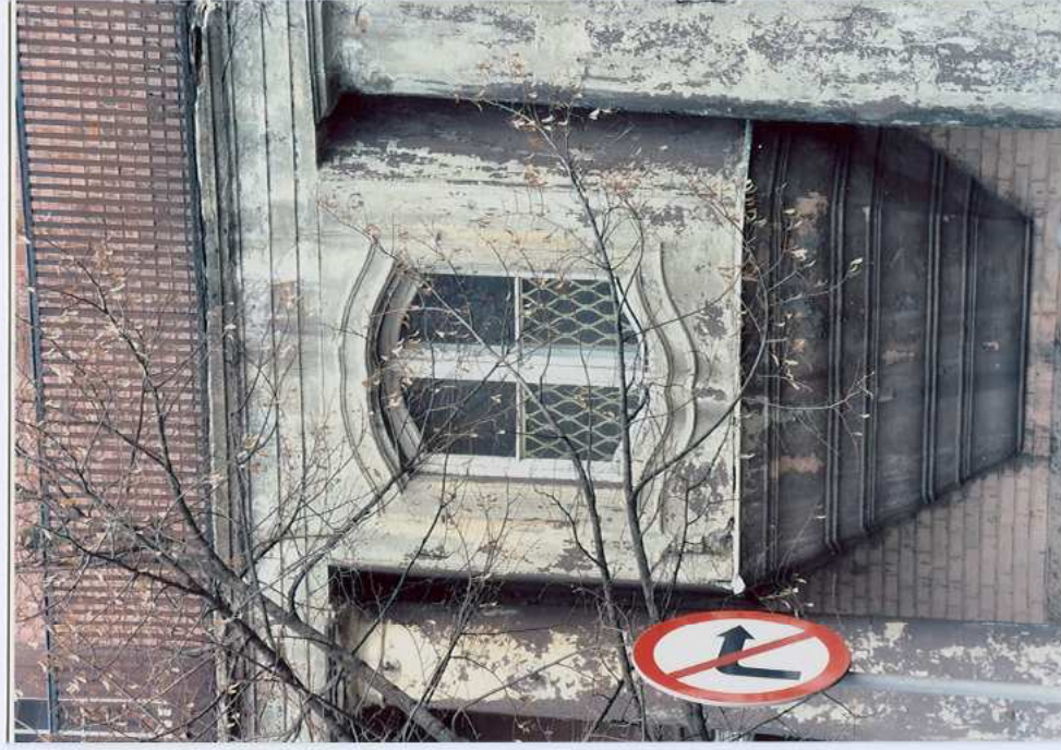
Fot. 6. Okno – portal wejściowy.
