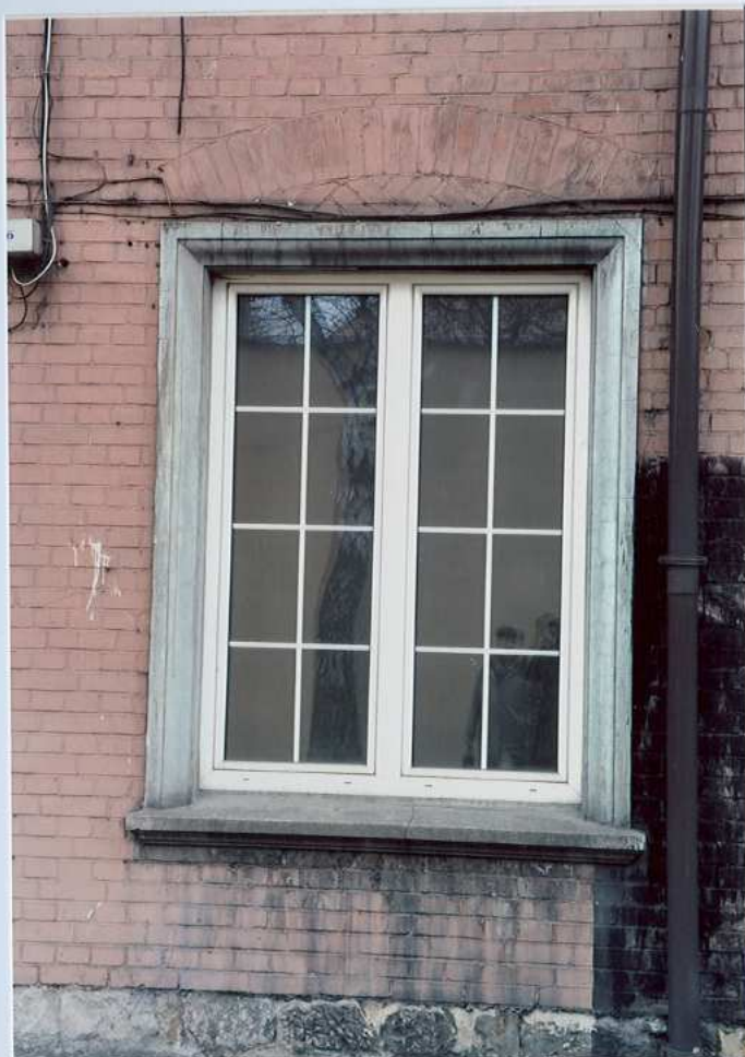
Fot. 30. Okno na parterze – elewacja wschodnia.
