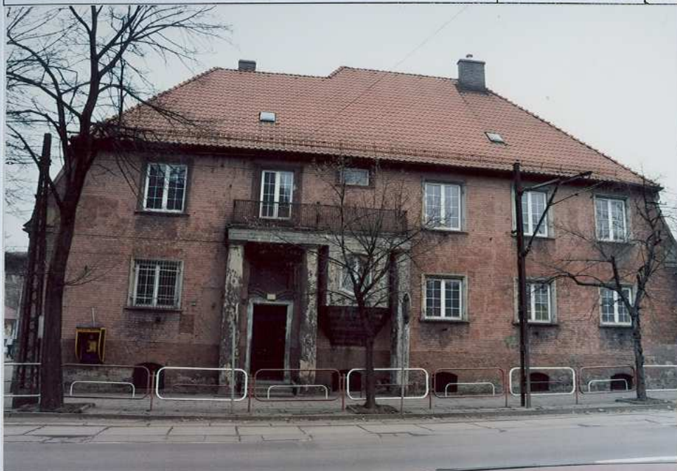
Fot. 1. Elewacja zachodnia.
