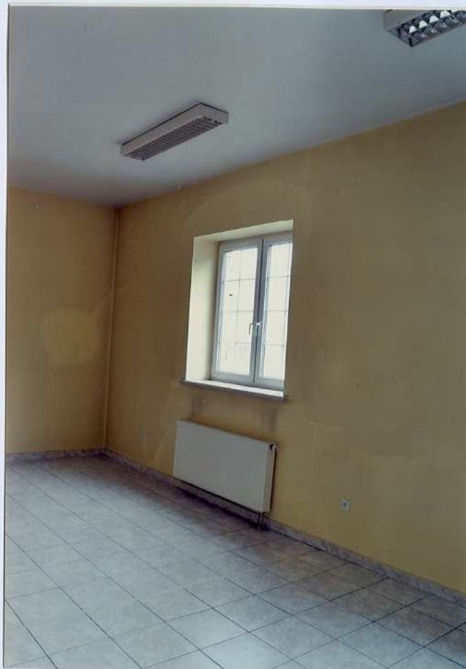
Fot. 44. Piętro – pomieszczenie.
