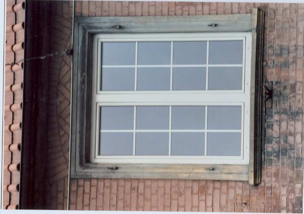
Fot. 15. Okno pierwszego piętra – elewacja zachodnia.
