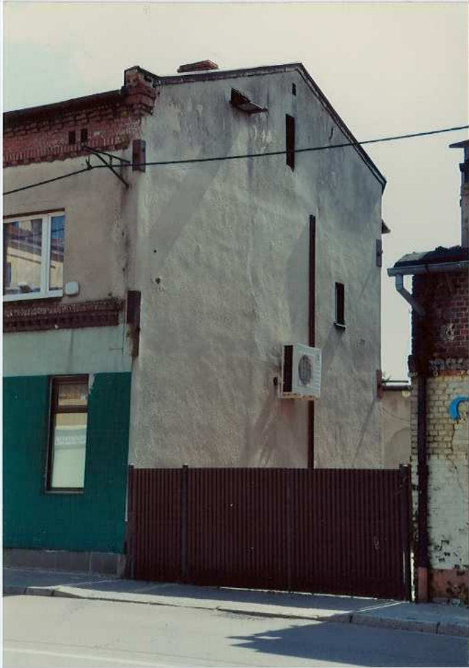
Fot. 5. Elewacja północna.
