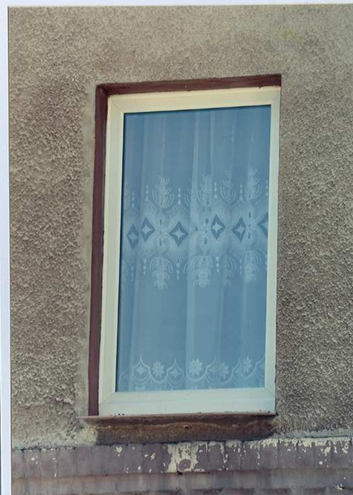
Fot. 14. Okno – piętro.
