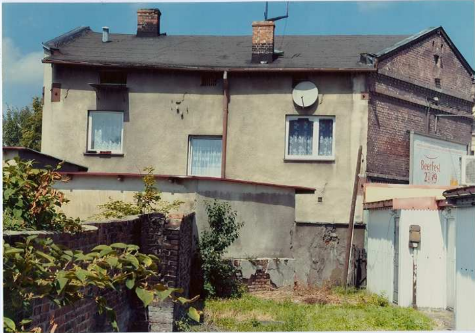
Fot. 18. Elewacja zachodnia.
