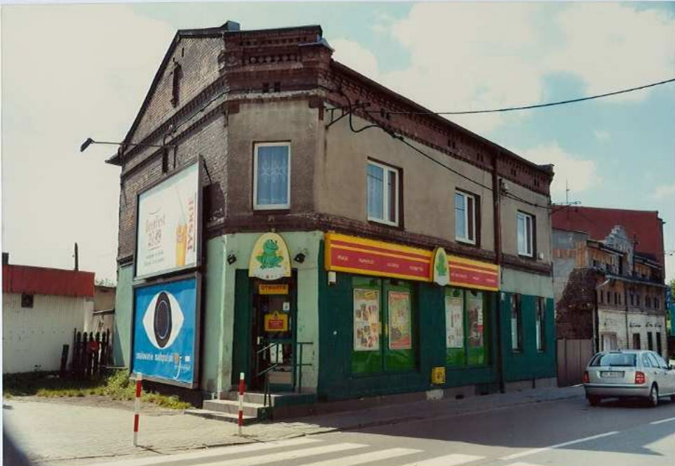
Fot. 8. Widok od strony południowej.
