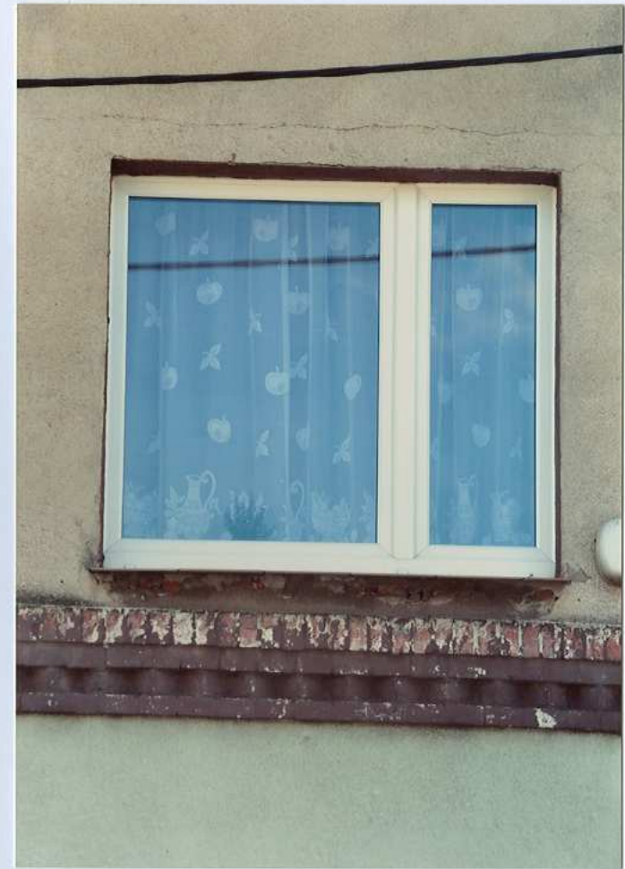
Fot. 7. Okno 1 piętra.
