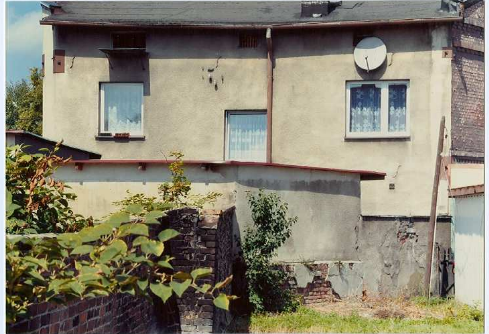
Fot. 19. Elewacja zachodnia.
