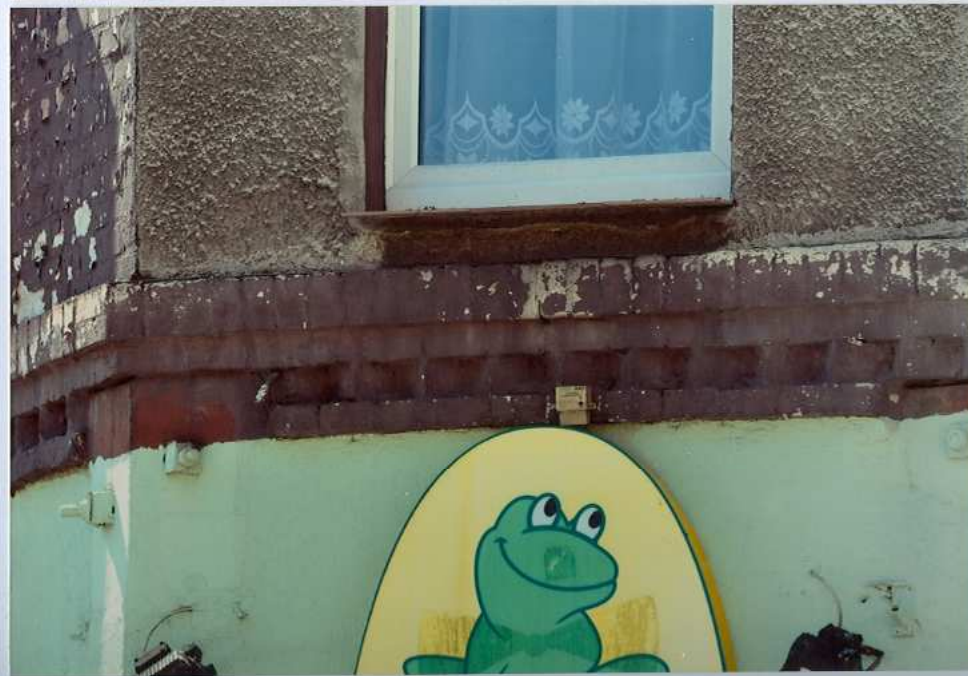
Fot. 11. Gzyms międzykondygnacyjny.
