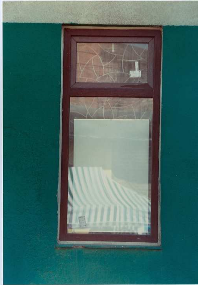
Fot. 6. Okno na parterze do lokalu usługowego.
