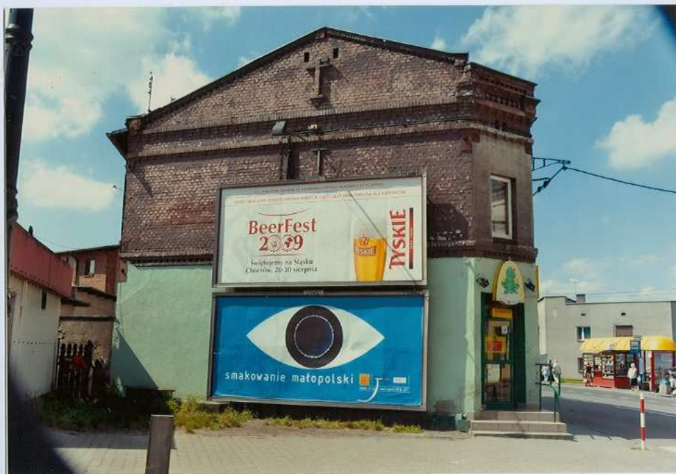
Fot. 15. Elewacja południowa.
