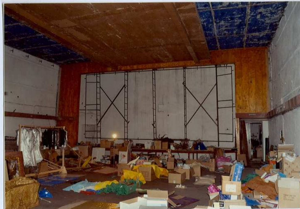
Fot. 48. Duża sala – wnętrze – widok na scenę.
