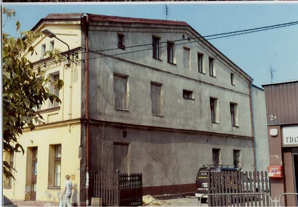
Fot. 16. Elewacja południowa- widok od strony zach.
