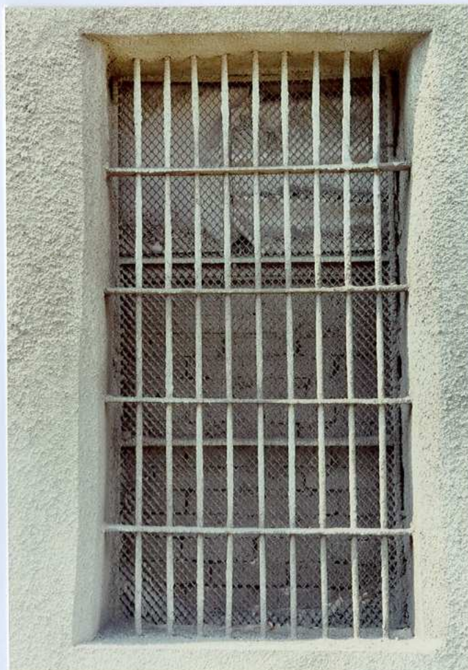
Fot. 19. okno parteru – elewacja południowa.
