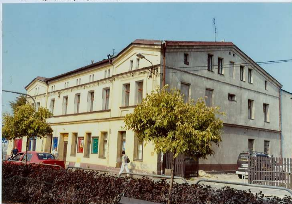
Ryc. 1. Widok ogólny od strony południowo - zachodniej.
