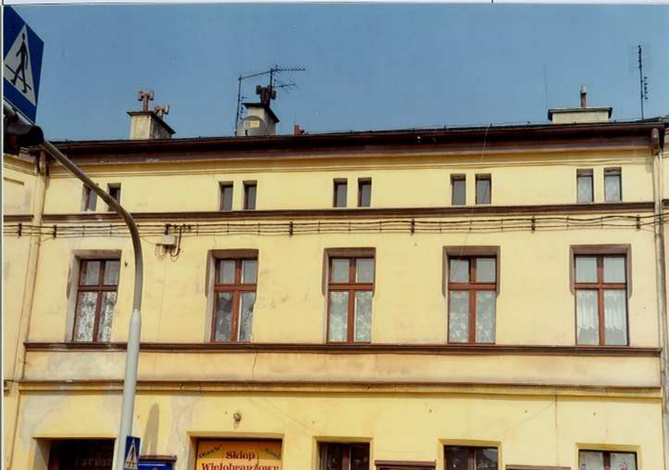
Fot. 8. Górna partia części środkowej budynku.
