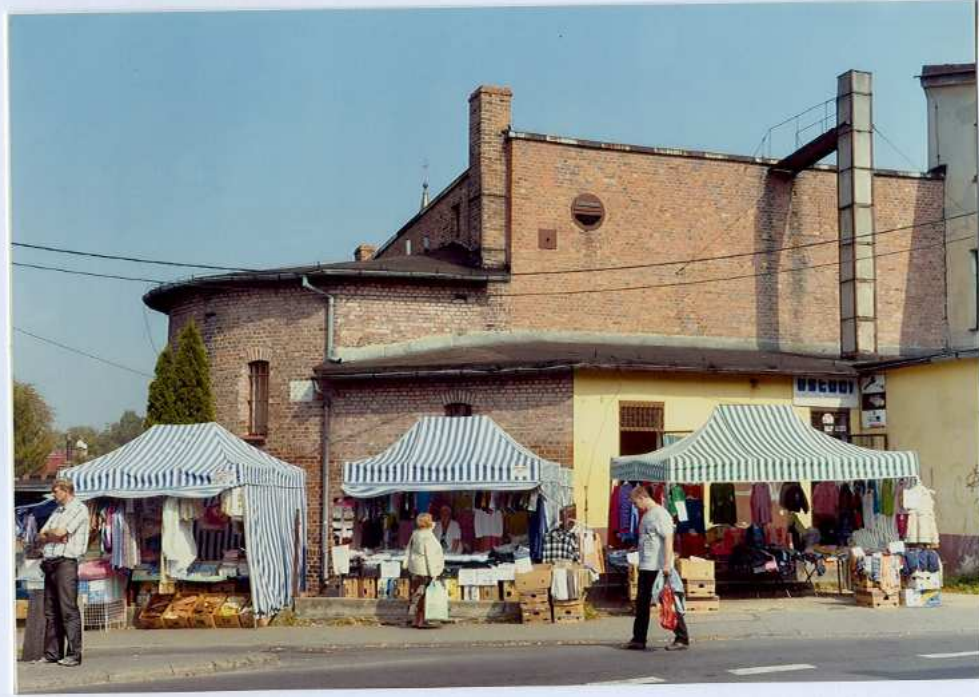
Fot. 26. Część północna elewacji zachodniej.
