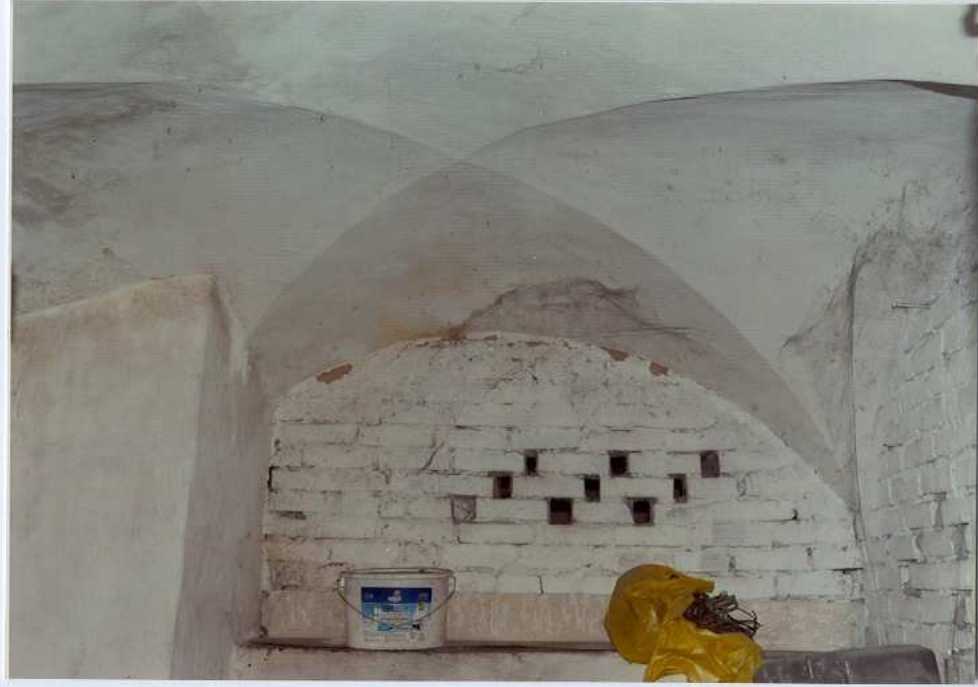
Fot. 60. Sklepienie klasztorne w piwnicy.
