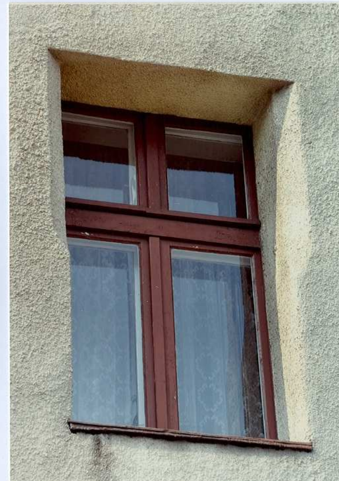
Fot. 20. Okno 1 piętra – elewacja południowa.
