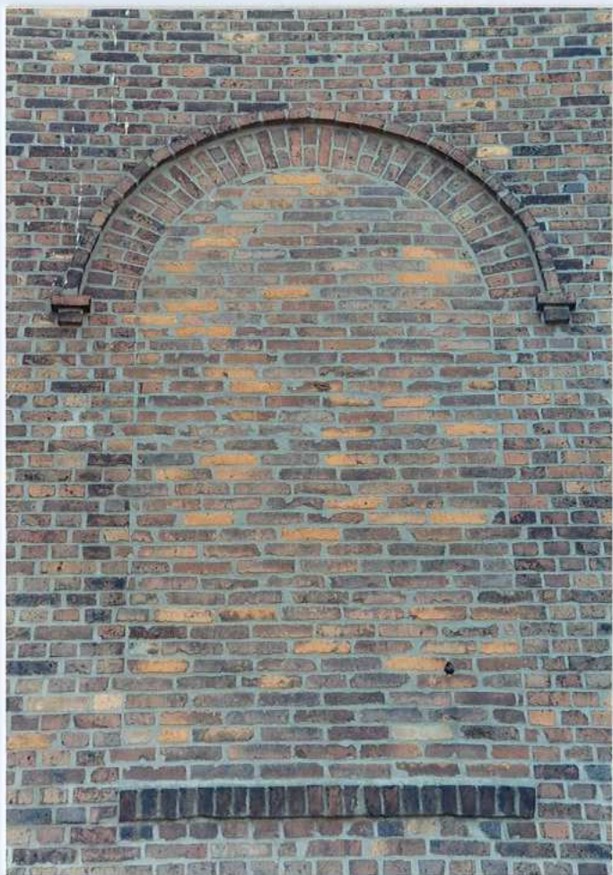
Fot. 38. Płycina – piętro elewacji dużej sali.
