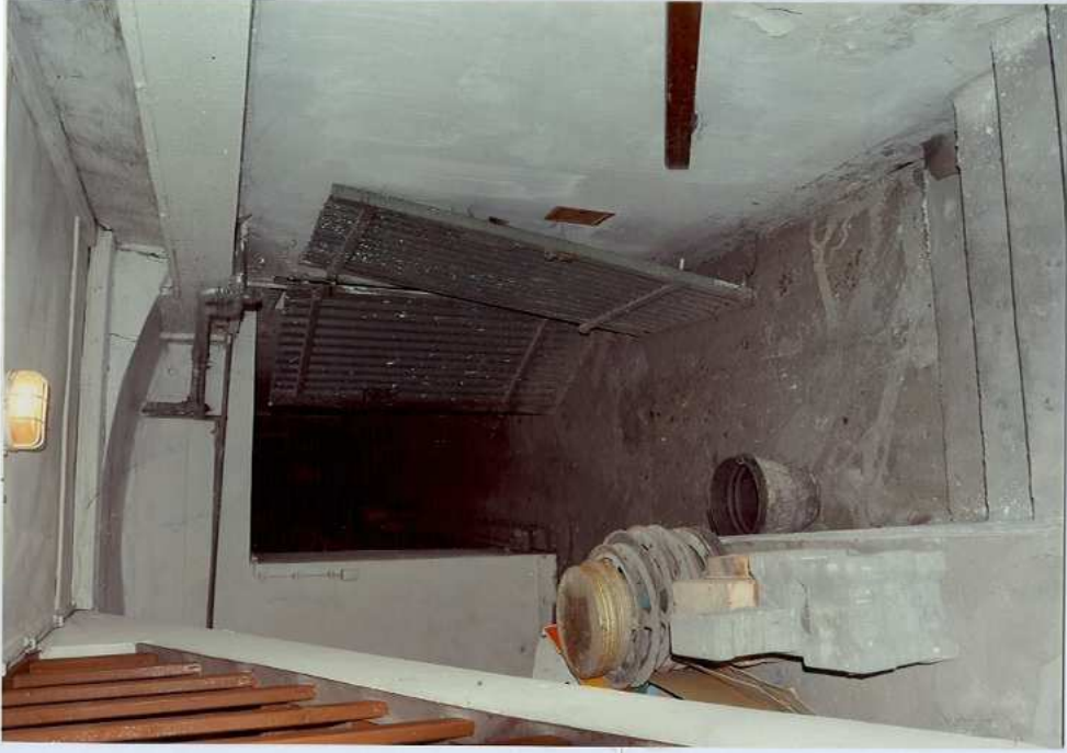
Fot. 58. Piwnice – korytarz.
