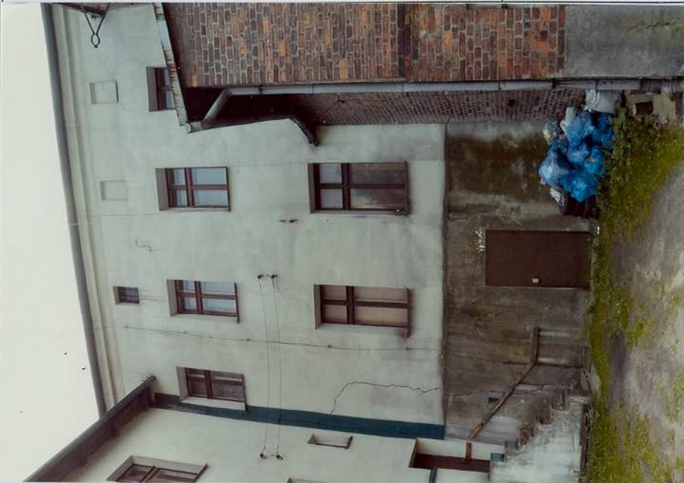
Fot. 42. Elewacja wschodnia – część południowa.
