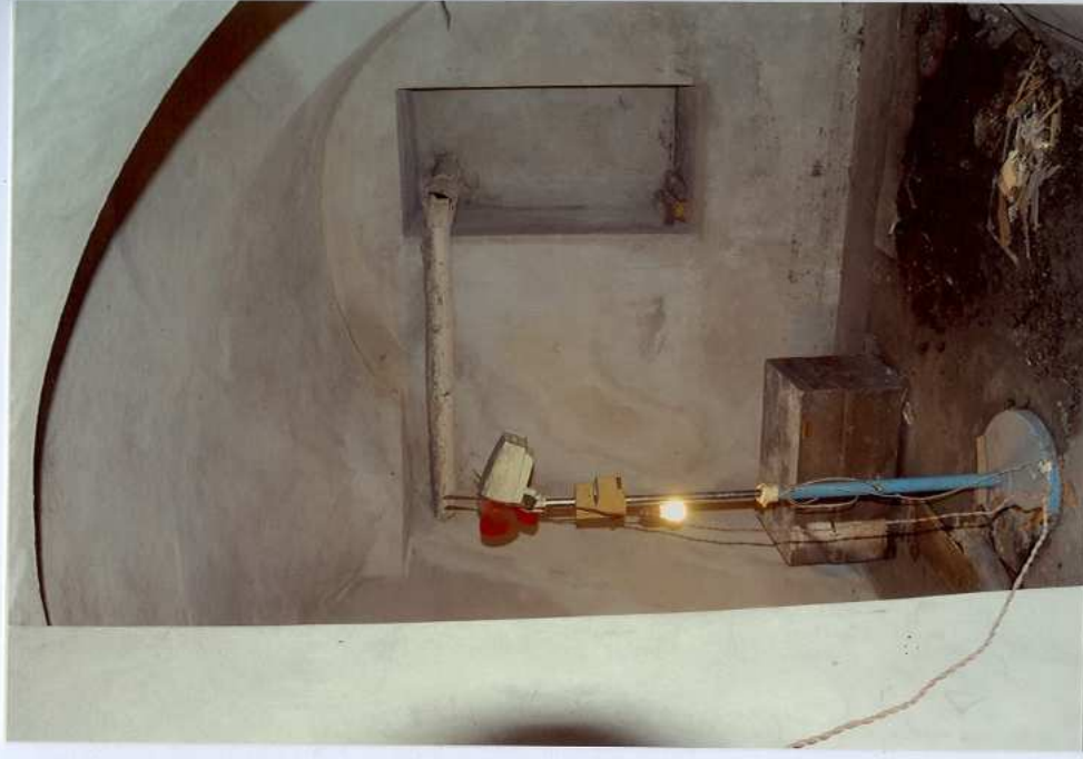
Fot. 59. Piwnice – wnętrze.
