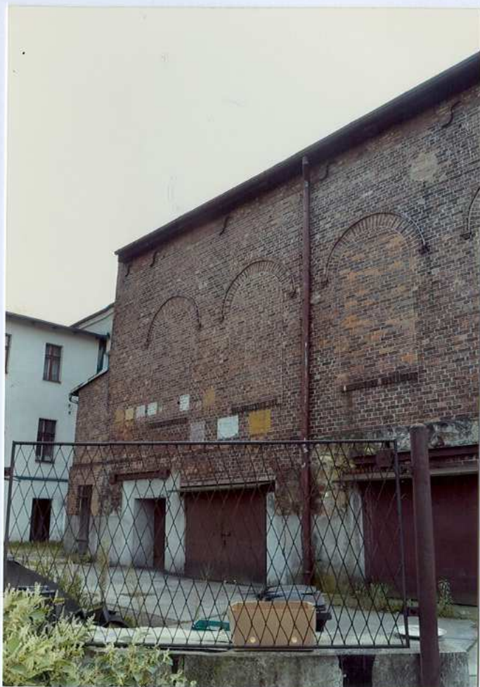
Fot. 31. Elewacja wschodnia – duża sala.
