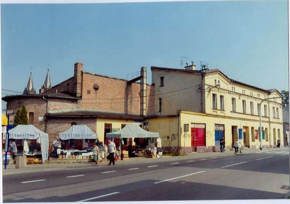
Fot. 25. Widok od strony północno – zachodniej.
