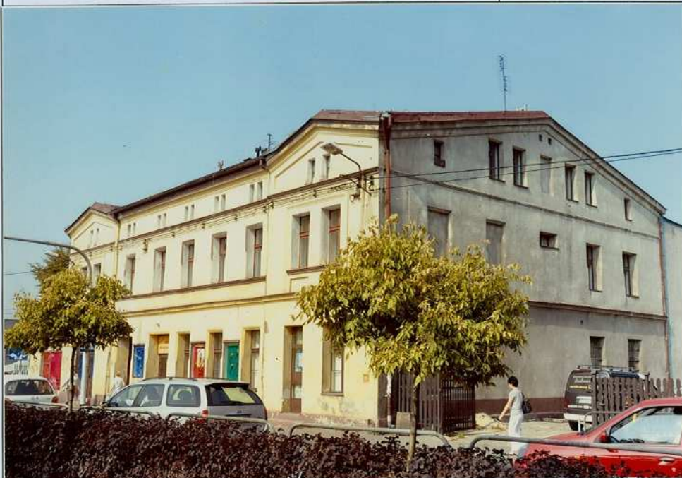
Fot. 15. Widok na budynek od strony południowo – zach.
