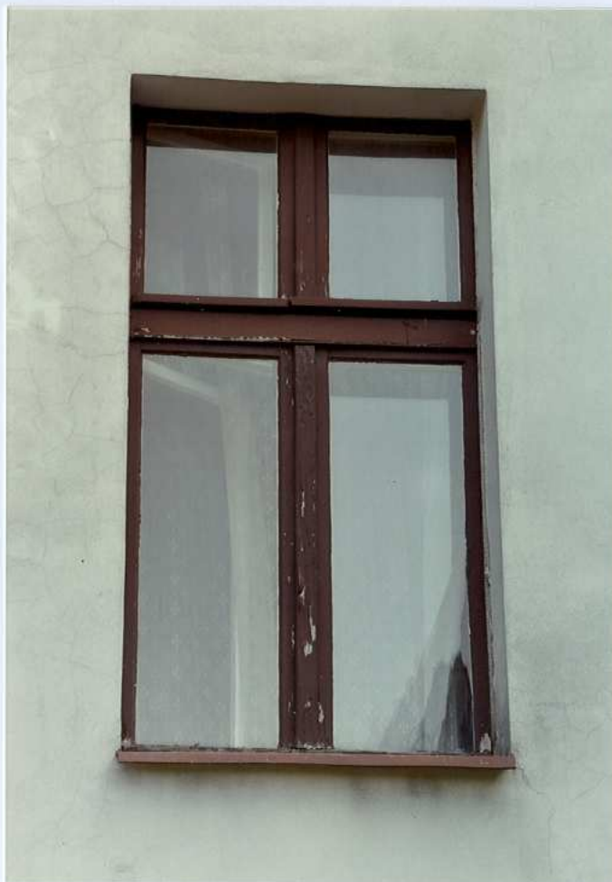
Fot. 45. Okno – elewacja wschodnia.
