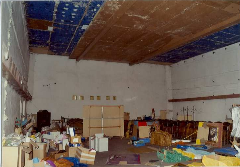
Fot. 47. Duża sala – wnętrze.
