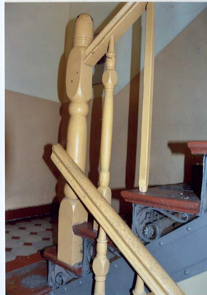
Fot. 29. Słupek balustrady.
