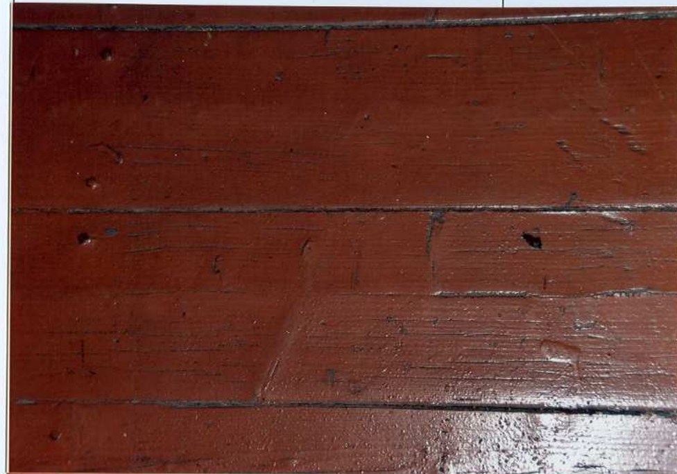
Fot. 34. Posadzka - podest.
