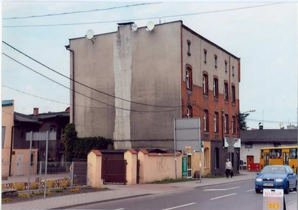
Fot. 19. Elewacja zachodnia.
