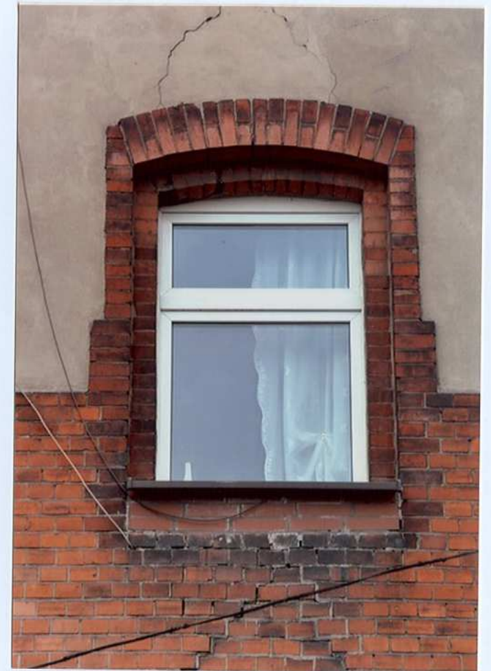
Fot. 6. Okno drugiego piętra – naroże – strona pld.-wsch.
