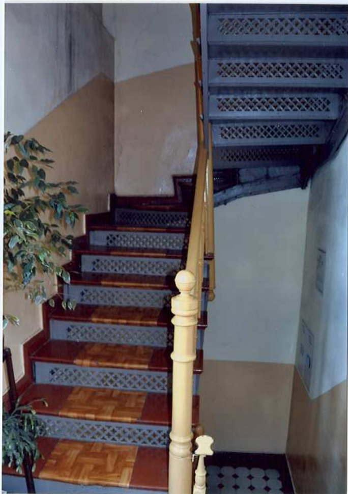
Fot. 27. Klatka schodowa.
