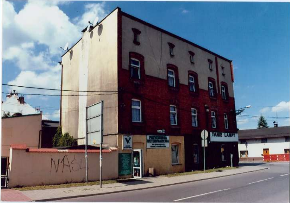
Fot. 18. Widok na budynek od strony płd. – zachodniej.
