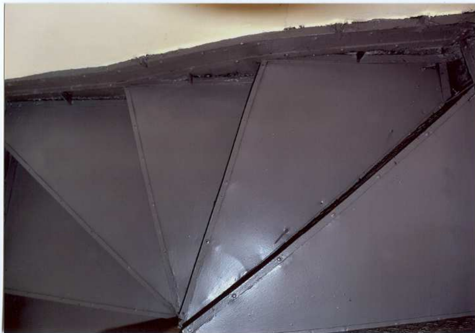
Fot. 31. Spód schodów.
