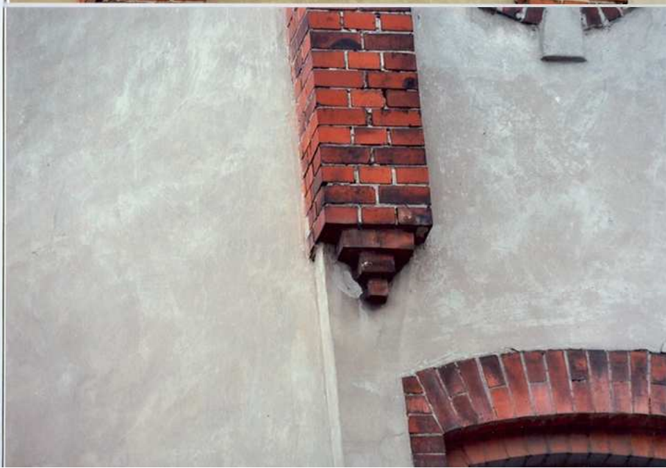
Fot. 9. Pilaster górnej partii naroża.
