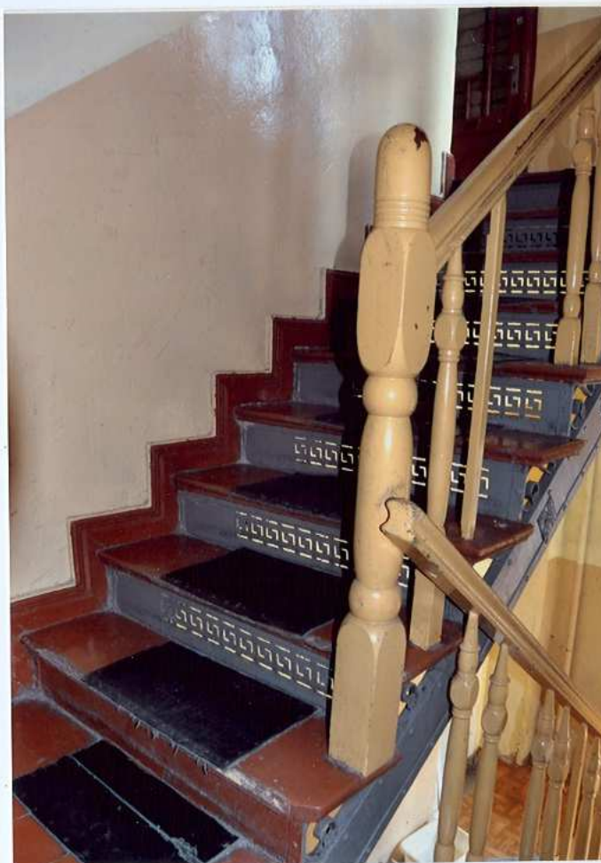
Fot. 28. Słupek balustrady.
