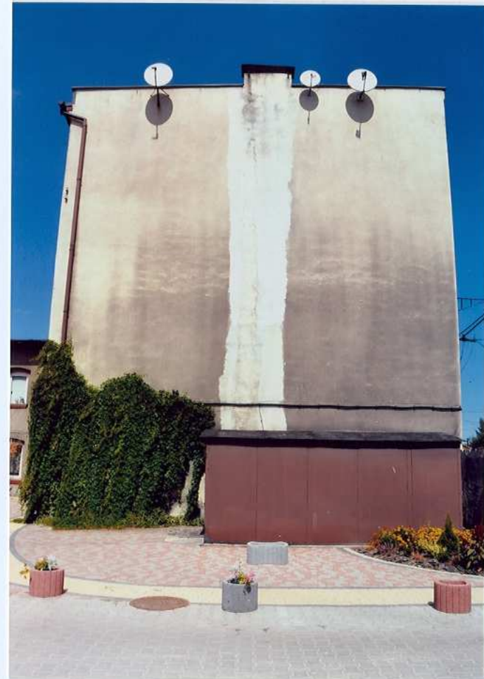
Fot. 20. Elewacja zachodnia.
