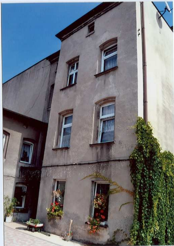
Fot. 21. Elewacja północna.
