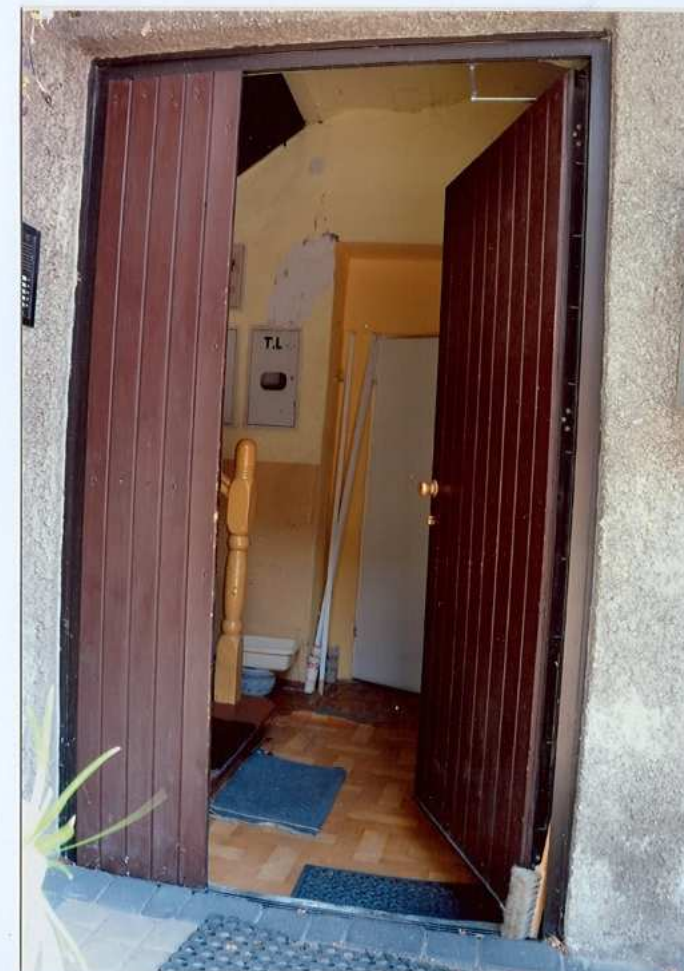
Fot. 23. Wejście do budynku.
