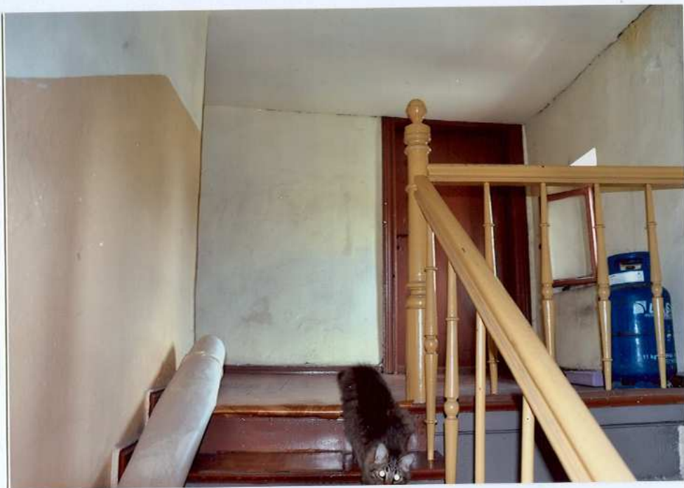
Fot. 30. Wejście na poddasze.
