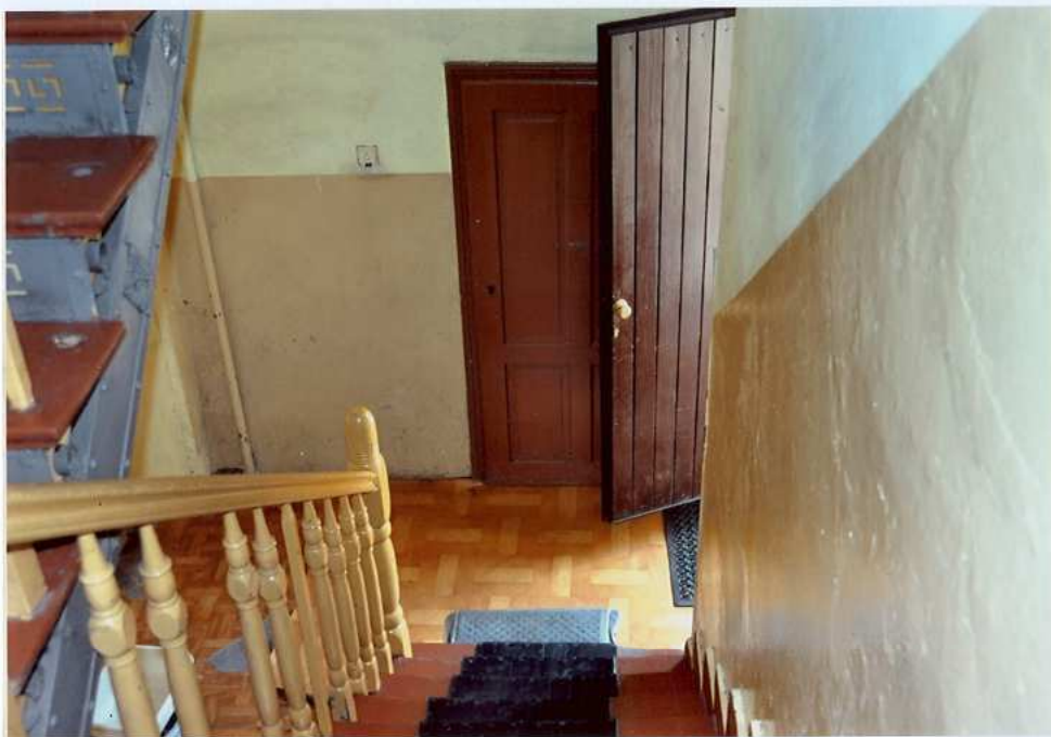
Fot. 24. Klatka schodowa.
