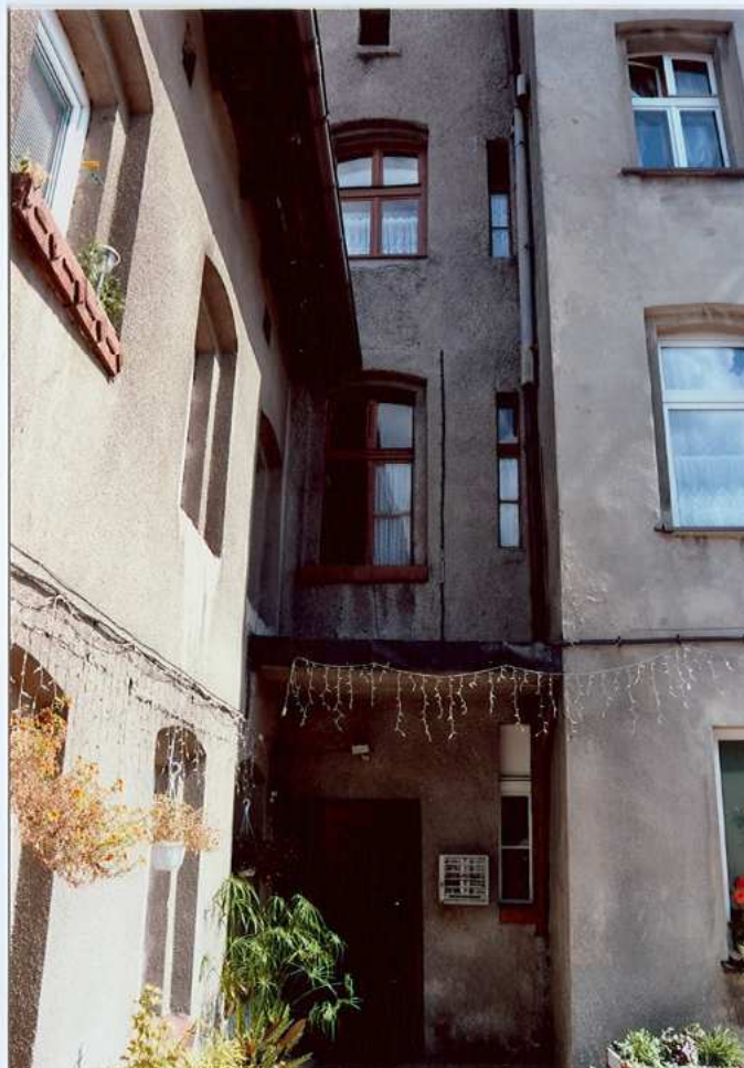
Fot. 22. Elewacja północna – strona wschodnia.
