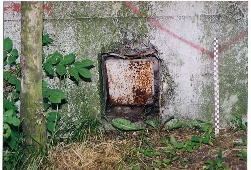
Wylot przewodu wentylacyjnego
