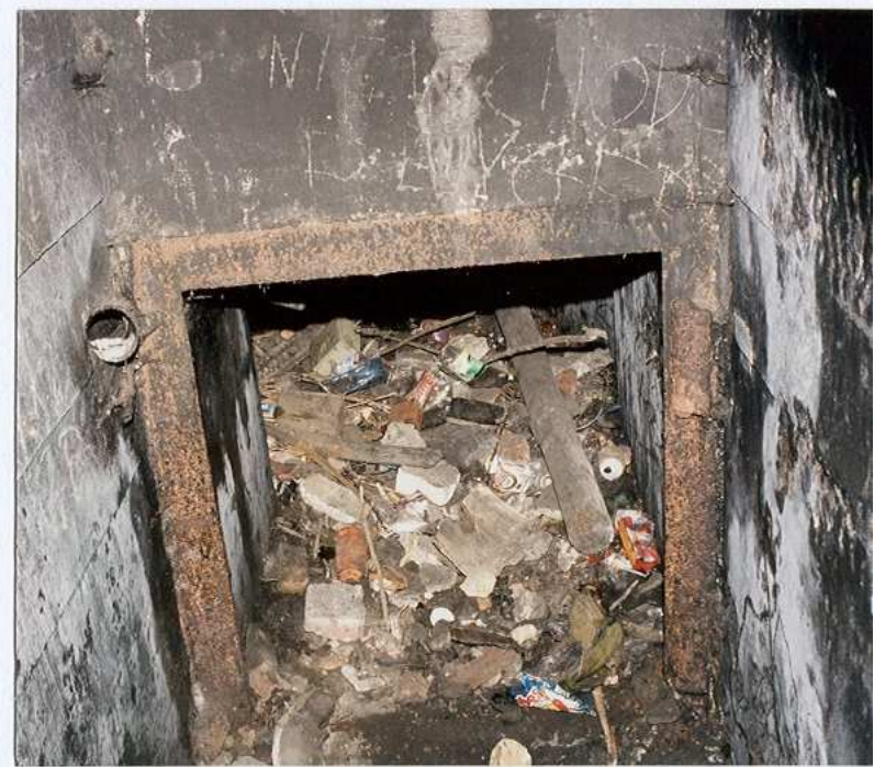
Wejście do szybu kopuły -h
