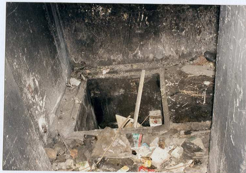
Studnia. komora amunicyjna -m... śmietnik!!!
