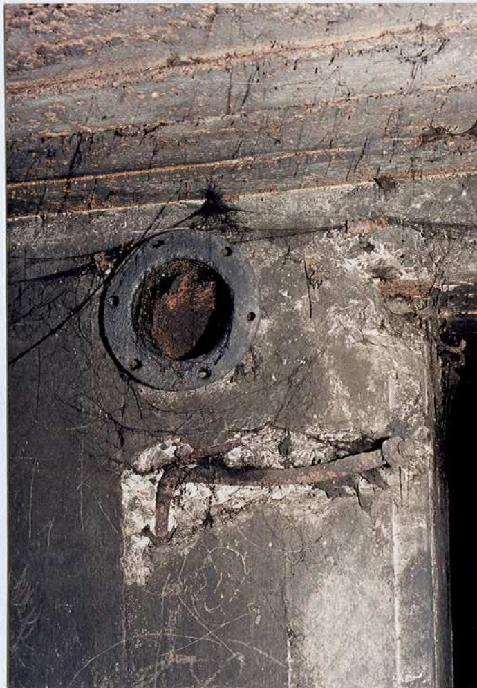
Kotwa mocująca „niegdyś” futrynę, izba -j
