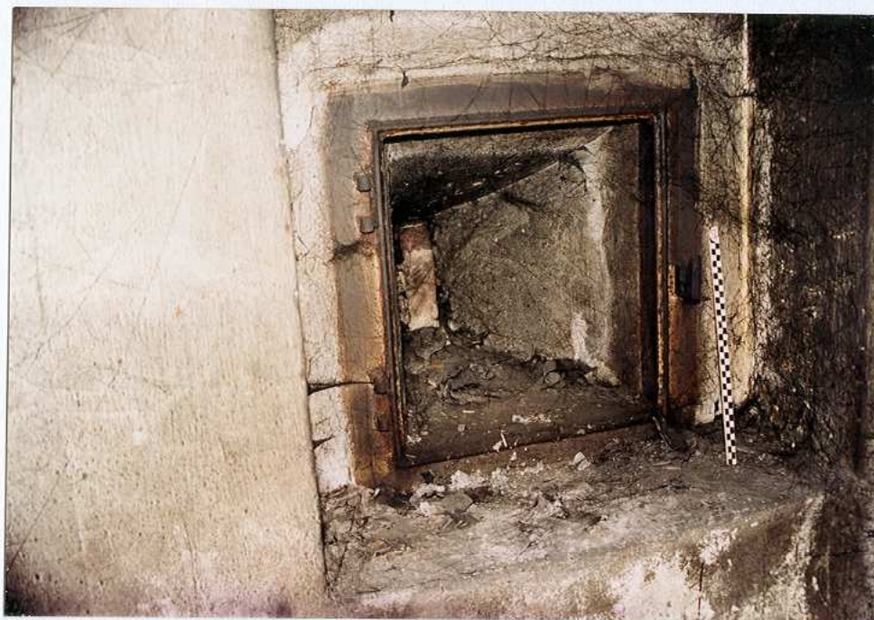
Strzelnica obrony wejścia, izba bojowa -e
