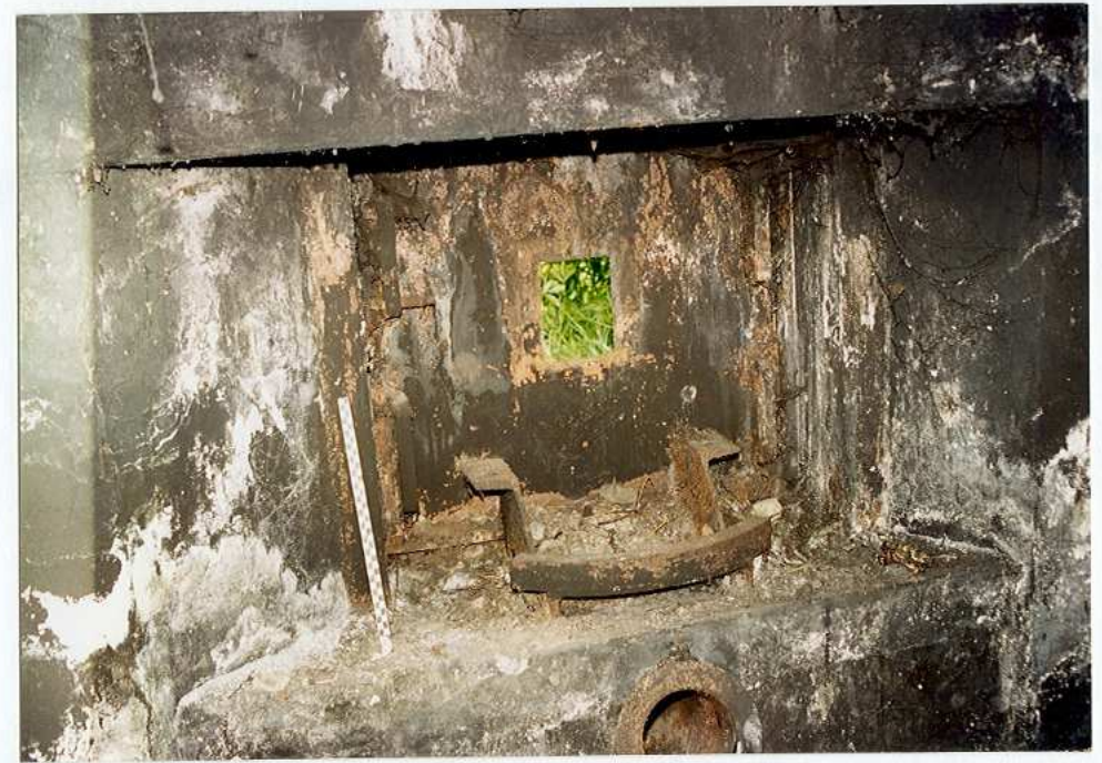
Izba bojowa „f”. Strzelnica ckm Pomieszczenie maszynowni „i”. Trasy kanałów wentylacyjno - instalacyjnych rozprowadzone w posadzce /ob. zagruzowane i zaśmiecone/
