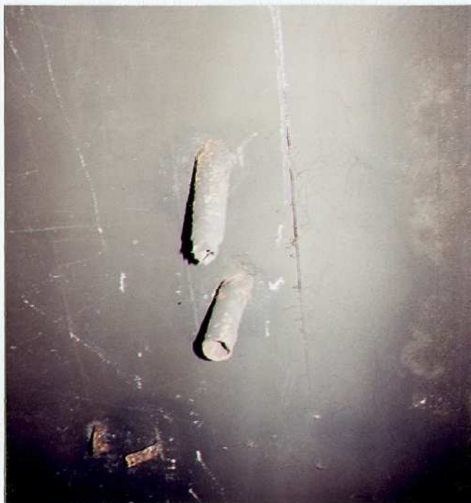
Izba dowodzenia „g”. Wyloty rur łączności głosowej z kopułą
