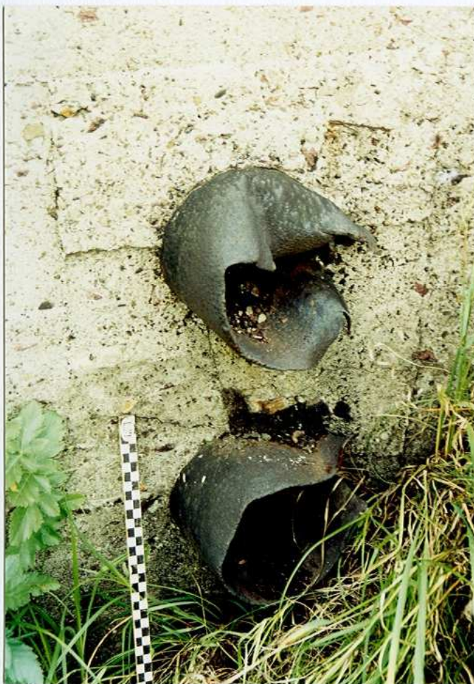
Rury aparatu sygnalizacji świetlnej
