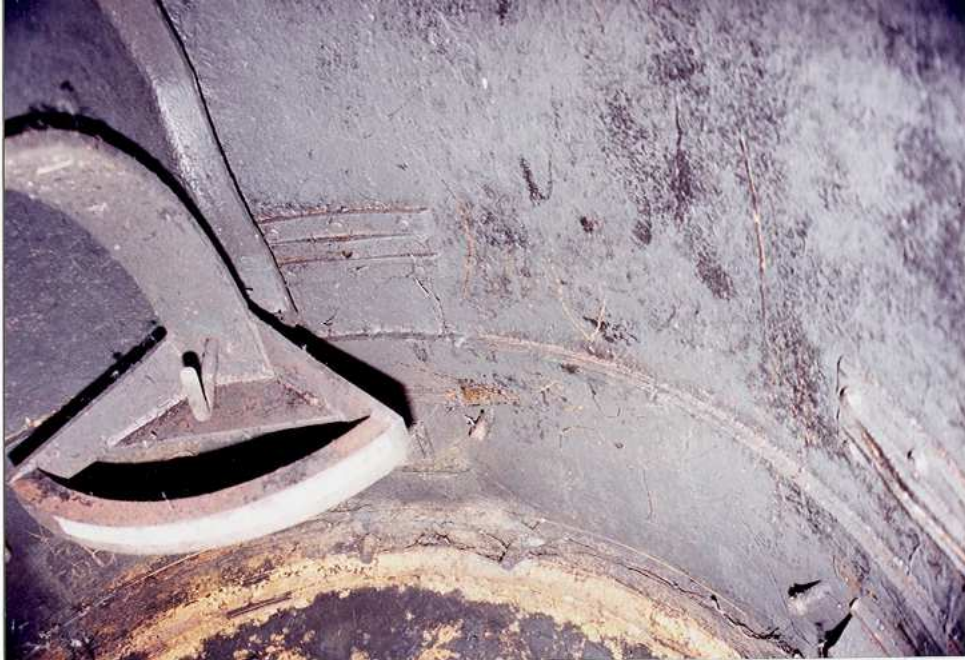
Kopuła ckm „l”. Zachowane ramię wahliwe podstawy ckm z uchwytem podziałki kątowej i blokady obrotu.
