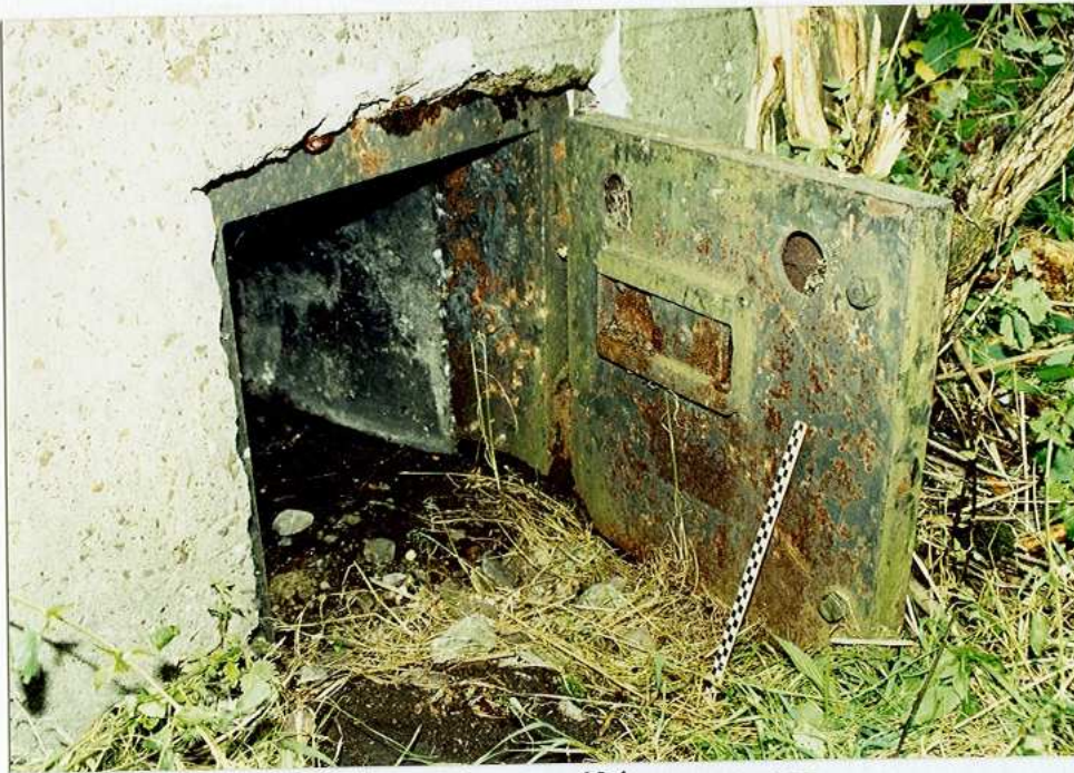
Drzwi zewnętrzne wyjścia zapasowego
