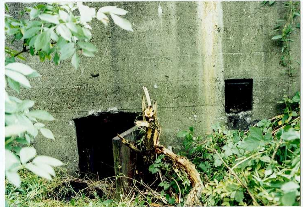
Ściana wsch. z wejściem zapasowym i wylotem wentylacji
