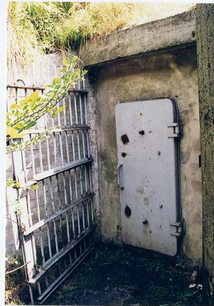
Widok wprowadzonych wtórnie zabezpieczeń
