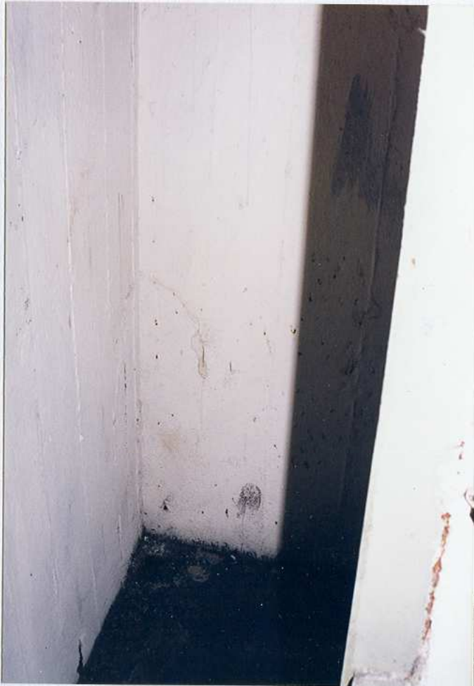
Pomieszczenie sanitariatu z miejscem po pisuarze
