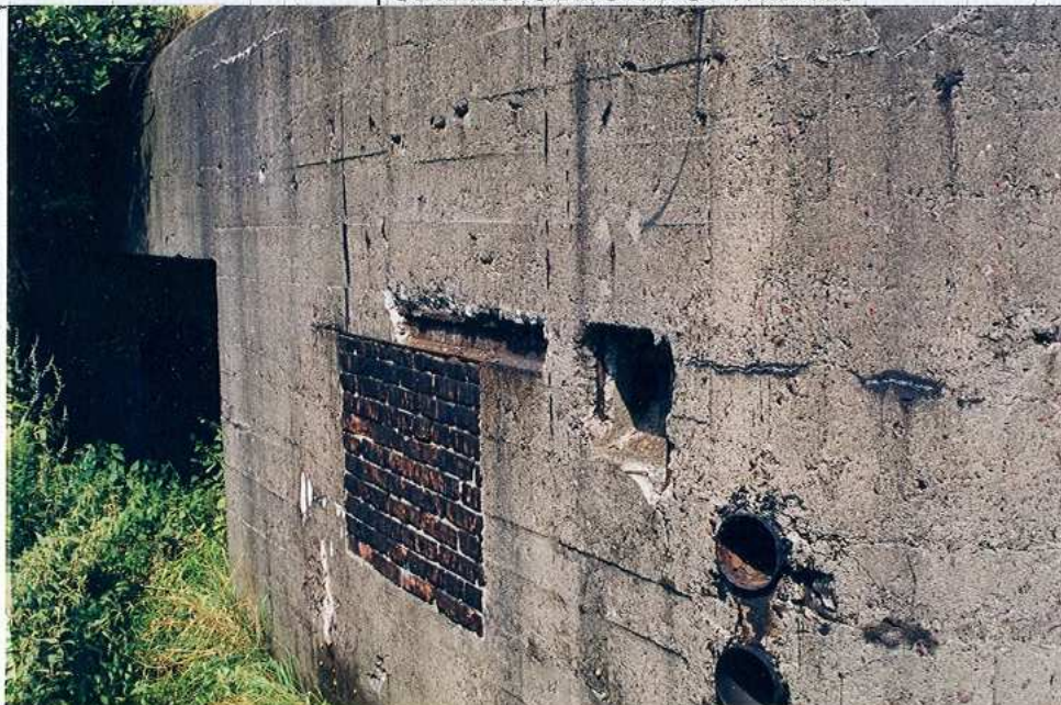
Widok partii pd - zach. z otworami strzelnicy karabinu maszynowego, wentylacyjnym, i sygnalizacji świetlnej
