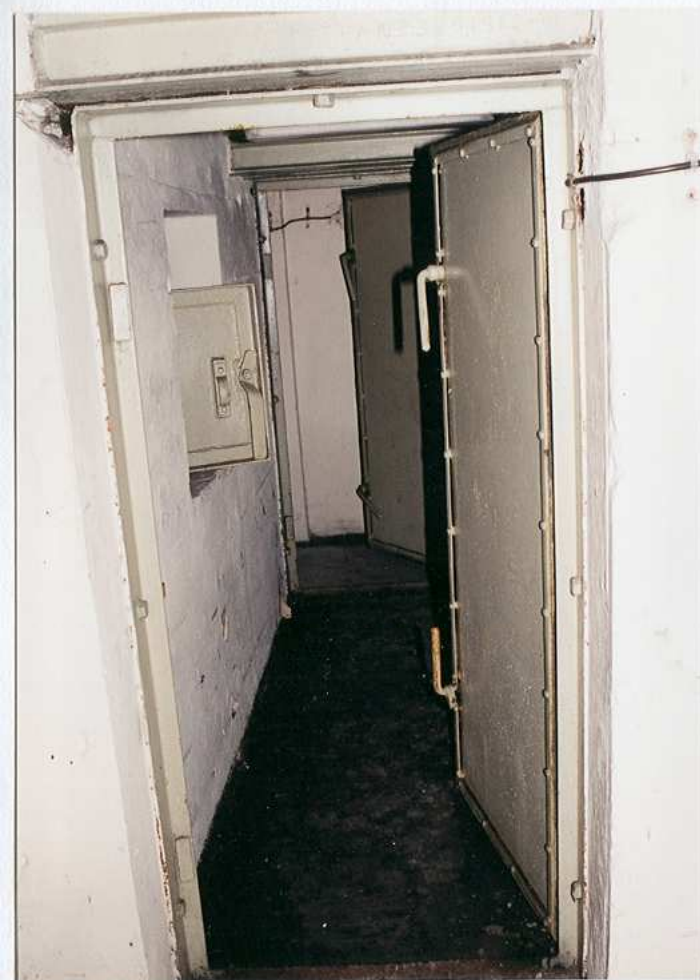
Przestrzeń słuzy gazowej korytarza wejściowego
