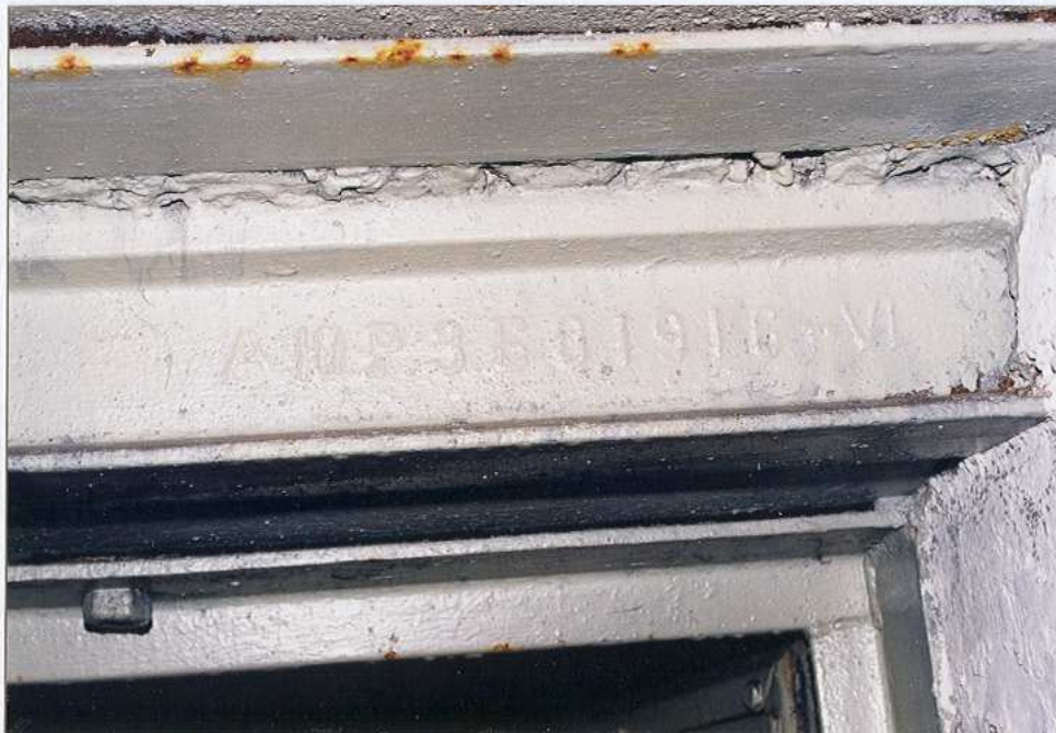
Oznakowanie szyn we wzmocnieniach stropu
