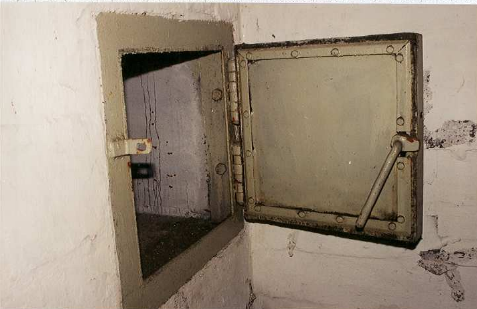
Wewnętrzne drzwi wyjścia zapasowego
