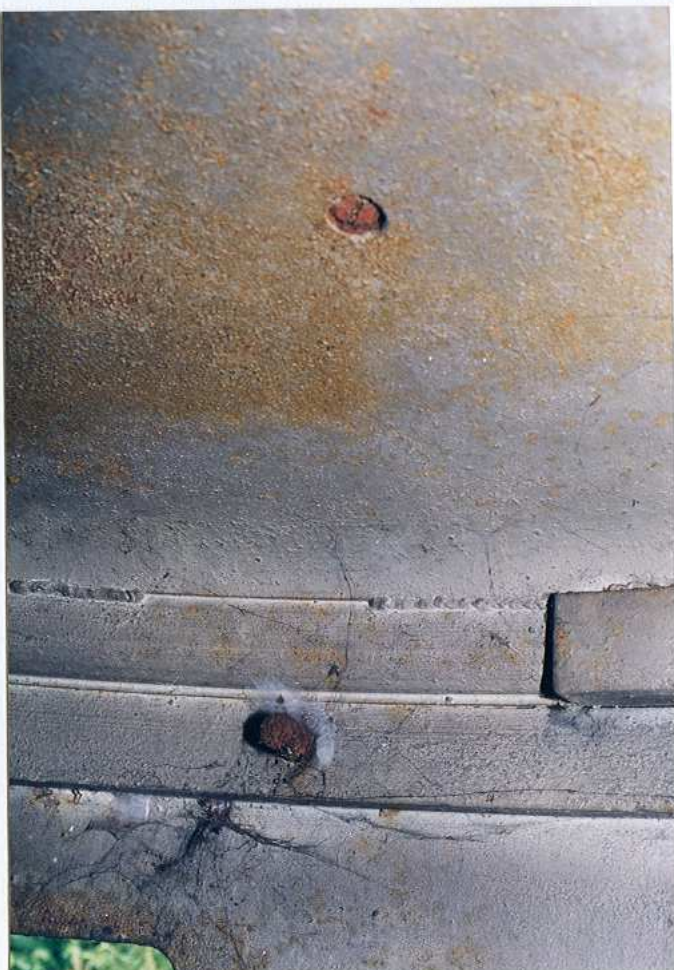
Mocowanie blachy przeciwodpryskowej stropu kopuły
