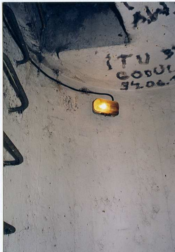
Szyb kopuły ckm
