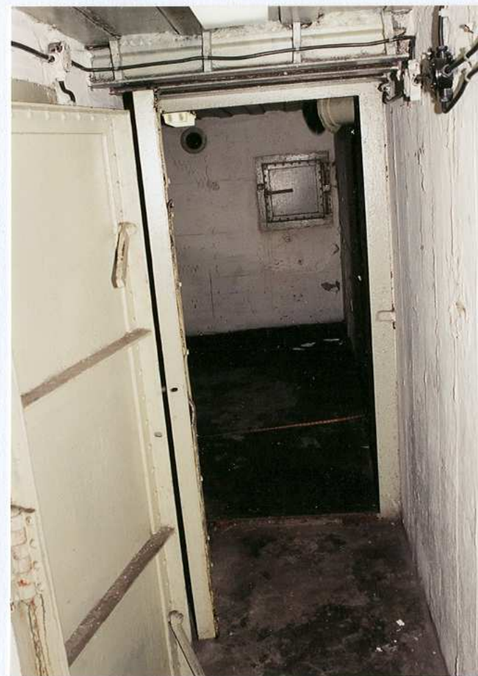
Widok z korytarza na izbę .....
