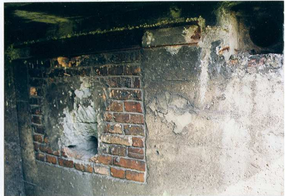
Zamurowany otwór strzelnicy armaty przeciwpancernej w partii pd - zach. schronu
