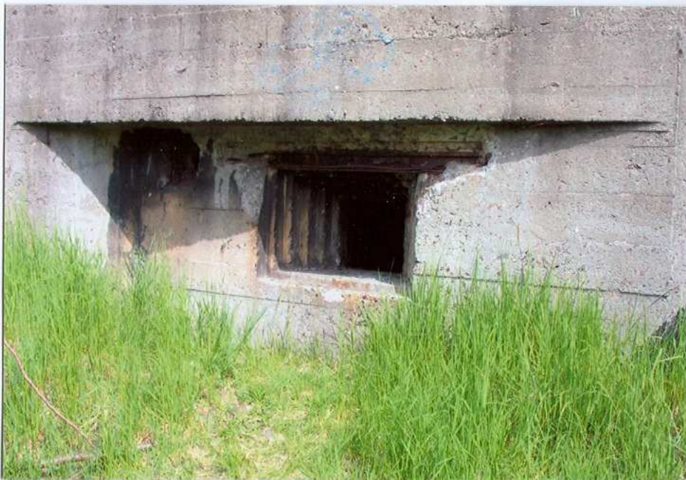
Południowa partia schronu. Strzelnica ckm
