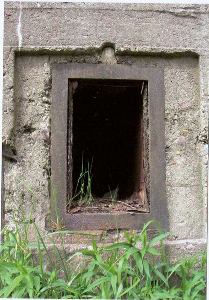
Otwór czerpni powietrza, z zerwanym zabezpieczeniem
