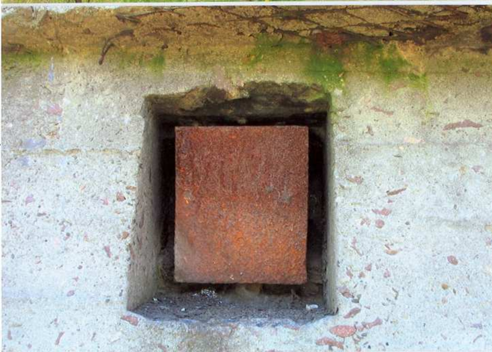
Północna partia schronu. Zabezpieczenie czerpni powietrza ←
