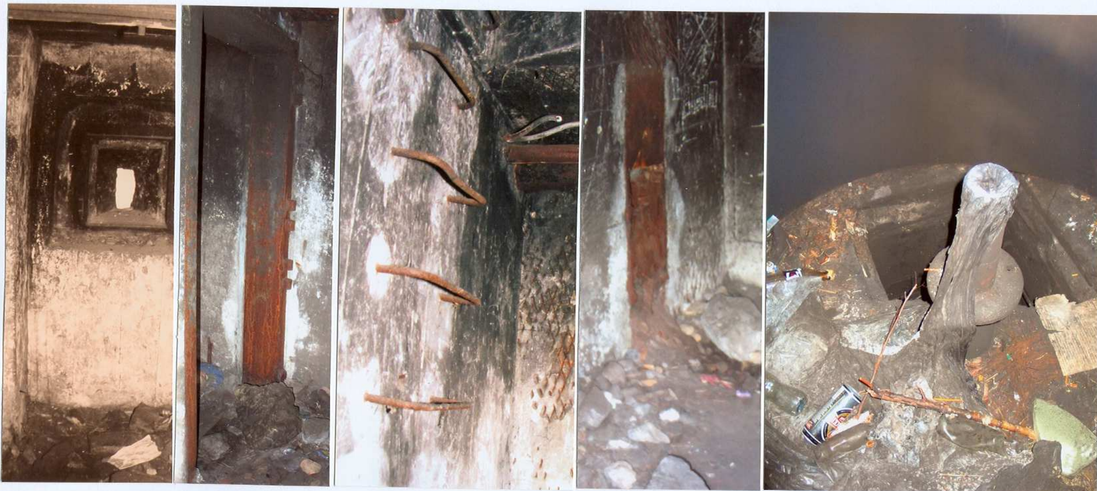
Kolejno od lewej: strzelnica obrony wejścia, wejście z przedsionka do śluzy gazowej, klamry w szybie kopuły pancernej, obudowa kanału czerpni powietrza w izbie bojowej południowej, wnętrze kopuły pancernej.
