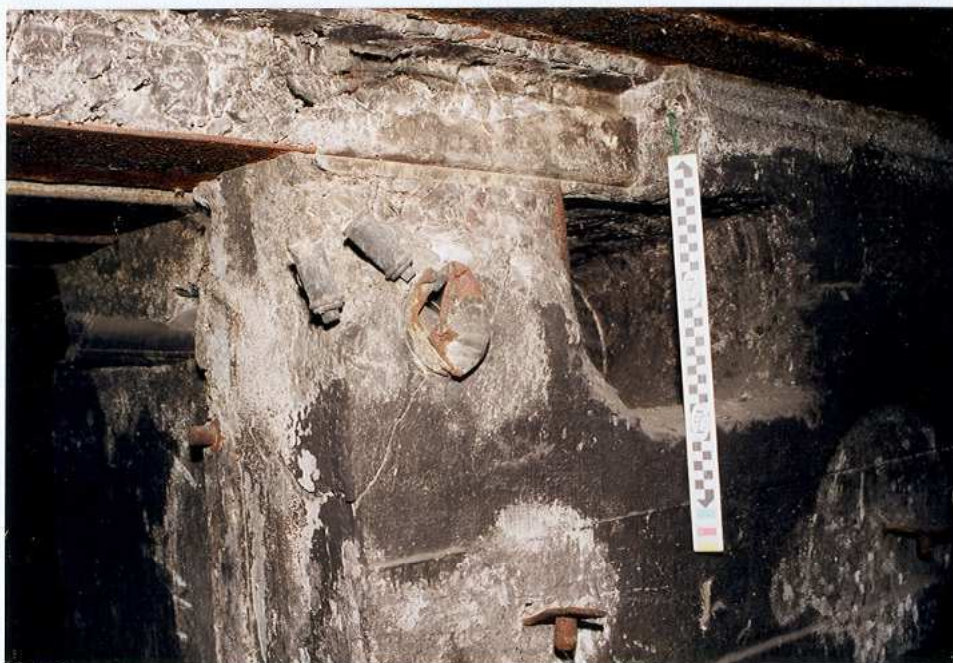
Pozostałości instalacji chłodzenia ckm-ów oraz wykuty otwór wentylacyjny izbie dowodzenia e
