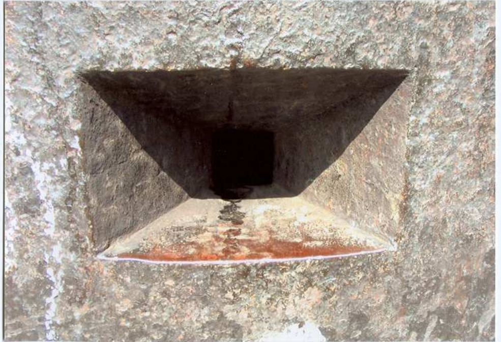
Otwory strzelnic dla ckm w kopule pancernej Otwory obserwacyjne w kopule
