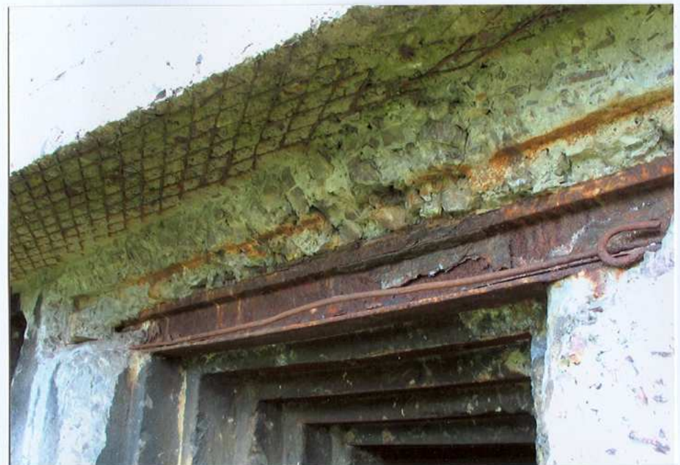
Południowa partia schronu. Odslonięte zbrojenia i zabezpieczenia przy otworze strzelnicy ckm
