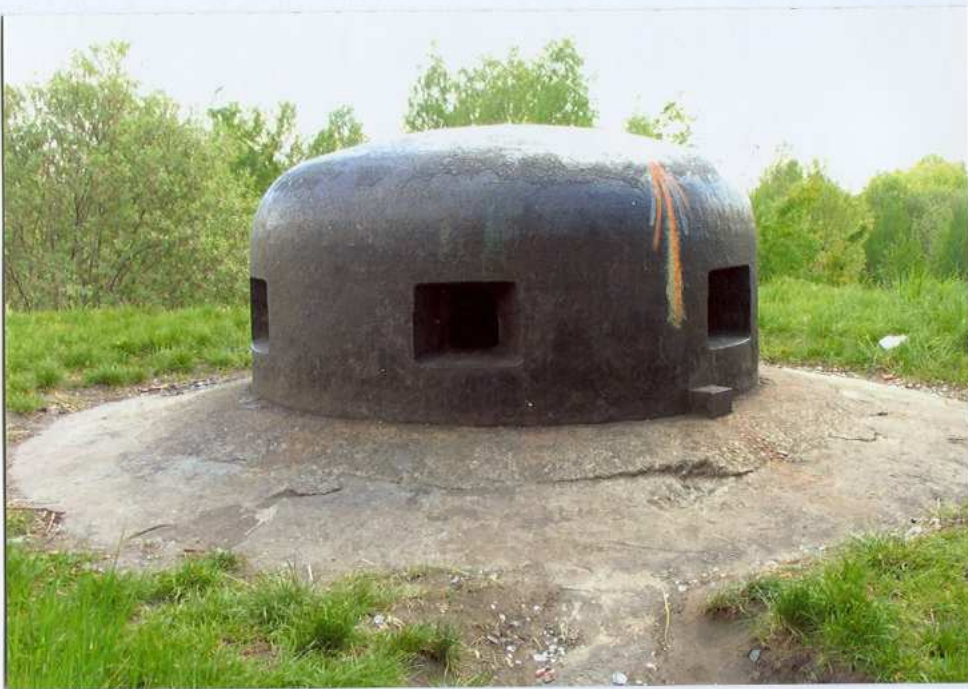
Pancerna kopuła z otworami strzelnic dla ckm Pancerna kopuła od strony otworów obserwacyjnych
