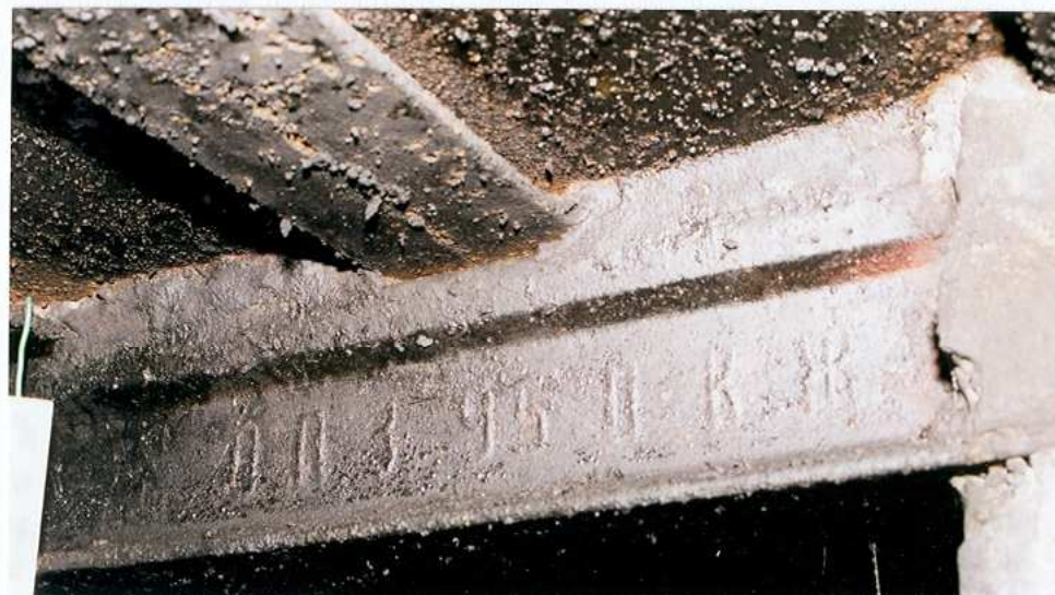
Szyny nadproża jednego z otworów wejściowych z rosyjskimi znakami producenta
