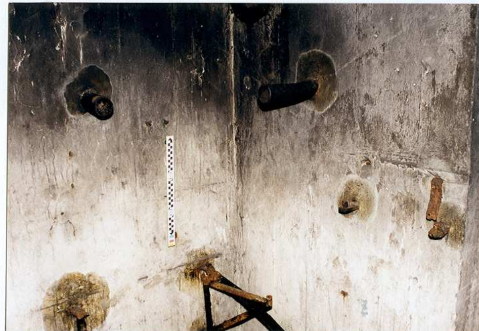
Izba ..d..... Stanowisko dowodzenia
