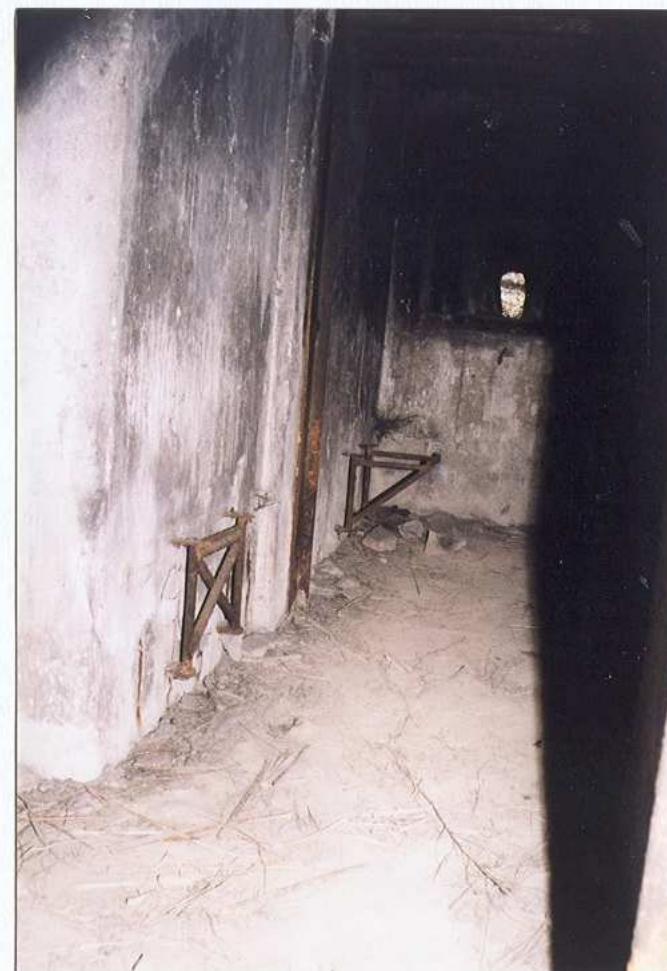
Korytarz /fragment pd/ z widokiem na strzelnicę obrony wejścia
