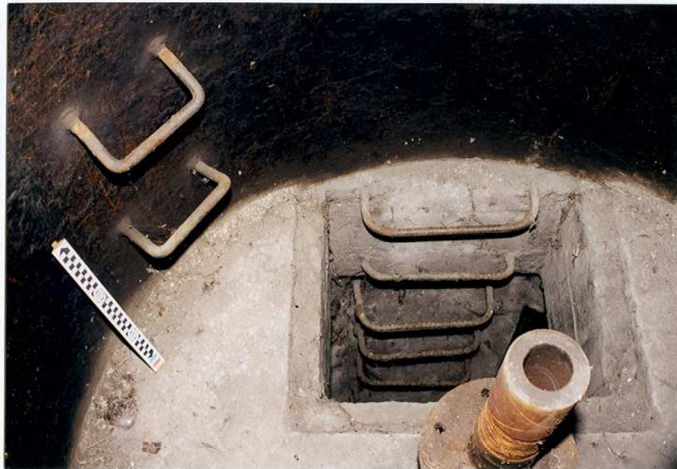
Wejście do kopuły oraz stojak podstawy ckm
