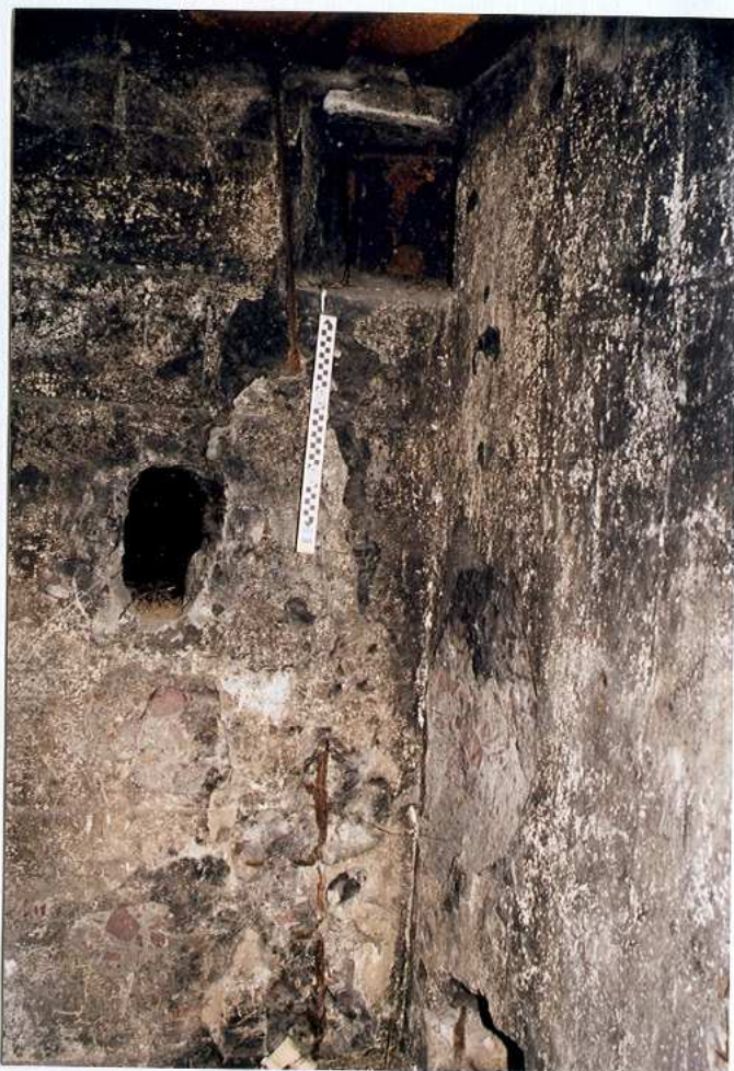
Widok strzelnicy przedsionka od strony głównego wejścia /także przysłona otworu wentylacyjnego/
