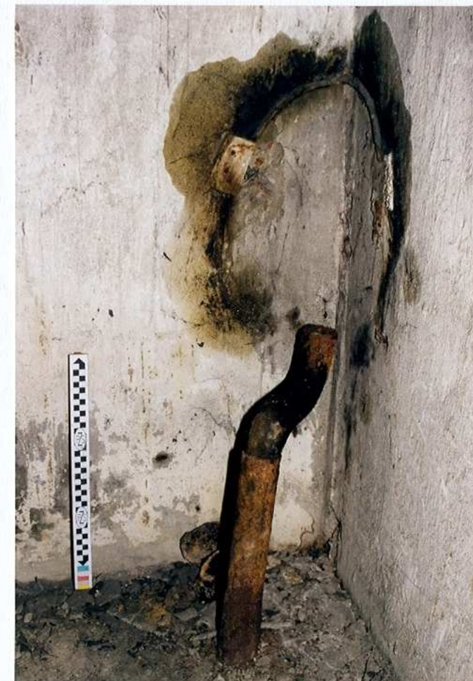
Pomieszczenie sanitariatu. Miejsce na pisuar
