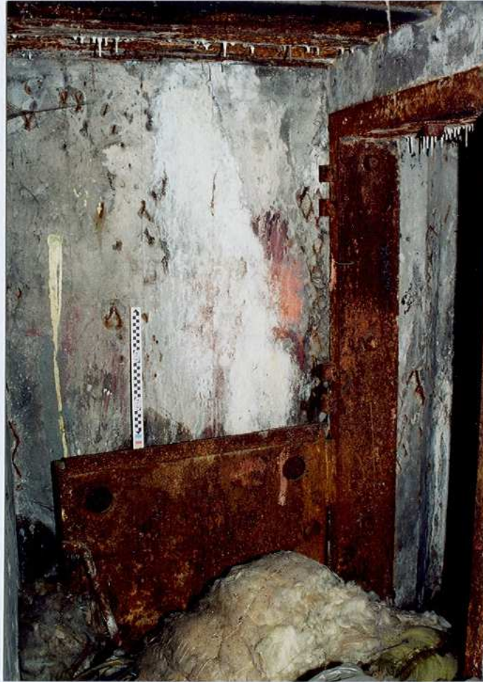
Otwór głównego wejścia
