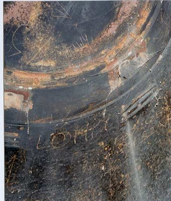
Widok wnętrza kopuły ckm
