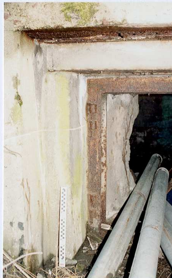
Fragment strzelnicy armatniej oraz przysłona otworu wentylacyjnego /po lewej stronie strzelnicy/
