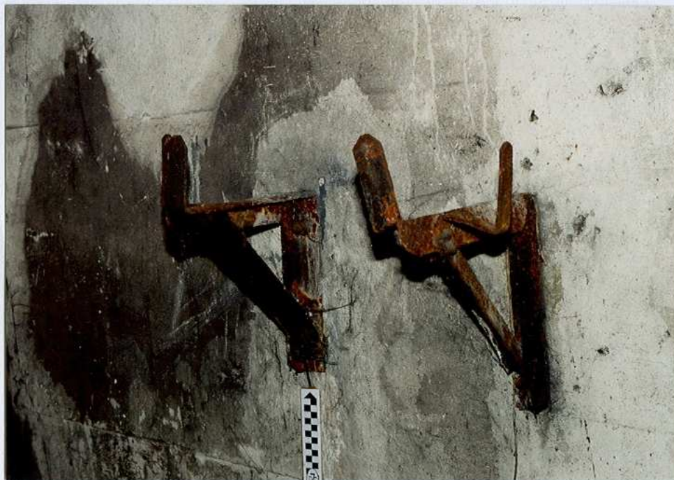
Izba bojowa ckm, podpory stałej pólki przyściennej
