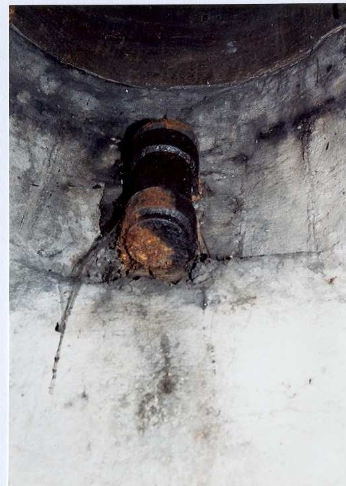
Element w podstawie kopuły obserwacyjnej- uchwyt siedziska
