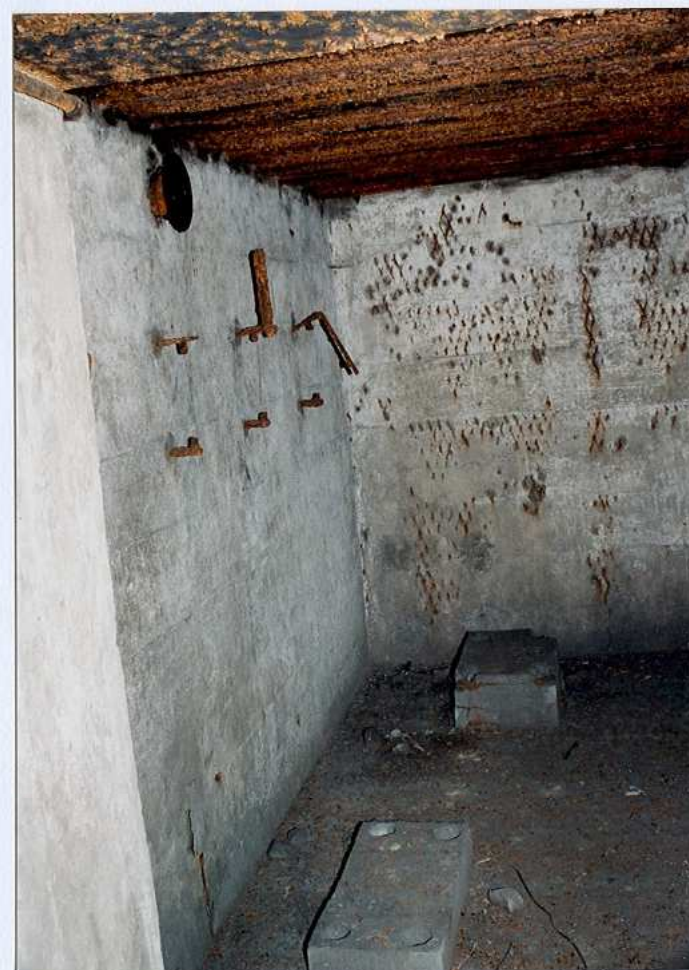
Fragment wnętrza /maszynownia/
