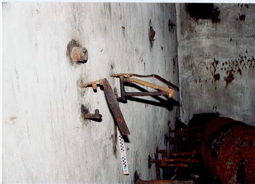
Izba dowodzenia- pulpit dowódcydestrukt i rury głosowe
