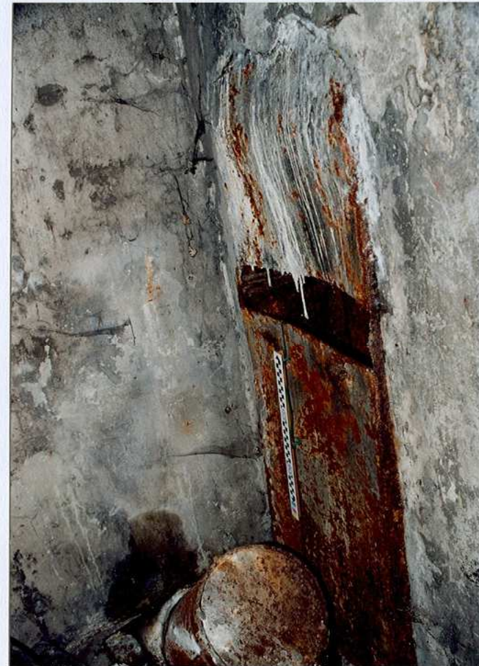
Przewody czerpni powietrza w korytarzu
