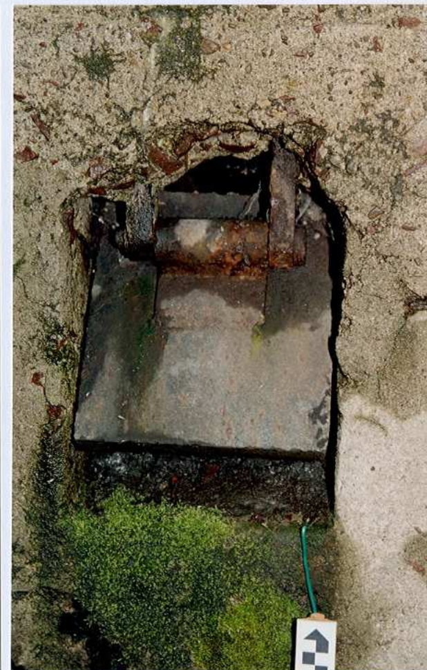
Fragment strzelnicy armatniej oraz przysłona otworu wentylacyjnego /po lewej stronie strzelnicy/
