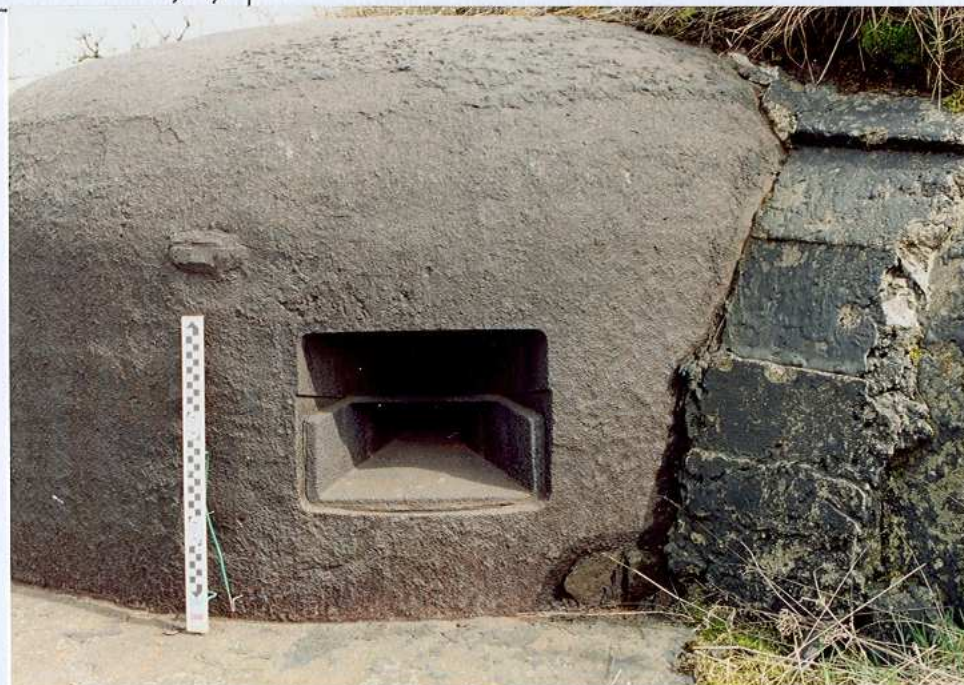
Strzelnica zach. kopuły ckm Widok kopuły obserwacyjnej
