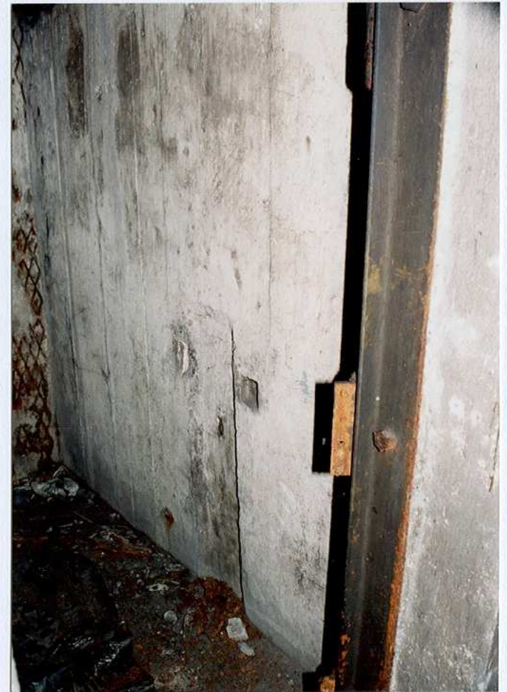
Pomieszczenie – wc, miejsce pisuaru
