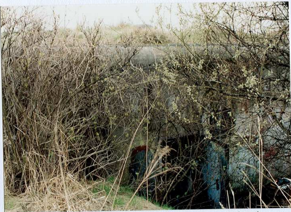
Partia wejścia. Widok od strony pd-wsch.
