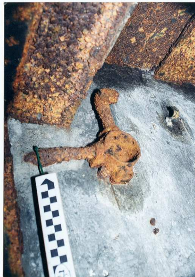
Zachowana puszka i fragmenty rurek osłonowych instalacji elektrycznej
