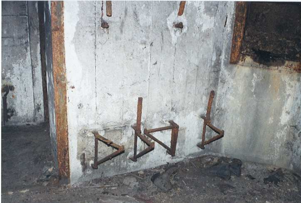
Pozostałości pótek i ławek przysięnnych, maszynownia – d
