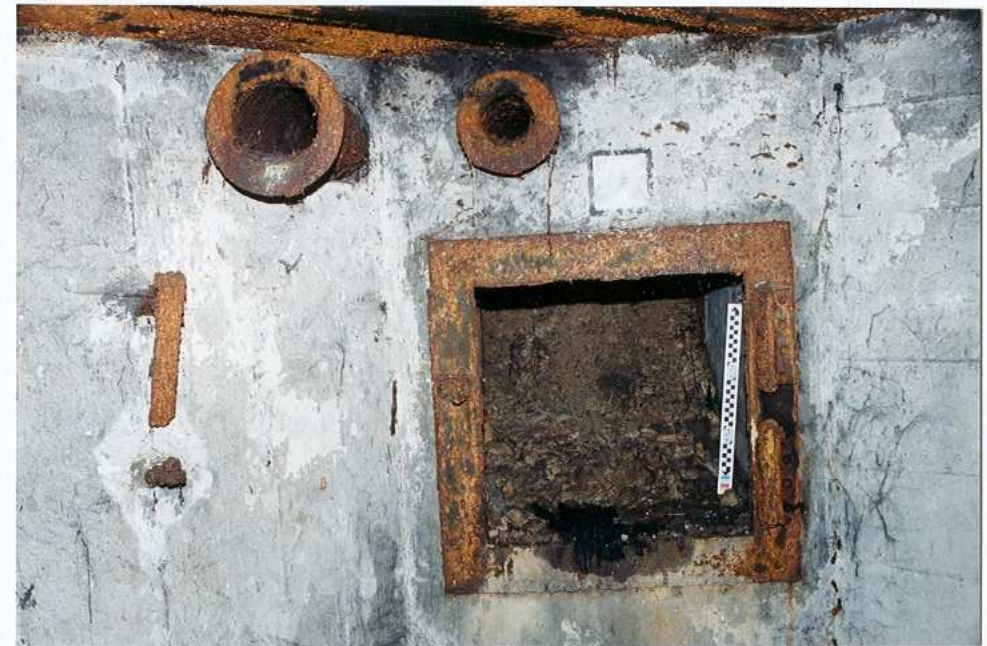
Wyjście ewakuacyjne, maszynownia -d
