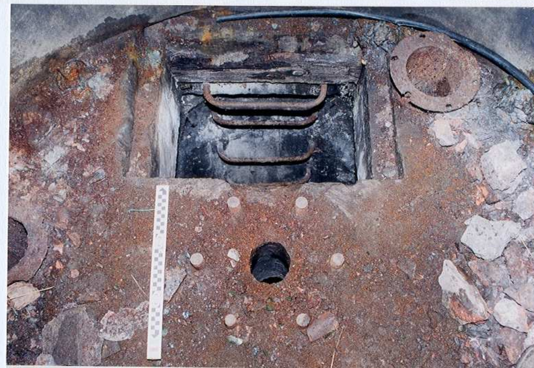
Wejście do kopuły
