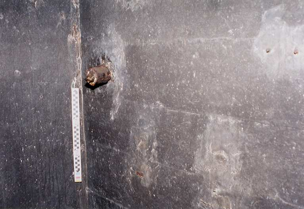
Izba dowodzenia – h, rura głosowa łącz. kopułę i ślady mocowania pulpitu
