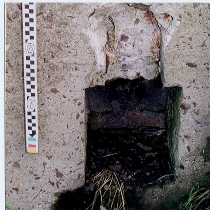
Otwór wylotowy instal. wentylacyjnej, osłona panc.-kradzież
