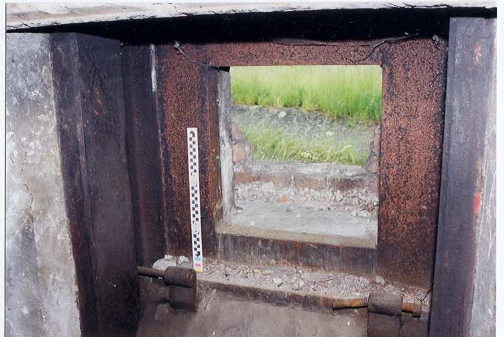
Wzmocnienia stropu, izba bojowa armaty ppanc. -g
