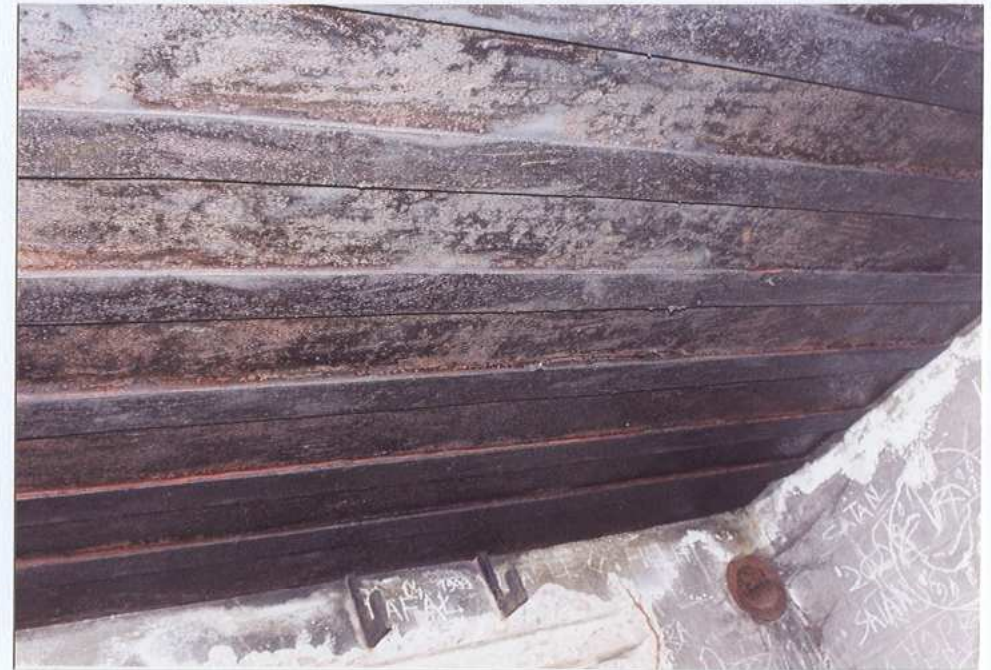
Wzmocnienia stropu, izba bojowa armaty ppanc. -g
