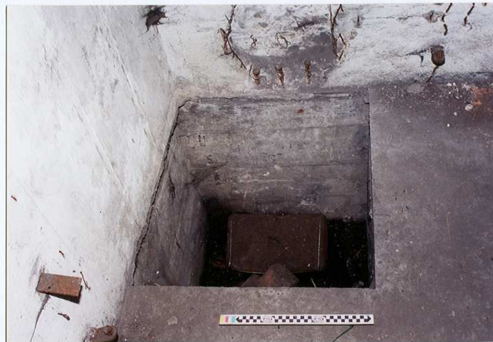
Izba dowódcy – k, posadzka – otwór studzienne odwodnieniowy
