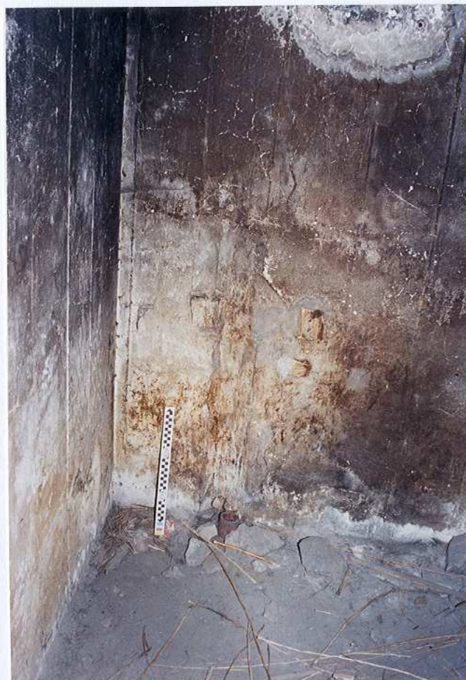
Pomieszczenie -wc, miejsce pisuaru
