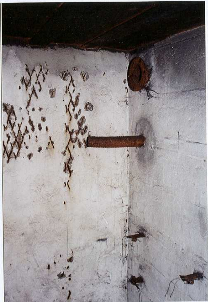
Izba dowódcy – k, rura głosowa łączości z kopułą
