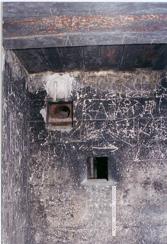
Przedsionek a, strefa wejścia ze strzelnicą i wylotem wentylacji
